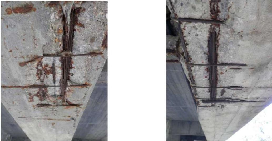
*Figura 29 Esempi di distacco del copriferro in travi in CAP soggette a corrosione*
