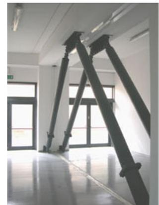
Figura 18 - Controventi dissipativi installati nel Nuovo polo didattico dell'Università Politecnica delle Marche ad Ancona.
