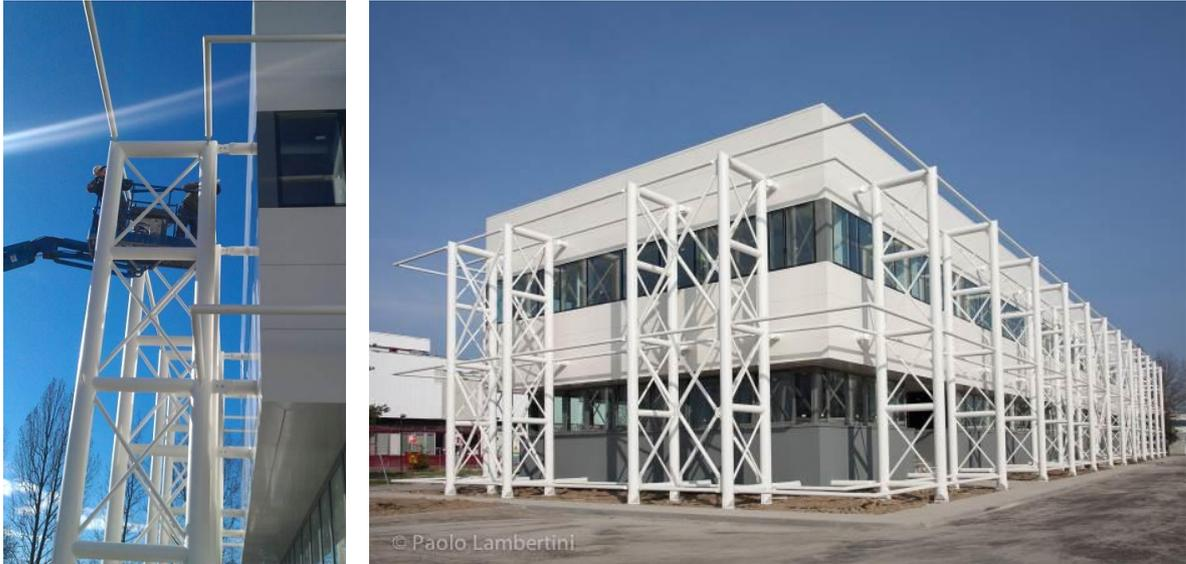
Figura 30 - Foto del progetto e della realizzazione dell'intervento di adeguamento sismico.
