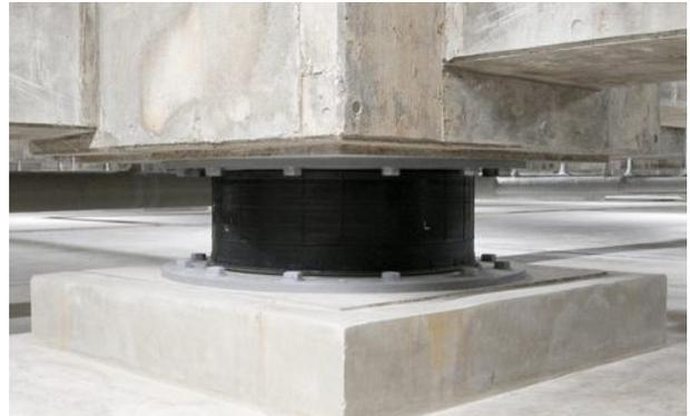
Figura 19 - Isolatore elastomerico installato come elemento di disconnessione tra fondazione e sovrastruttura.
