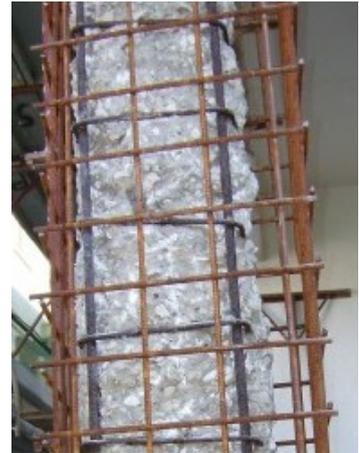
Figura 14 - Intervento di incamiciatura in calcestruzzo armato di un pilastro.
