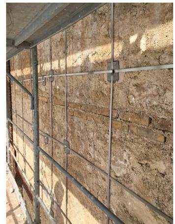
Figura 13 - Intervento di consolidamento di una muratura tramite placcaggio con nastri di acciaio (CAM<sup>®</sup>).
