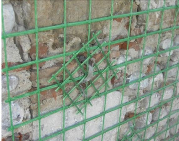
calcestruzzo armato rese solidali tra loro mediante la predisposizione di connettori trasversali. L'intervento può essere realizzato anche utilizzando intonaci strutturali a base di calce e armature in fibra di vetro;
