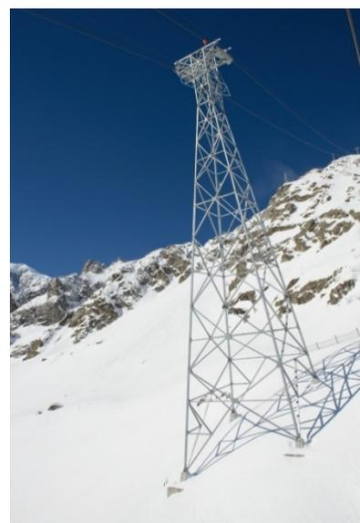
*Fig. 6-13 - Uno dei sostegni in linea dell'impianto Skyway Monte Bianco, di altezza 100m.*
