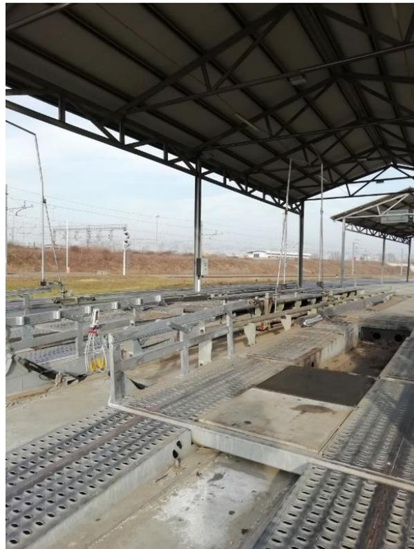
Figura 43: Dispositivo per la verifica della massa e del gabarit del mezzo in ingresso (fonte: Sopralluogo del 15-01-2020)
