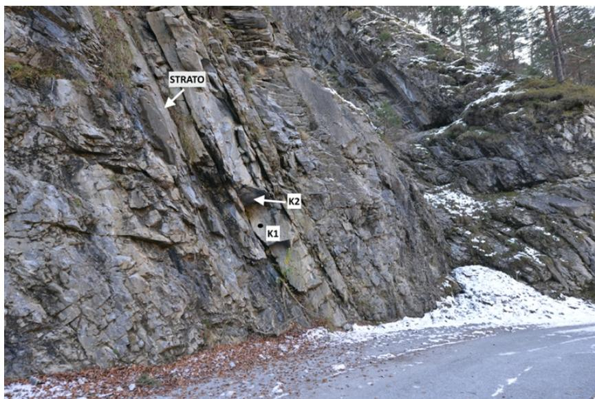
**PRESENZA** di scivolamento planare. Lo scivolamento avviene lungo il piano di STRATO.
