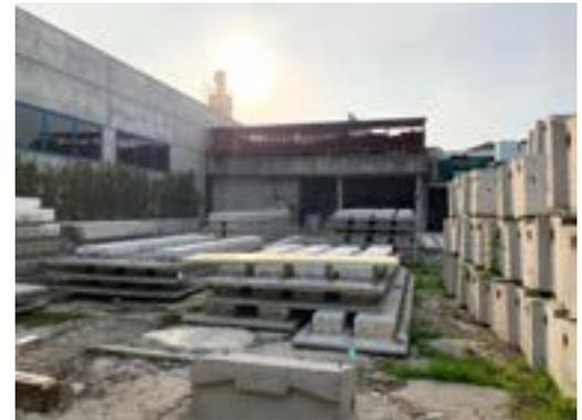
Fig 5\_3. Solaio Predalles depositato all'esterno con interposizione blocchi EPS
