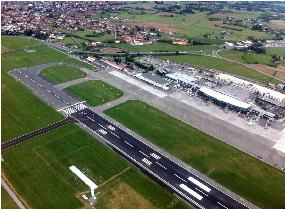
Figura 28, Espansione edifici aerostazione, crescita abitato di Caselle, Google, Data SIO, NOAA, US Navy, GEBCO, Landsat/Copernicus, datata 2017
