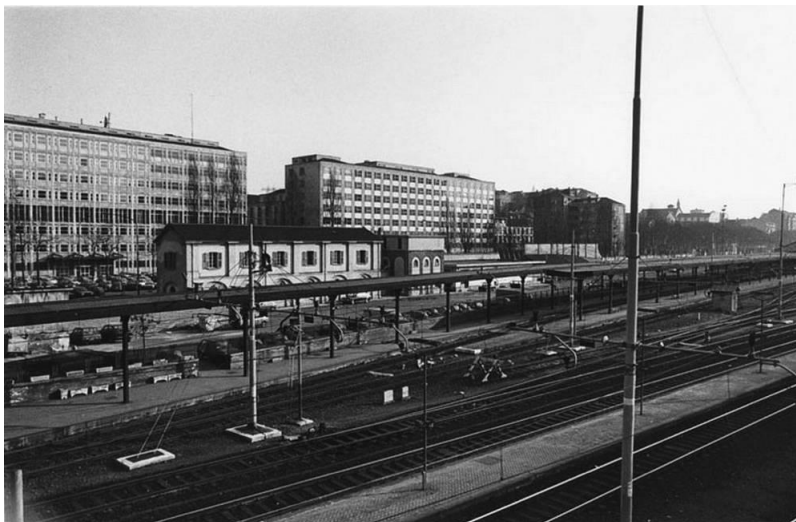
Figura 22, Edifici servizio vecchia stazione Porta Susa, Archivio Storico Città Torino (FT 13B19_050), datata 1970
