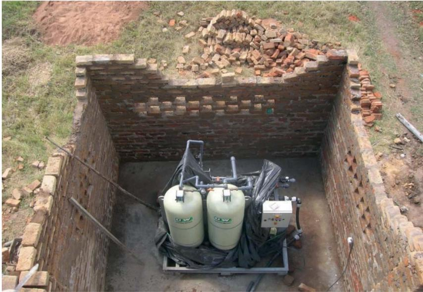
Figura 32 - Costruzione del ricovero per l'impianto di depurazione dell'acqua
