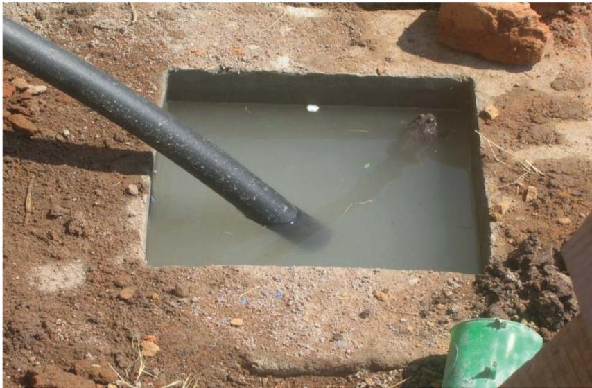
Figura 33 – Realizzazione del pozzetto di smaltimento dell'impianto di depurazione dell'acqua
