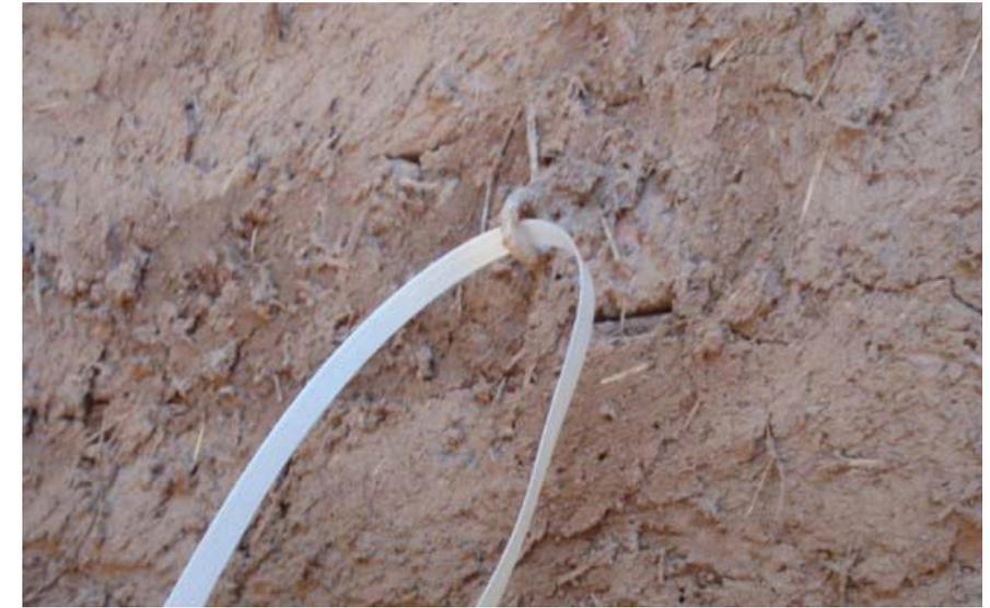
Strato di intonaco applicato muratura esistente per eliminare le discontinuità. Occhielli metallici fissati alla struttura esistente per legare le balle.
