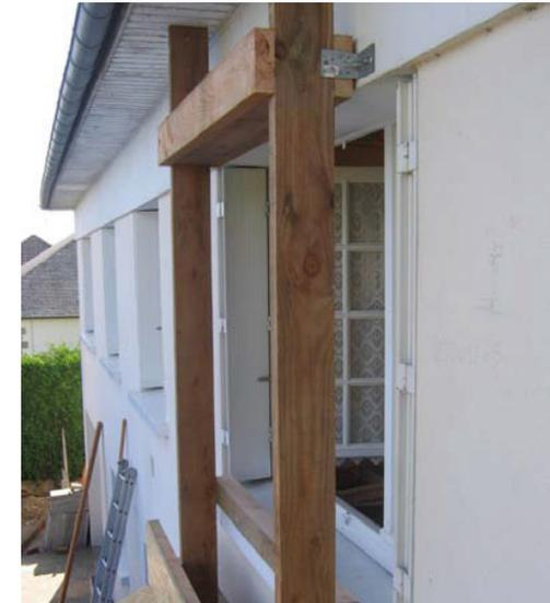
Telaio (50x150 mm) impiegato per supportare i nuovi serramenti.
