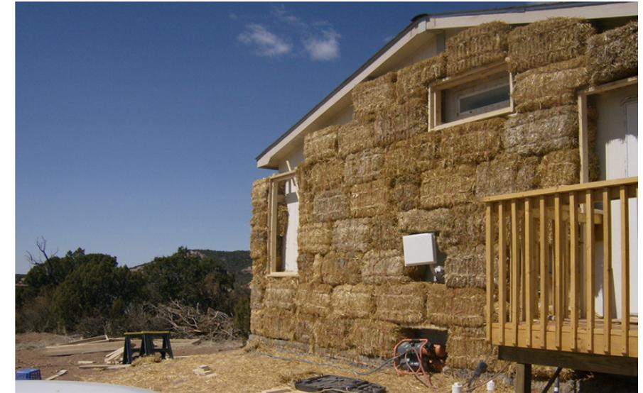
Balle fissate alla struttura della casa tramite delle cinghie metalliche.
