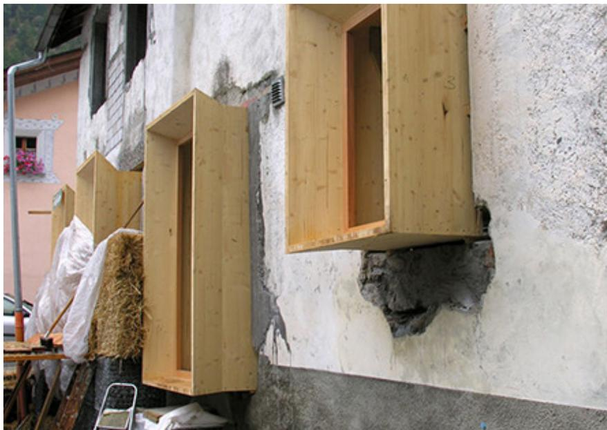
Telai delle finestre rastremati verso l'esterno per ovviare al problema della scarsa penetrazione solare.
