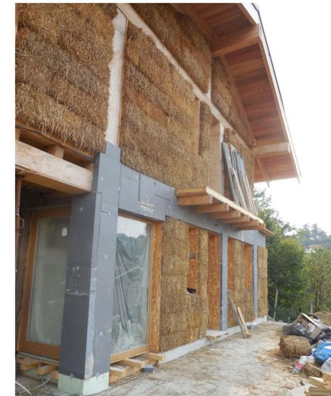
Struttura ricoperta da materiale isolante per evitare la formazione di ponti termici dovuti alla presenza di c.a.
