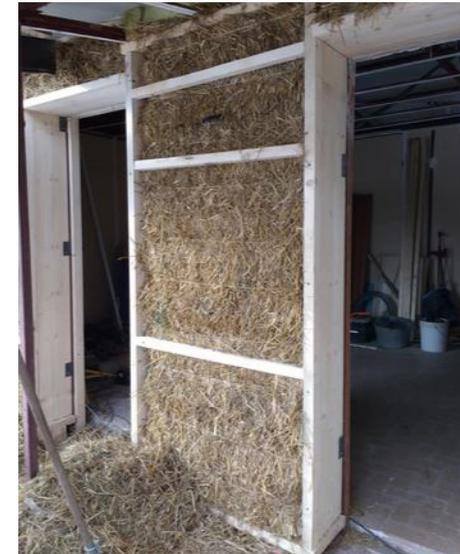
Paglia inserita all'interno di un telaio in legno, a sua volta bullonato alla struttura esistente tramite piastre metalliche.
