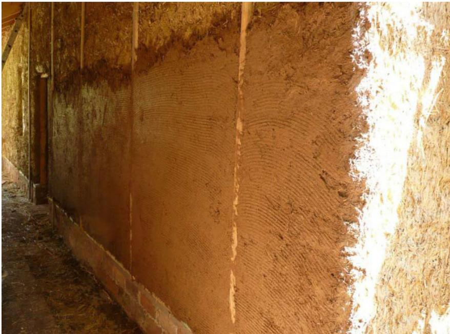
Intonaco in terra (spessore circa 4 cm) steso direttamente sulle balle.
