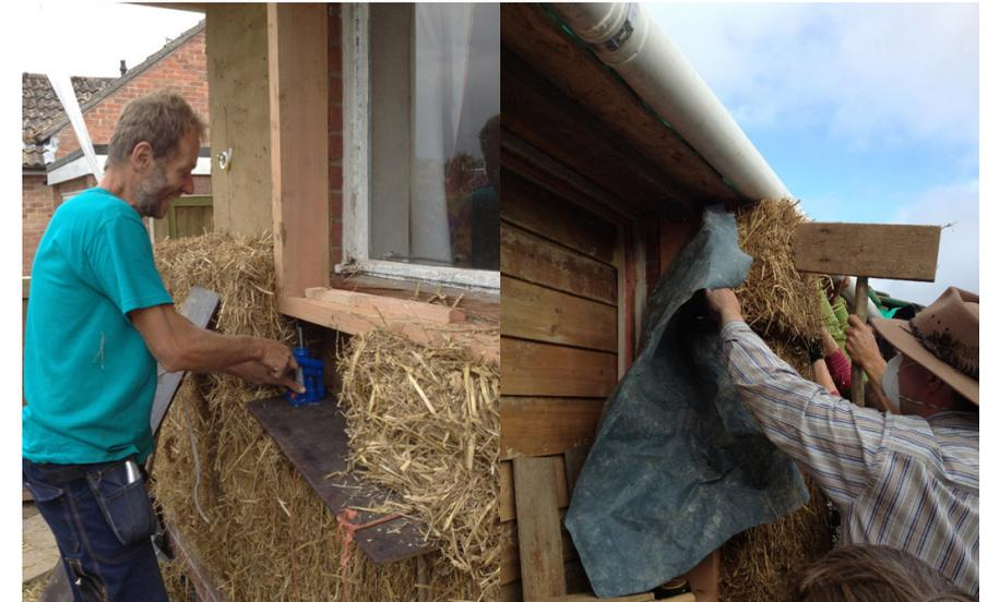
Penultimo corso di balle compresso con martinetti idraulici e piastra d'acciaio per adattare l'ultimo corso di balle.
