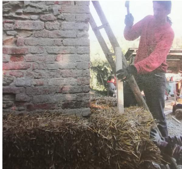
Picchetti in legno di sezione quadrata (4x4 cm) e di un metro di lunghezza utilizzati per il fissare i corsi di balle superiori al terzo.
