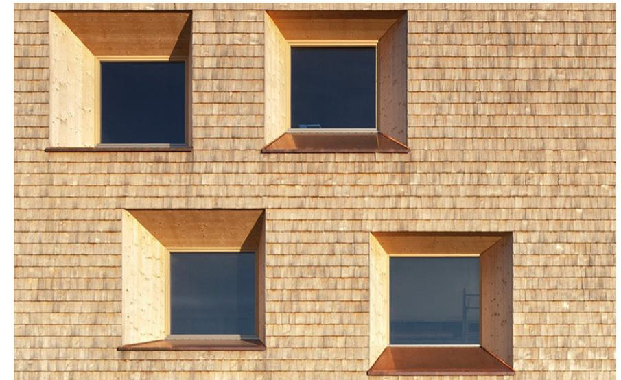
Rivestimento in scandole lignee ancorato ad una struttura di supporto costituita da listelli in legno a loro volta ancorati ad uno strato di OSB che riveste le balle di paglia.
