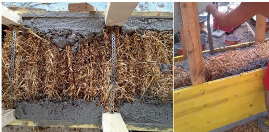
Fig. 80 Sistema GREB: il posizionamento delle casseformi e la colata di malta.
