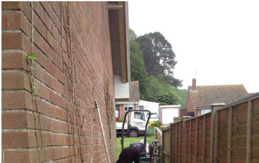
L'edificio esistente possiede già un elemento positivo: il tetto molto sporgente che permette di proteggere meglio la parete dall'acqua.
