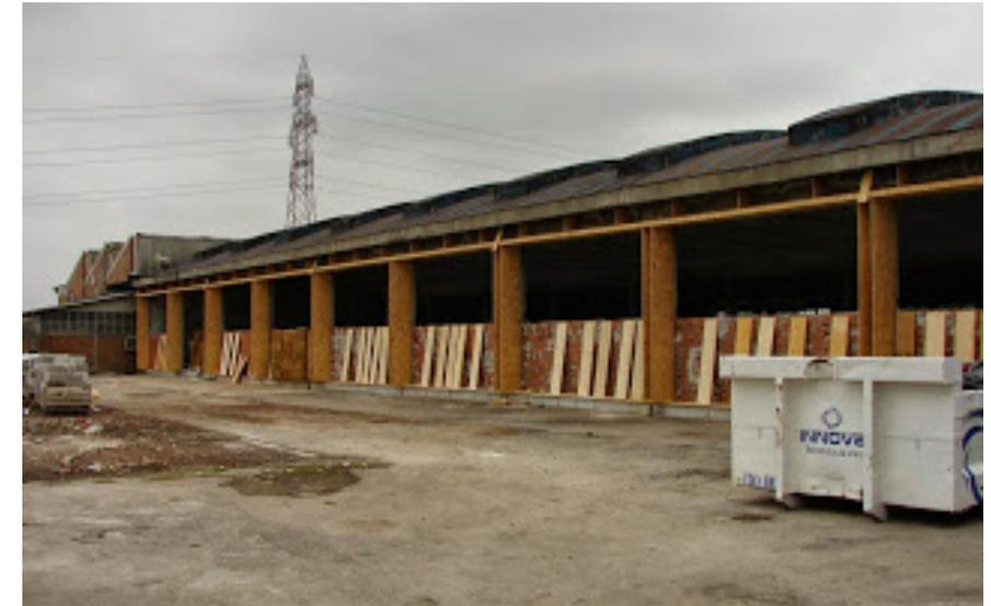
Telaio in OSB ancorato alla struttura esistente e posizionato per permettere l'alloggio delle balle di paglia.
