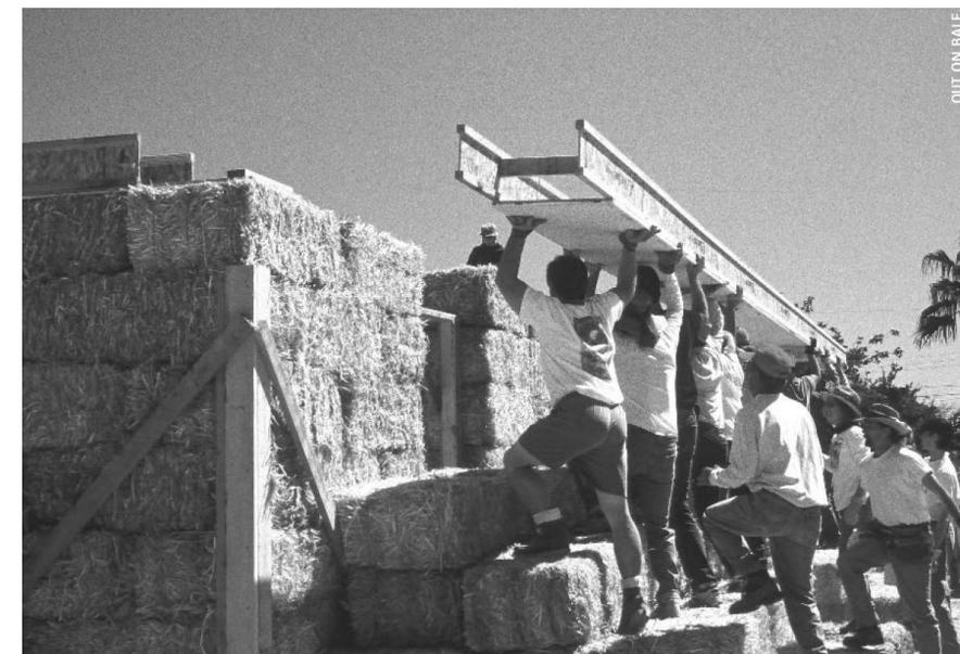
Fig. 60 Posizionamento di un cordolo a scala.
