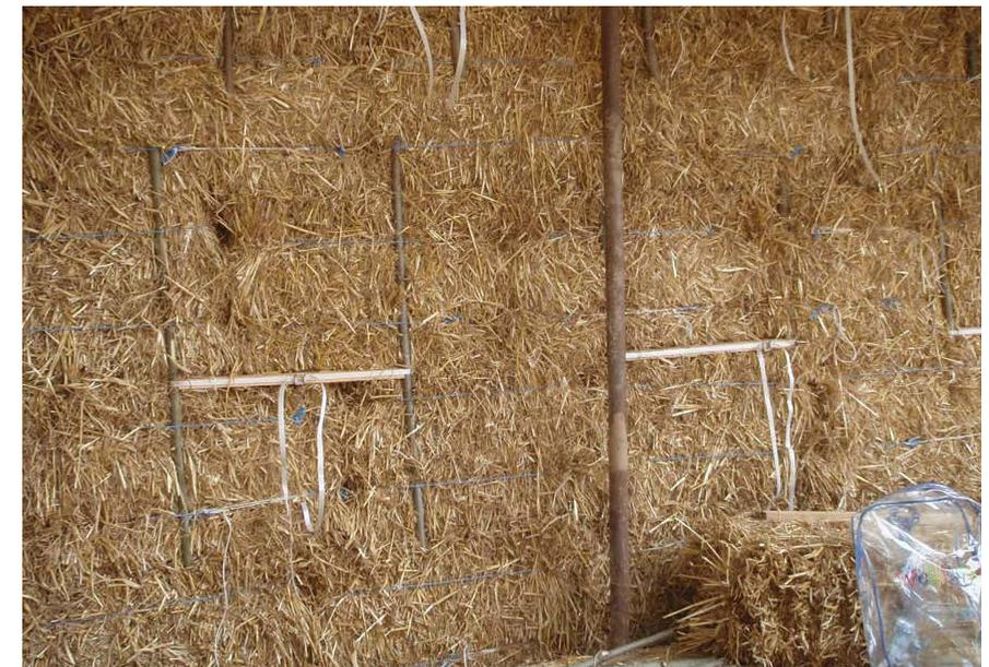
Balle legate verticalmente da sottili elementi lignei (ogni elemento copre 3 corsi di balle) a loro volta legati orizzontalmente tramite un nastro in poliestere.
