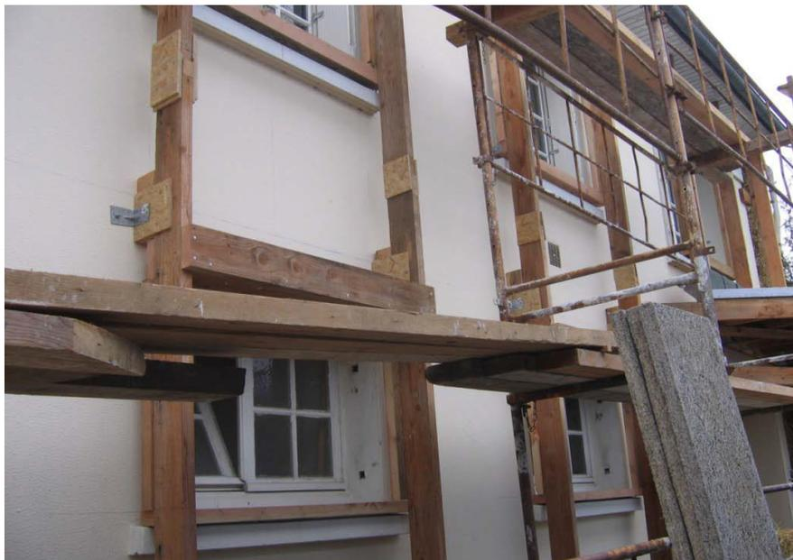
Telaio in legno (con elementi verticali distanziati da 1 a 2,8 m) fissato al basamento e alla parete esistente tramite tasselli e staffe metalliche.
