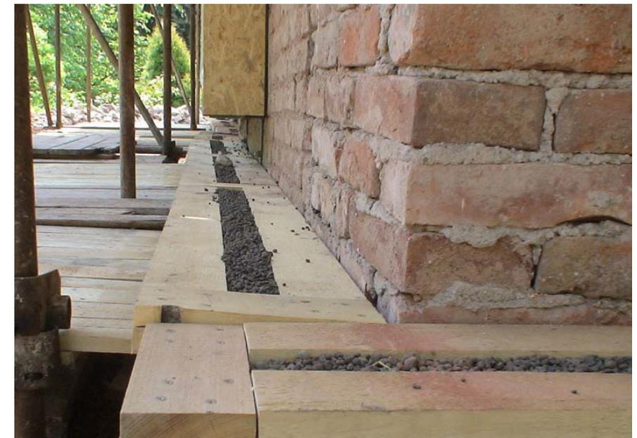
Basetta in legno composta da assi in legno assemblate e fissate tra loro con viti funge da supporto per il primo corso di balle di paglia.
