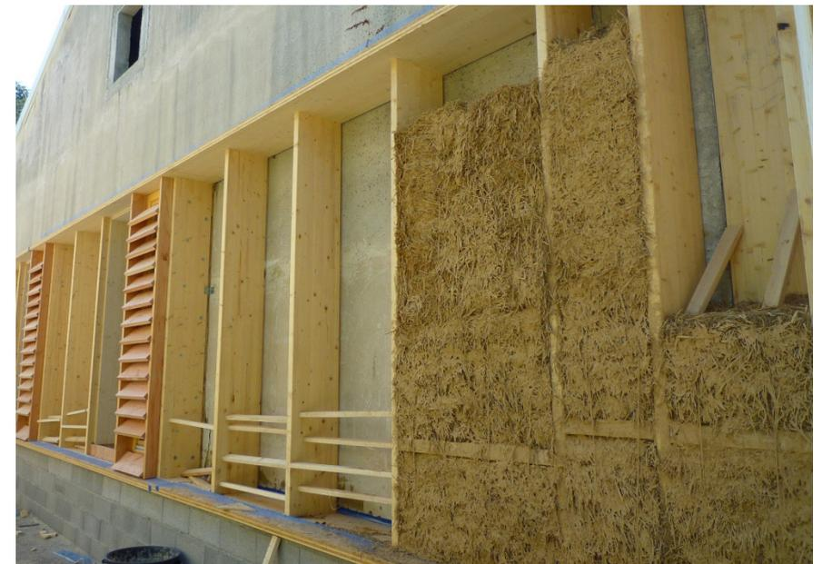
Montanti verticali disposti ad 1 m di distanza in modo da poter ospitare una balla posata di piatto o due balle posate di coltello.
