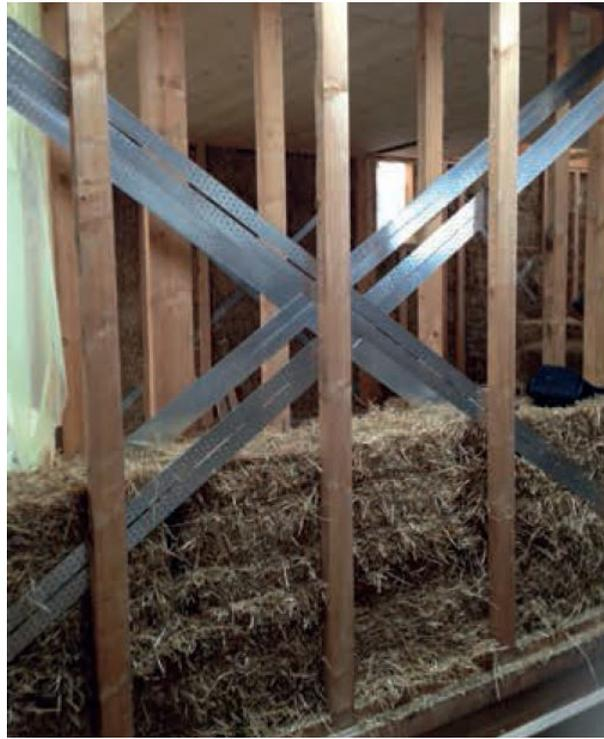
Fig. 79 Sistema GREB: la controventatura metallica.
