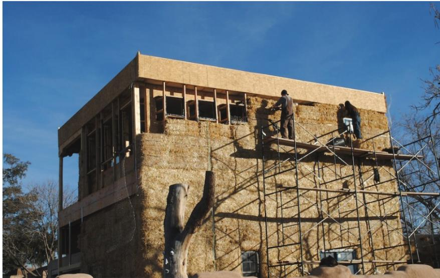
Nuovo livello costituito da una struttura in travi e pilastri (*post and beam*) tamponata da balle di paglia.
