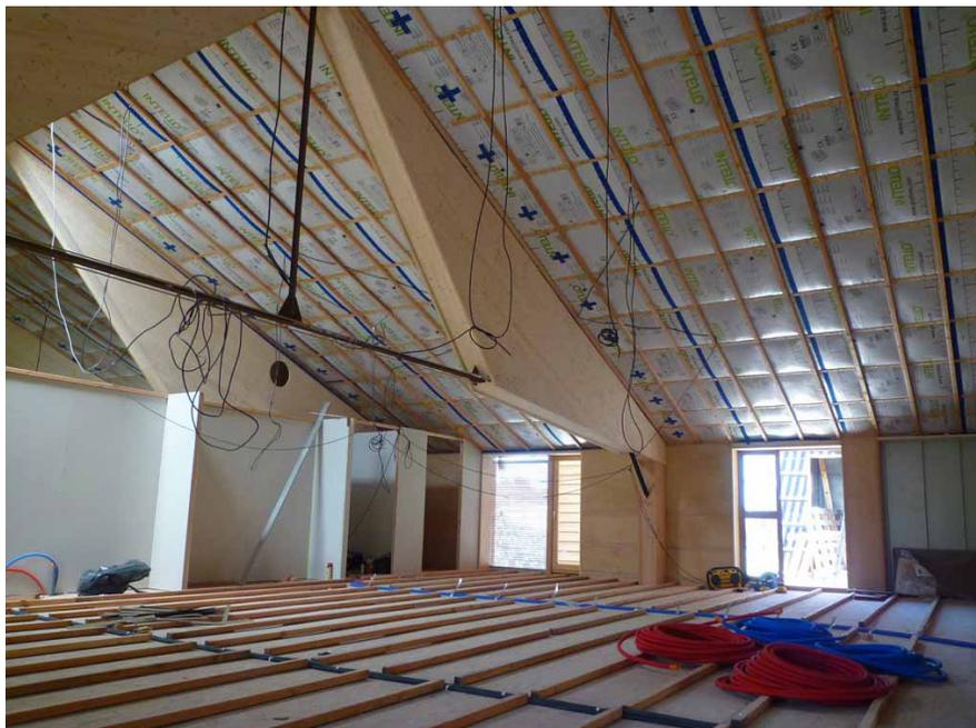
Isolamento della copertura dall'interno con 28 cm di fibra di cellulosa insufflata.
