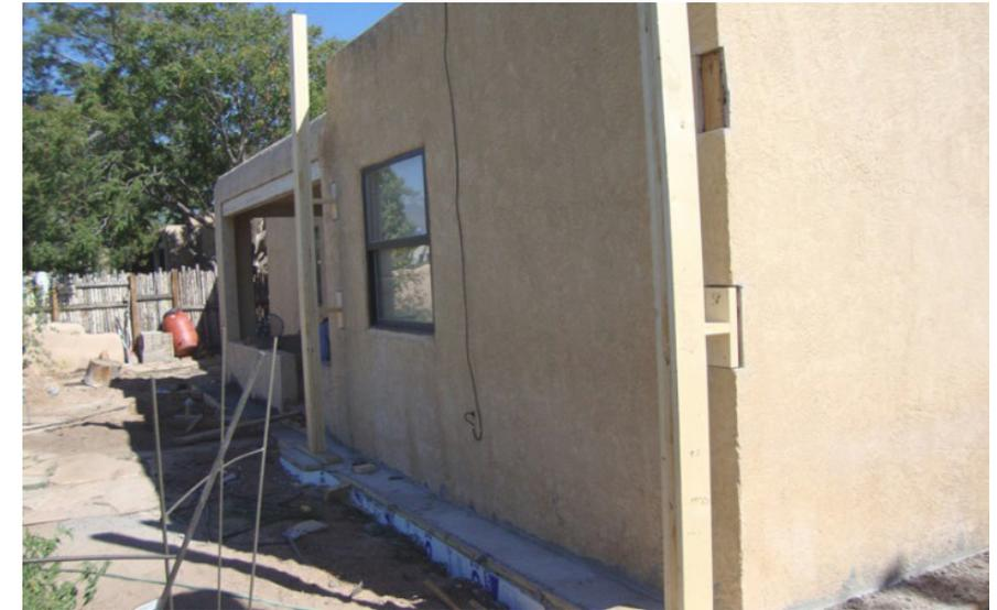
Nuovi pilastri (che dovranno scaricare il peso del piano superiore aggiunto) posizionati e ancorati saldamente al terreno.
