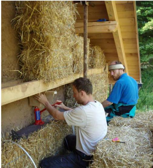
Balle di paglia compresse attraverso l'impiego di martinetti idraulici.
