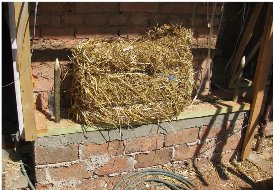
Sottili elementi verticali in legno fissati alla basetta per facilitare il posizionamento del primo corso di balle di paglia (spesse 27 cm).
