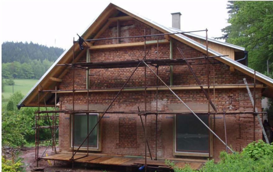
Elementi orizzontali in legno fissati su tutti e quattro i lati dell'edificio per permettere, successivamente, la compressione delle balle di paglia.
