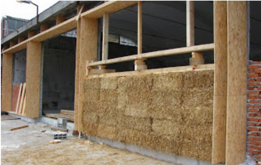
Balle compresse con martinetti idraulici da 2000 kg.
