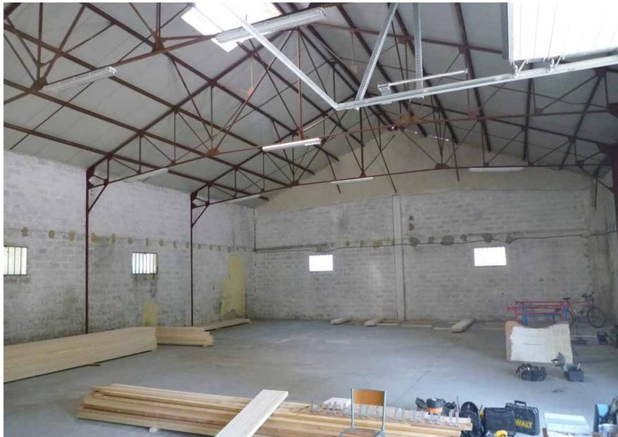
La struttura esistente da rinforzare in modo da poter sostenere il peso del cappotto interno che verrà applicato per isolare la copertura.
