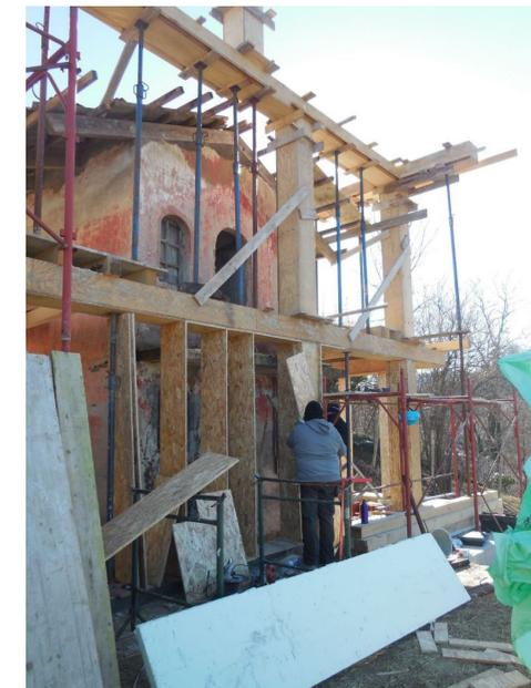
Struttura in c.a. ricoperta da pannelli in compensato marino. Degli elementi verticali in OSB sono stati posizionati tra un pilastro e l'altro per poter inserire le balle.
