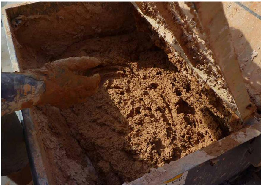
Intonaco esterno composto da terra, fibre vegetali e laterizi polverizzati applicato direttamente sulle balle di paglia.
