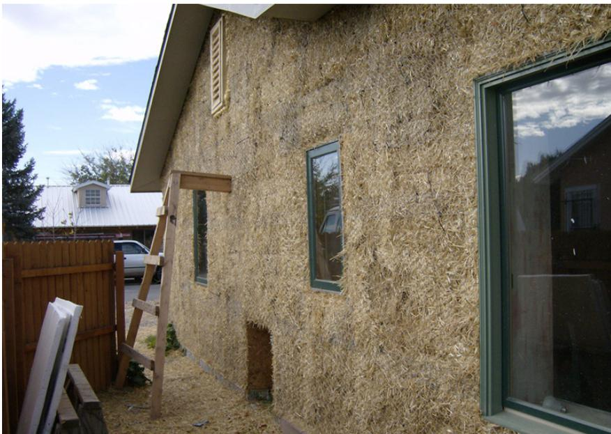
Rete portaintonaco metallica ancorata con fascette in plastica ai fili di legatura delle balle di paglia per permettere una migliore adesione dell'intonaco.
