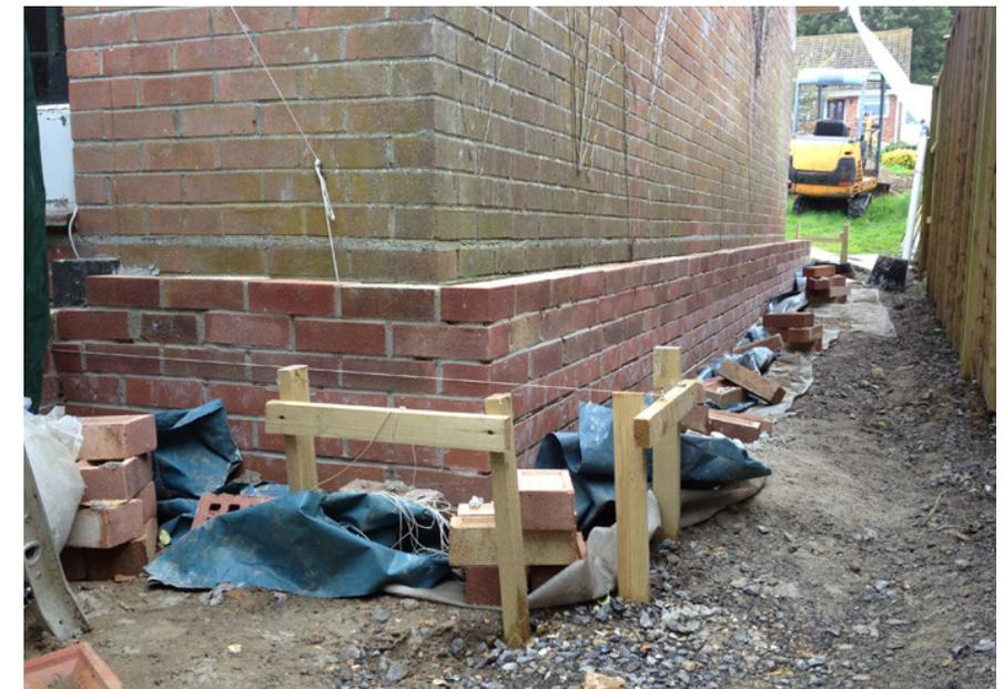
Muro di mattoni per sollevare le balle dal terreno al fine di evitare il contatto con l'umidità del terreno e con gli schizzi d'acqua piovana.
