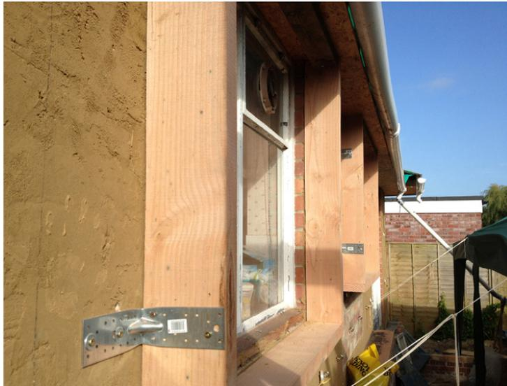
Telai in legno (abete di Douglas) ancorati alla parete esistente nei pressi delle aperture per permettere, successivamente, il fissaggio delle finestre.
