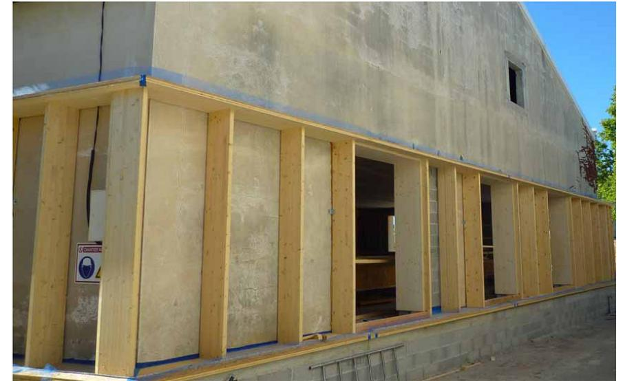
Cappotto esterno formato da una struttura in legno ancorata tramite delle staffe metalliche alla facciata esistente.
