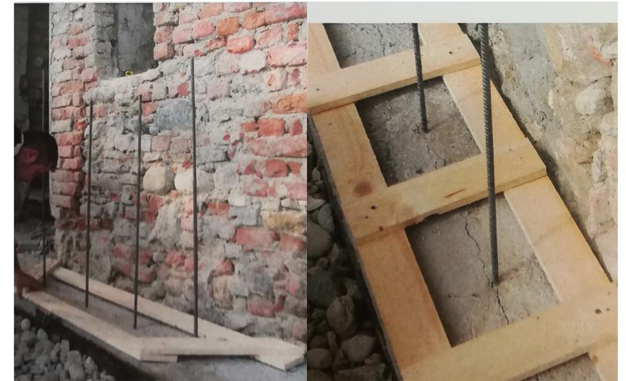
Basetta in legno impiegata per evitare l'appoggio diretto delle balle sul cordolo di fondazione.
