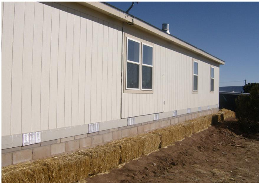
Strato di materiale isolante rigido (spessore di 5 cm) posizionato tra il basamento e il primo corso di balle di paglia. Lo spessore del cappotto esterno è di 35 cm.
