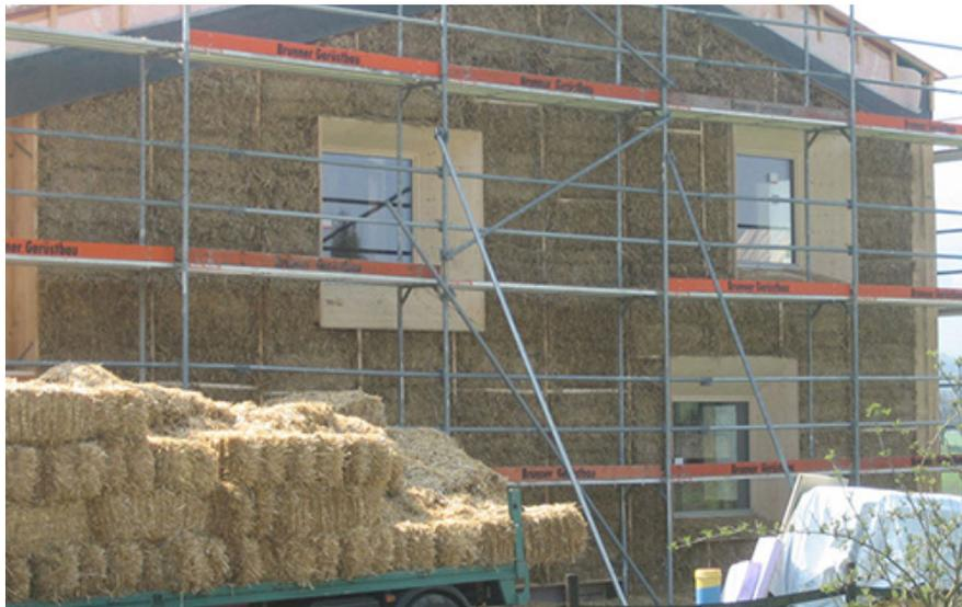
Telaio in legno (ancorato alla struttura esistente tramite tasselli e staffe angolari) ospita e tiene in compressione le balle di paglia (spessore 38 cm).
