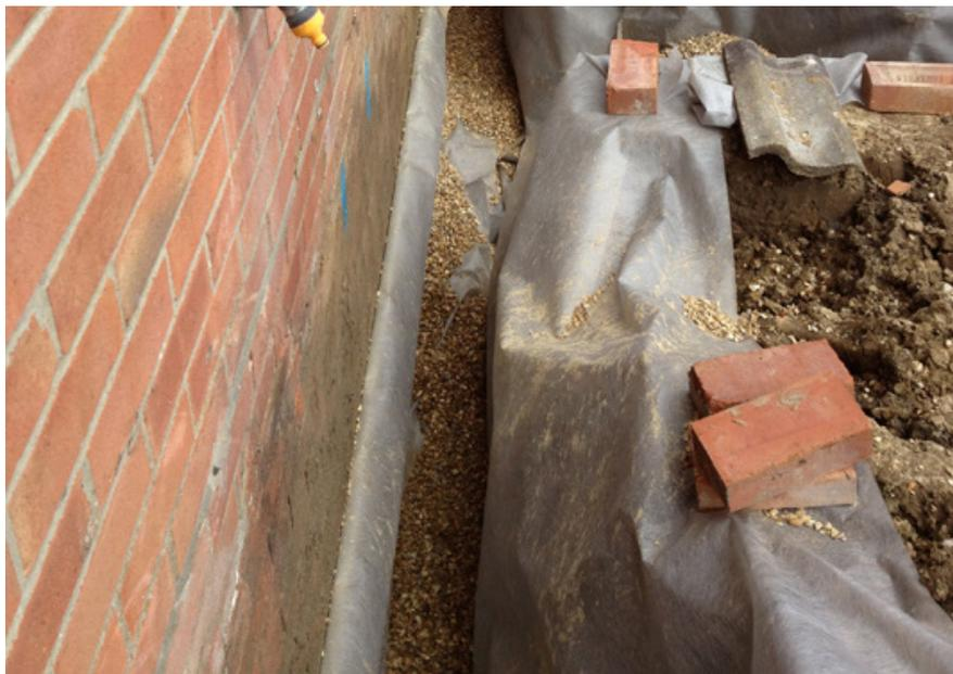
Fondazioni del cappotto rivestite con geotessile per impedire al terreno argilloso di penetrare e mescolarsi con la ghiaia.
