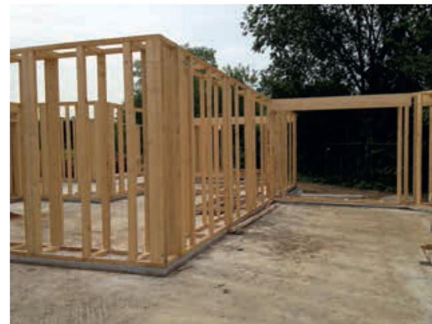
Fig. 78 Sistema GREB: la struttura in legno.
