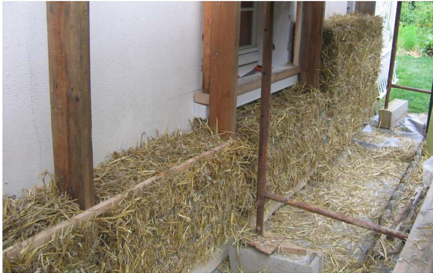
Balle di paglia ancorate tramite listelli di piccole dimensioni alla struttura principale in legno.
