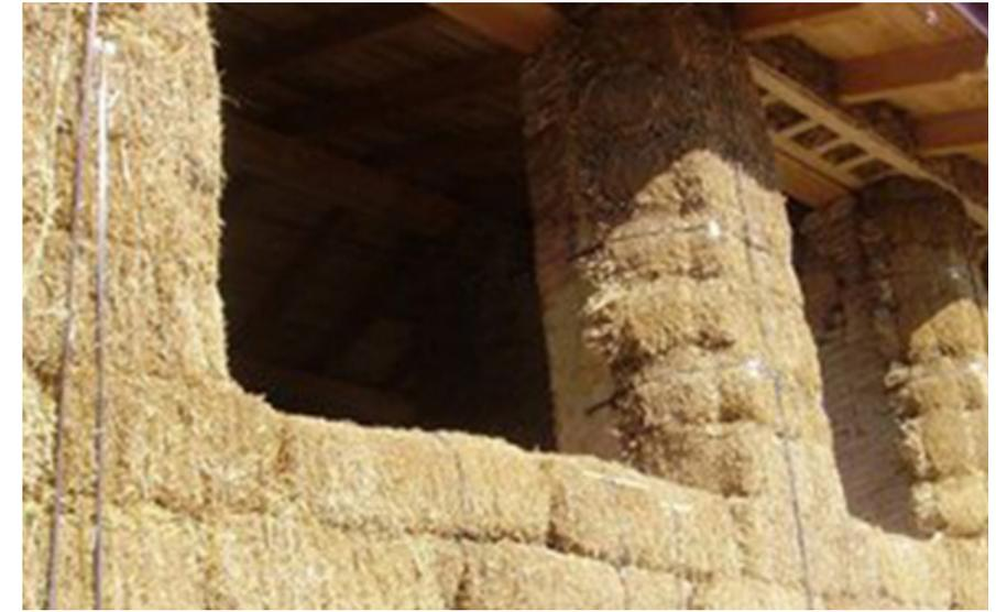
Balle ancorate al muro attraverso reggette in polipropilene fatte passare attraverso gli occhielli metallici.
