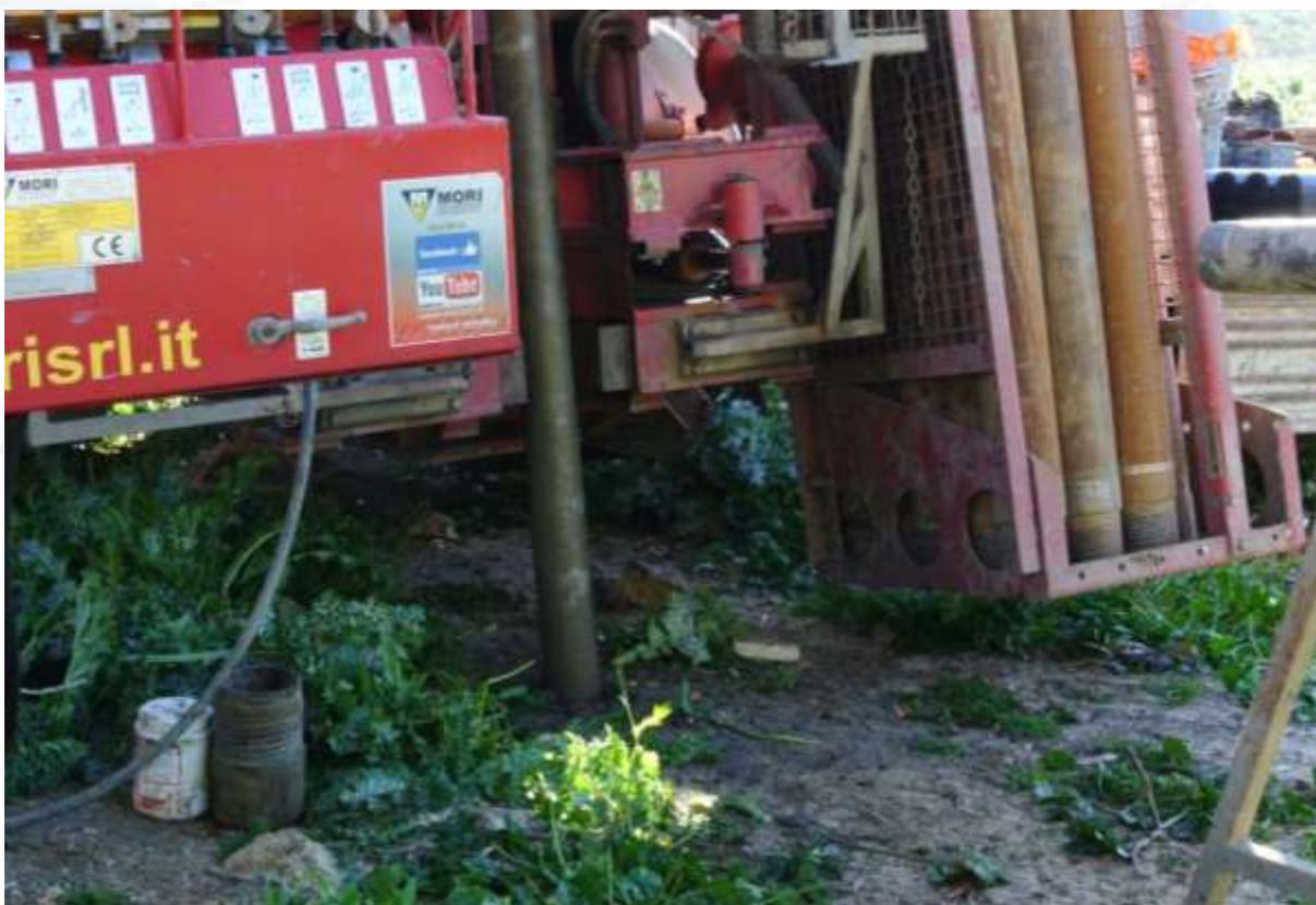
Foto in loco di sondaggio geognostico sul terreno
