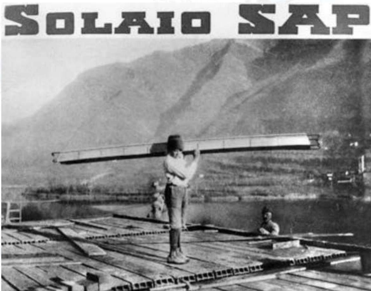
I solai realizzati all'interno della Caserma sono solai di tipo **S.A.P.** (senza armatura provvisoria). Questa tipologia di solaio è stata brevettata nel 1925 dalla R.D.B. di Piacenza, ed usata largamente fino agli anni '60.
