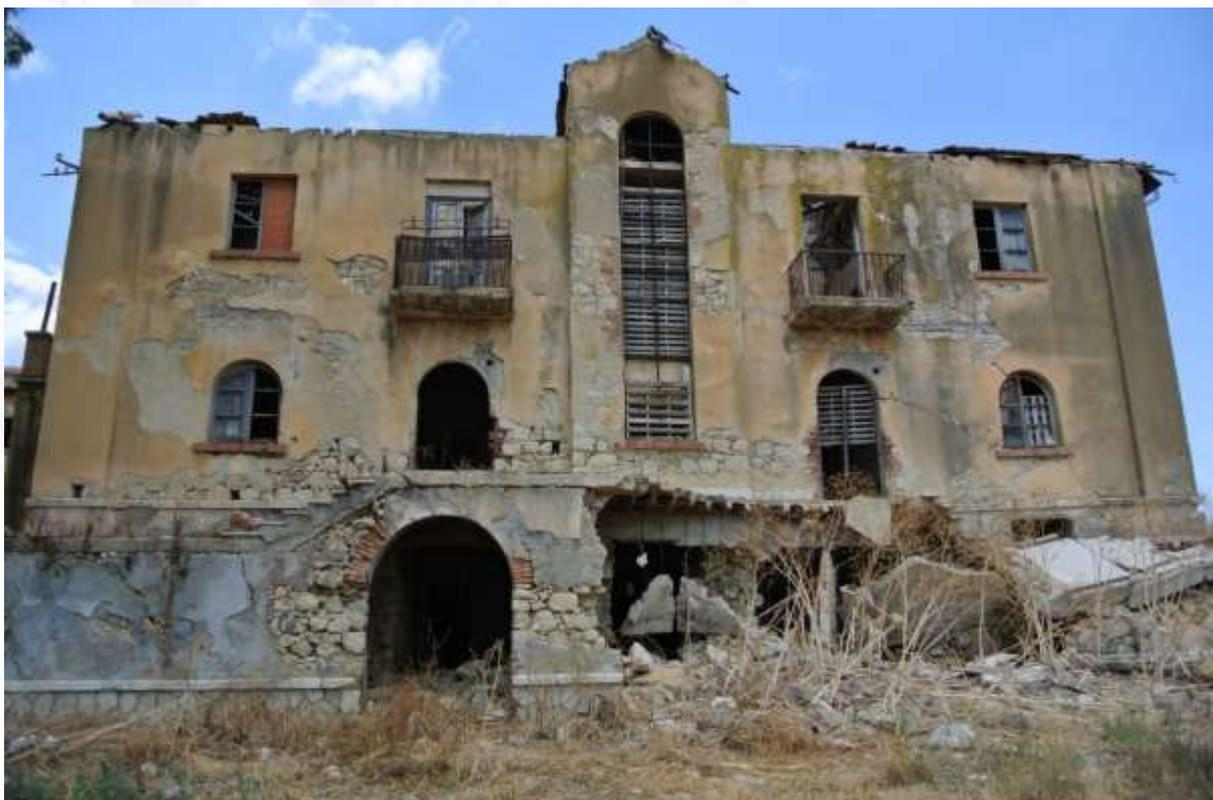
Le murature dell'ambulatorio saranno oggetto di sarcitura delle lesioni e di consolidamento con rete di materiale composito a base di fibre di vetro. Sarà riaperto un vano murato. I cordoli perimetrali del tetto saranno oggetto di opere di risanamento delle armature.
