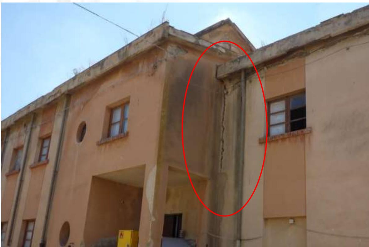
Ove sia presente una **lesione muraria** le tecniche più comunemente usate sono la chiodatura o l'imbullonatura, il cuci e scuci con mattoni pieni e il consolidamento con rete elettrosaldata o di materiale composito. La prima non potrebbe in questo caso essere efficace per la natura del muro realizzato in pietra perché i chiodi si sfilerebbero facilmente.
