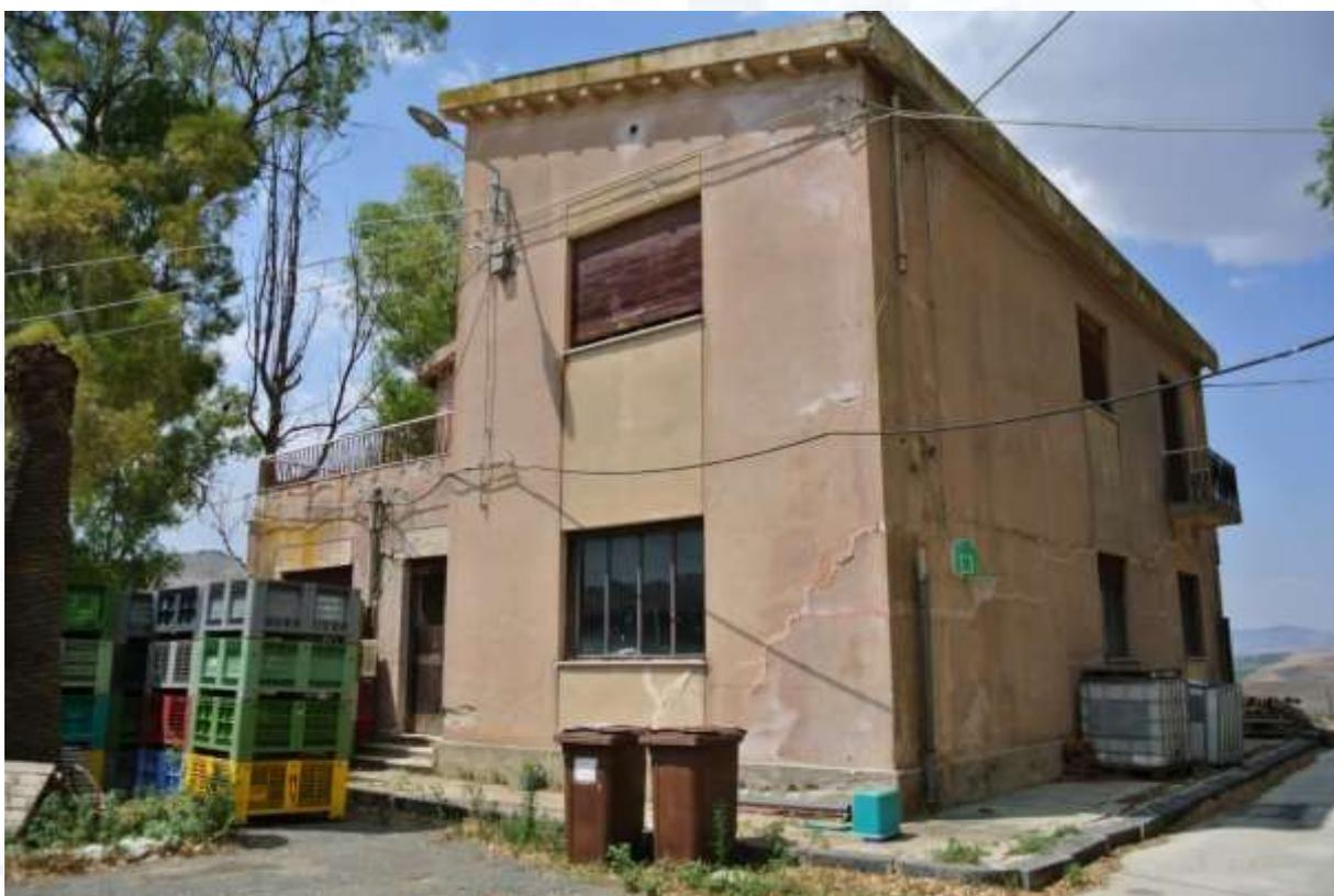
Gli infissi esterni con profilati di ferro e serrande avvolgibili saranno sostituiti con serramenti di legno come da progetto originale. Le pavimentazioni e gli intonaci interni del piano terra e quelli interessati dalle dismissioni degli infissi al primo piano saranno rifatti come gli originali.
