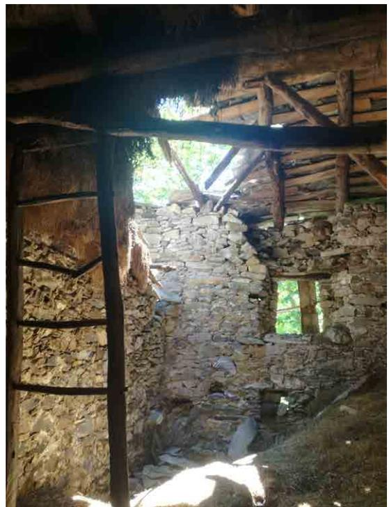
**Fig. 296** | Scala interna in legno per accedere al fienile (2019)
