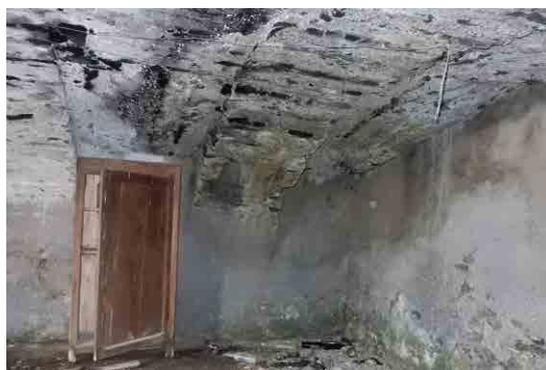
**Fig. 288** | Vano abitativo con solaio a voltino (2019)
