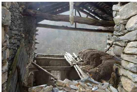
**Fig. 289** | Solaio di un fienile con travi in legno (2019)
