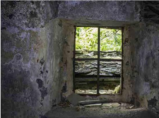
**Fig. 278** | Finestra dotata di telaio in ferro (Elena Paschetta, 2015)
