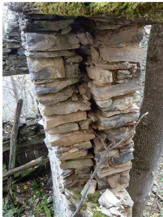
Fig. 274 | Muratura tipica caratterizzante le costruzioni di Narbona (2019)
