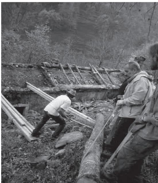
**Fig. 326** | Rimozione del colmo della cappella di Narbona (Marco Rainero, 2014)
