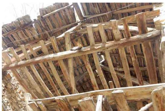
**Fig. 290** | Solaio di un fienile con travi in legno (2019)
