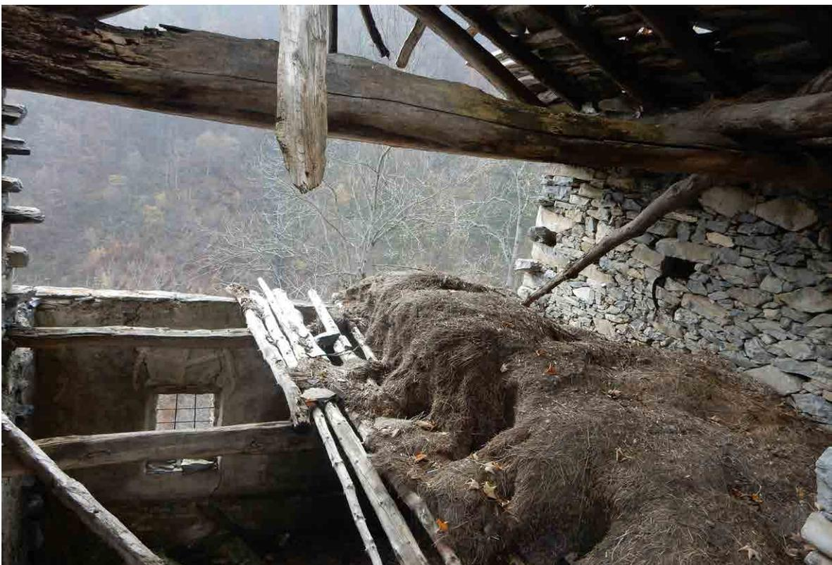
Fig. 277 | Grande colmo di larice e solaio in legno presenti in una costruzione narbonese (2019)
