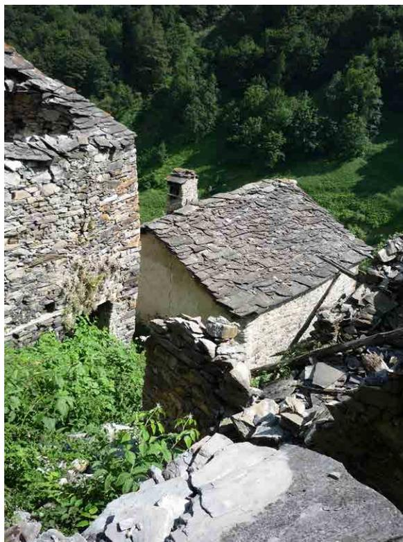
Fig. 220 | Prospetto a monte in crollo (2019)
