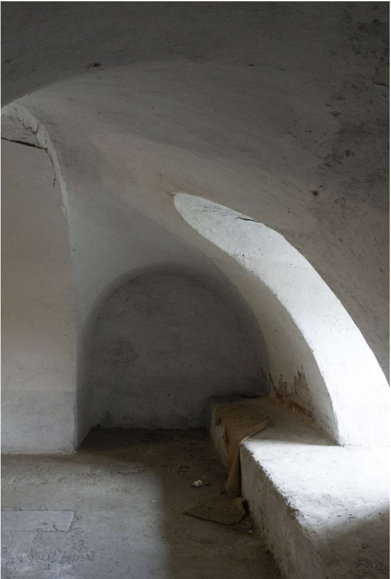
Figura 31. Volta a botte rampante con lunetta in corrispondenza della finestra, ambiente al lato del corridoio.
