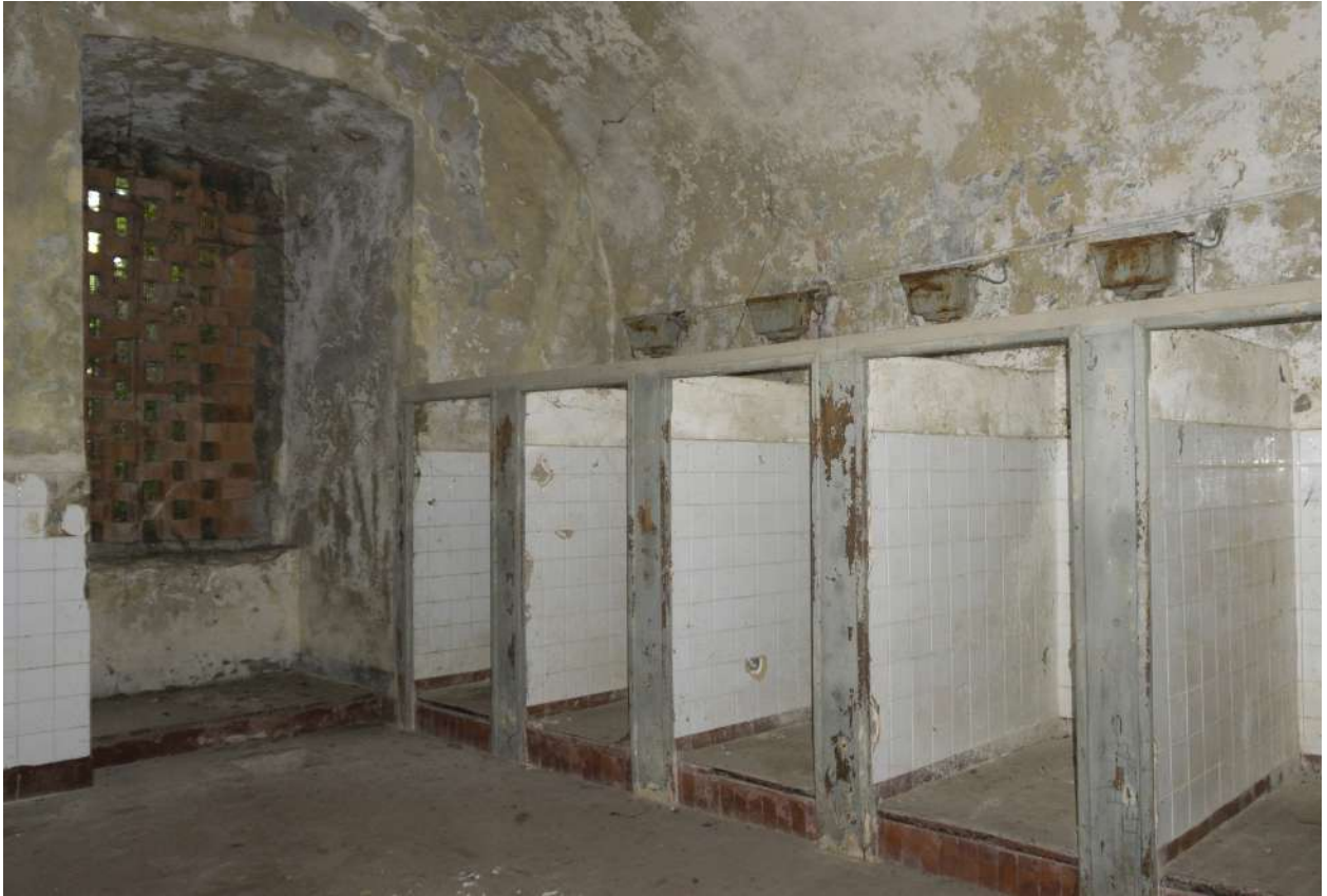
Figura 54. Posizione attuale delle latrine nel piano terra.
