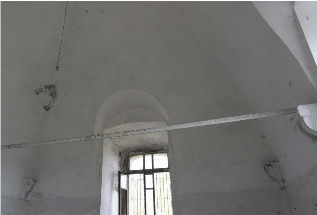
Figura 22. Camerata degli ufficiali con volta a botte lunettata e testa di padiglione.
