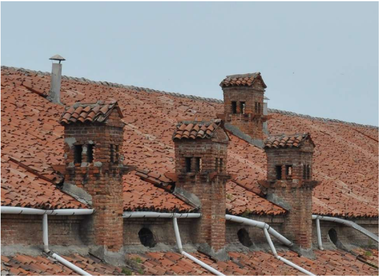
Figura 52. Spiragli e torrioni in copertura. Foto di Roberto Caterino.
