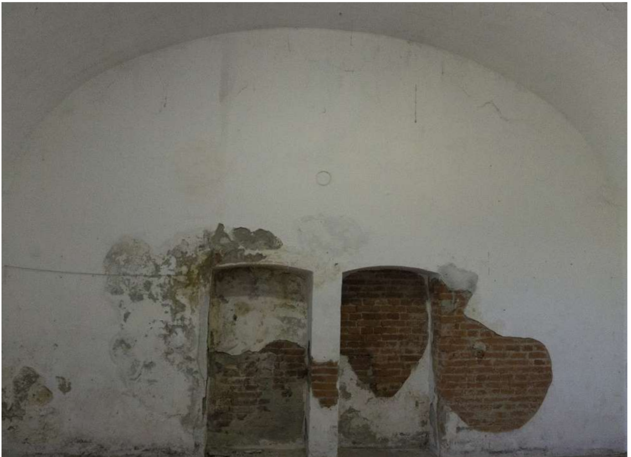
Figura 50. Bocchetta occlusa al di sopra delle nicchie.
