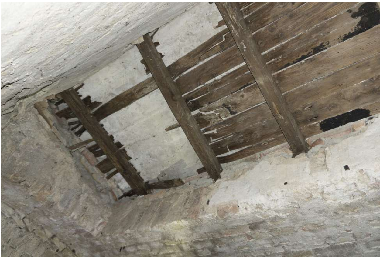
Figura 19. Apertura in corrispondenza della volta e lunetta, tramite cui è possibile ipotizzare la stratigrafia del riempimento della volta dei sotterranei.
