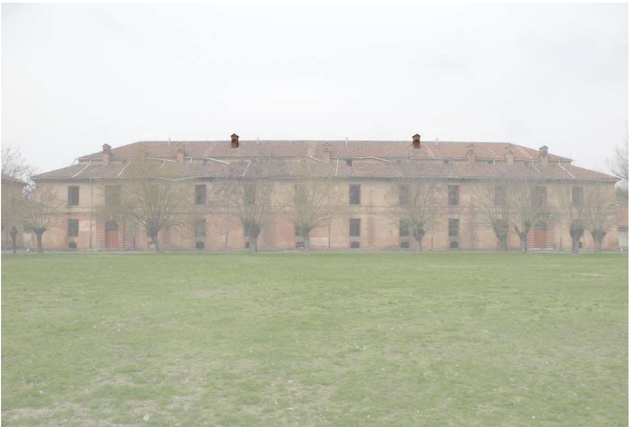
Figura 53. I due comignoli posizionati sul muro longitudinale interno, facciata est.
