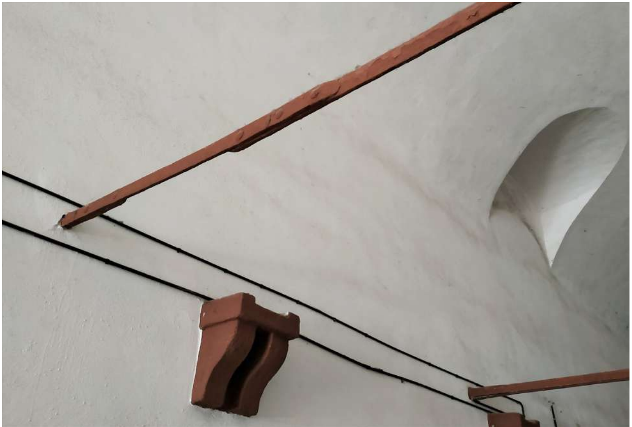
Figura 61. Dettaglio dei tre chiodi al sovrapporsi di due catene.
