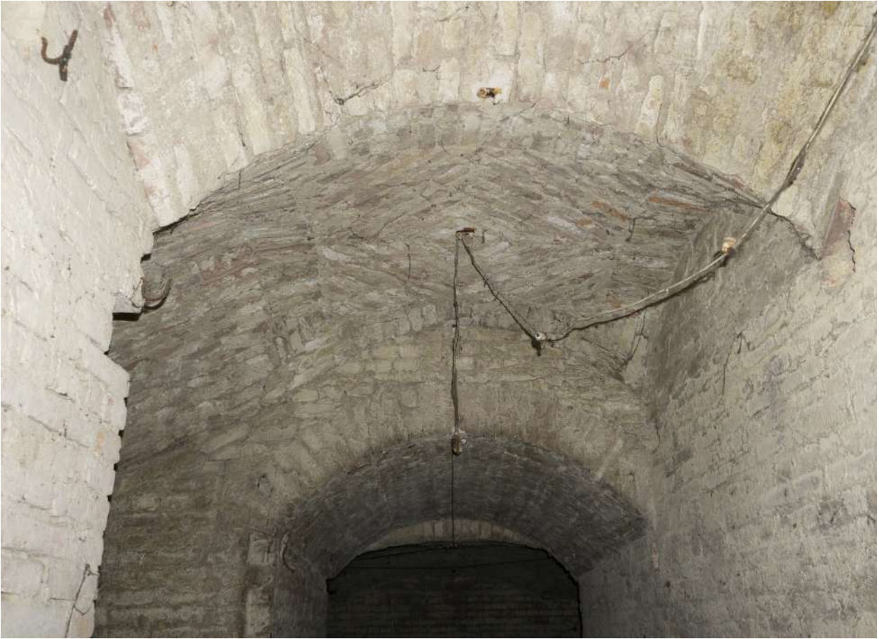
Figura 34. Volta a vela a sesto ribassato sopra i pianerottoli, piano sotterranei.
