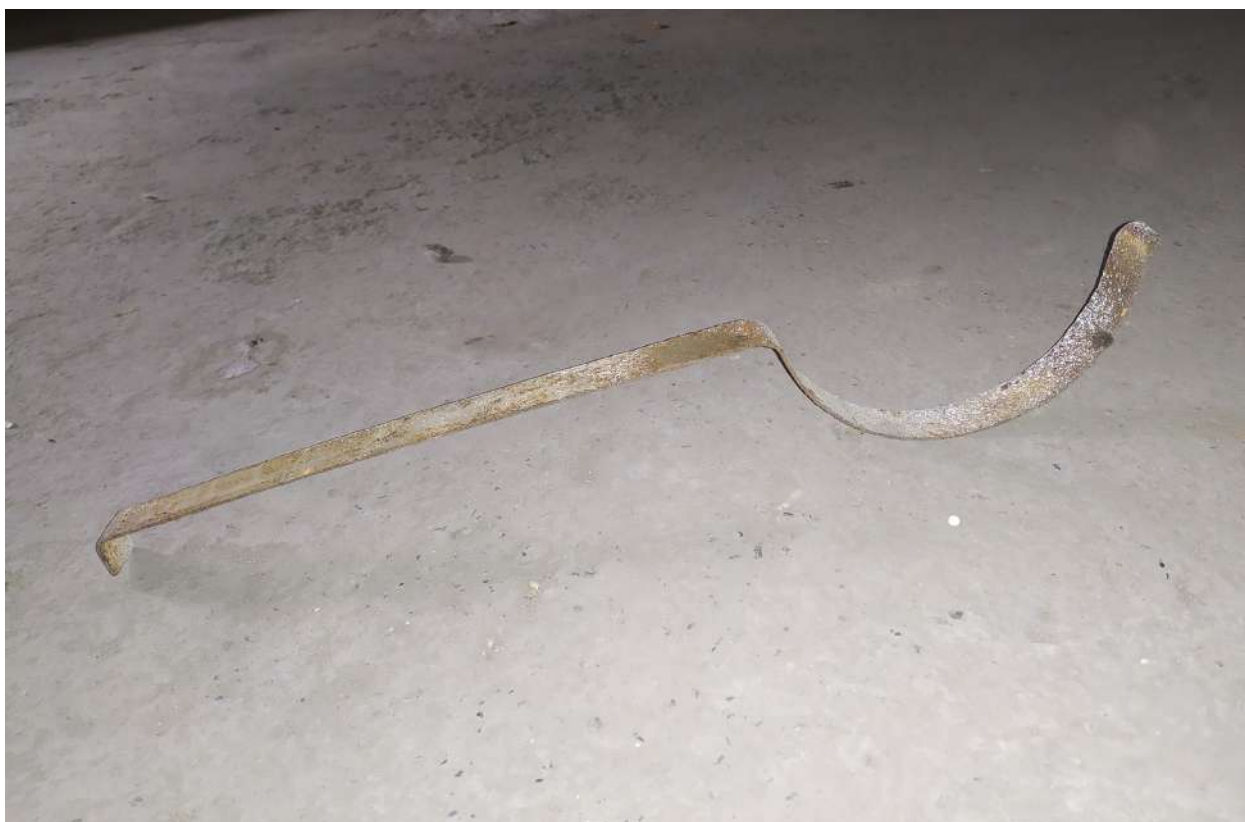
Figura 39. Uno dei rampini in ferro che sorregge i canali di gronda.
