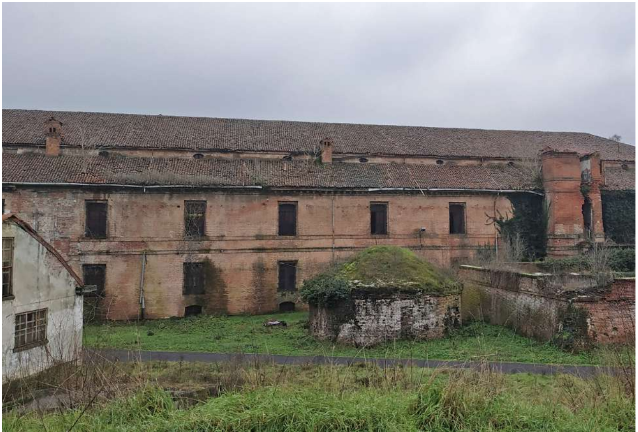
Figura 58. Prospetto ovest del quartiere San Carlo, sul lato destro persiste la torre delle latrine.
