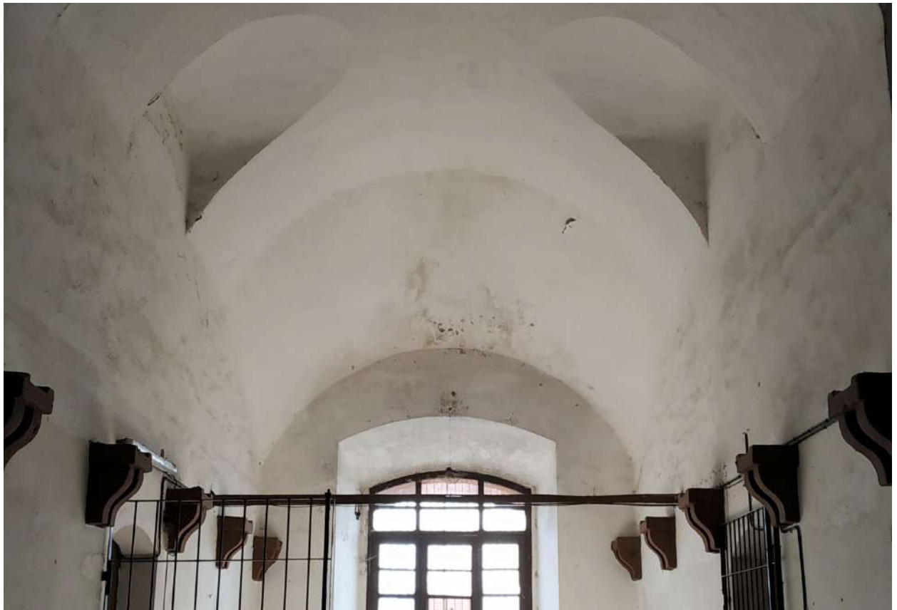
Figura 25. Corridoio longitudinale con volta a botte lunettata in corrispondenza delle porte, l'estremo del corridore termina con una volta a botte con generatrici inclinate.
