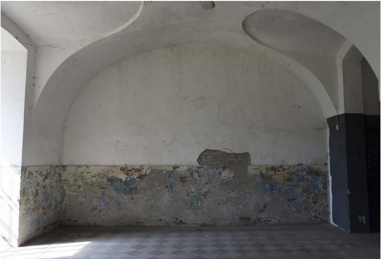
Figura 21. La volta ellittica lunettata con archi d'appoggio dei cameroni.
