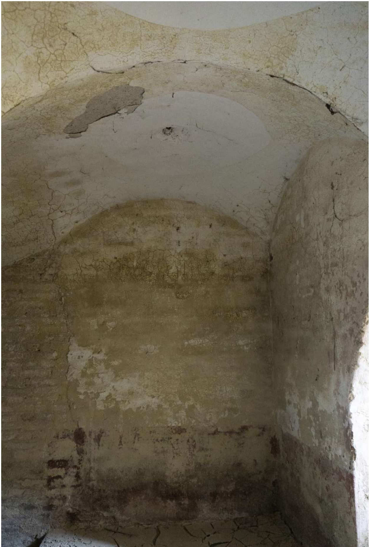
Figura 35. Volte e muraglie intonacate salendo le scale per andare al piano terra.
