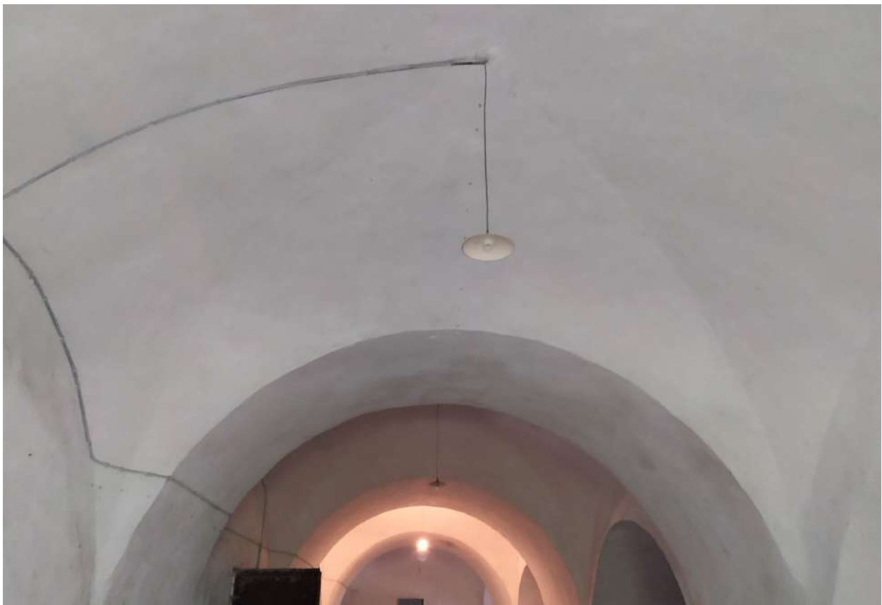
Figura 29. Volta a crociera a monta rialzata (in primo piano), con alternarsi di volte a botte per tutto il corridoio.
