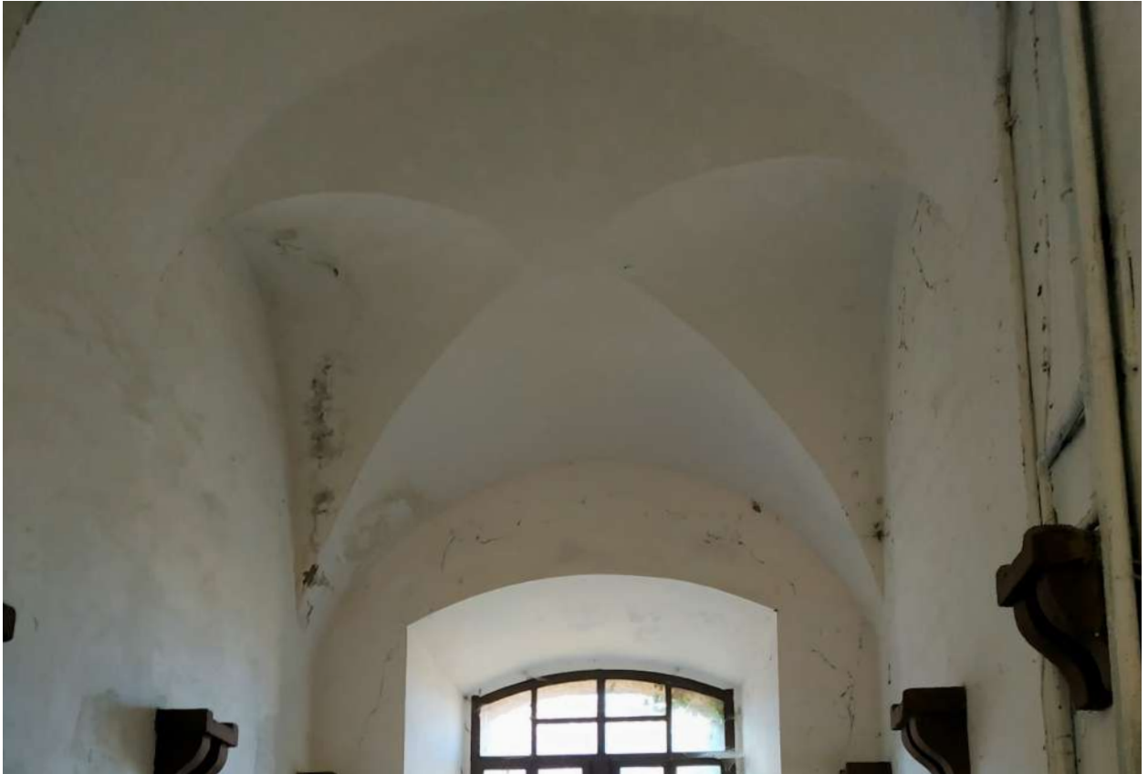
Figura 24. Volta a crociera all'estremo del corridoio trasversale.
