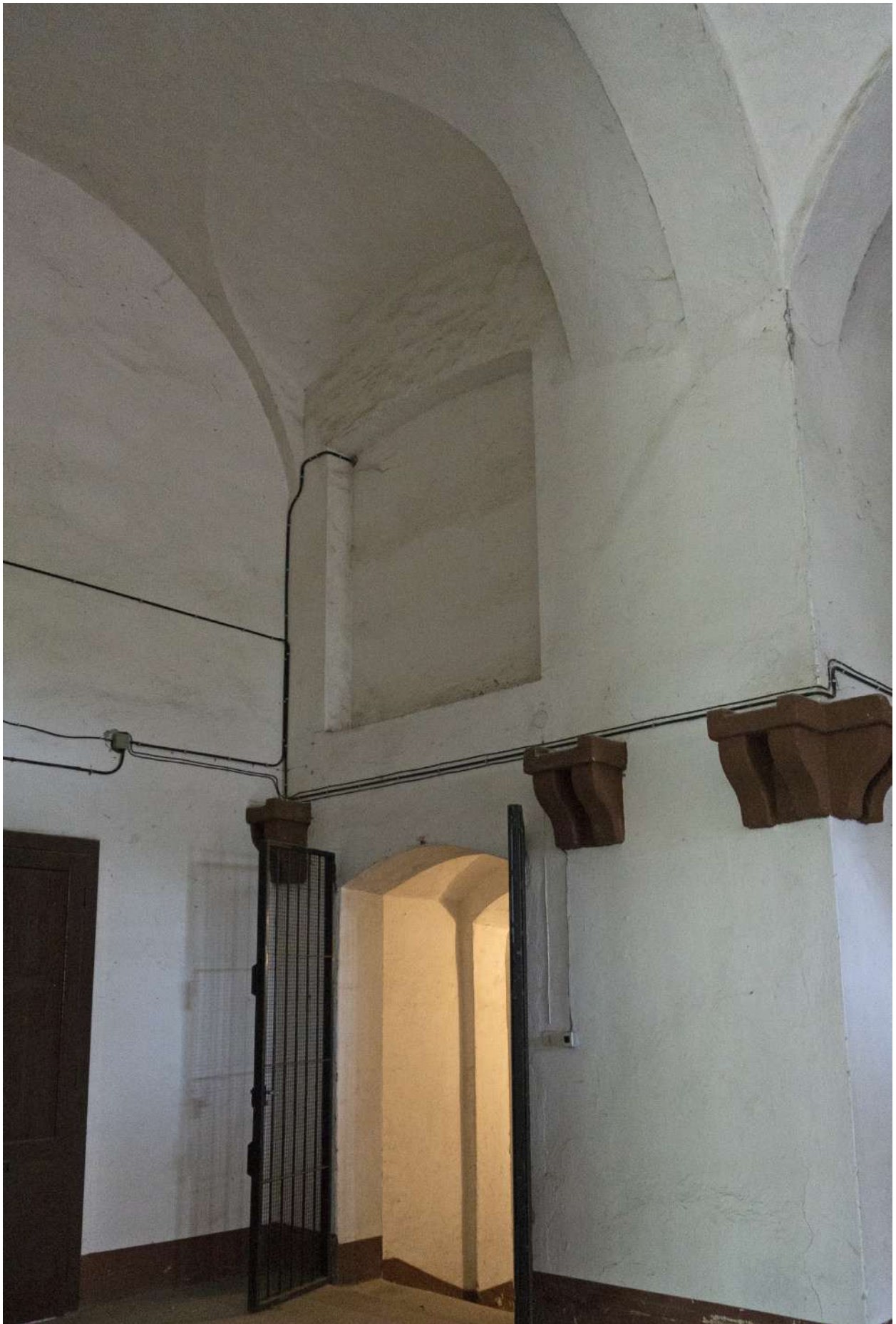
Figura 27. Sopra la porta si nota una seconda porta tamponata, probabilmente era necessaria per accedere al soppalco.
