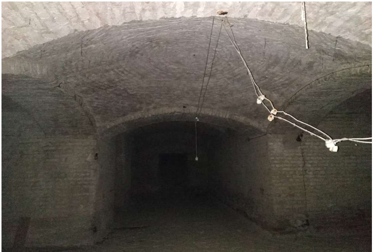
Figura 14. Volta a vela all'incrocio tra i due corridoi.
