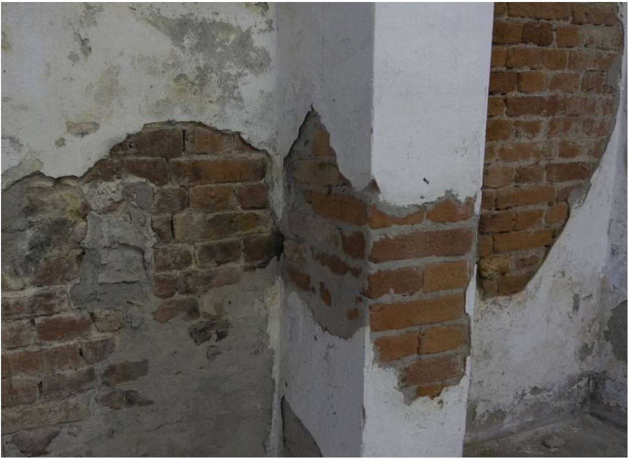
Figura 48. Pilastro tra le due nicchie, di fattura più recente.
