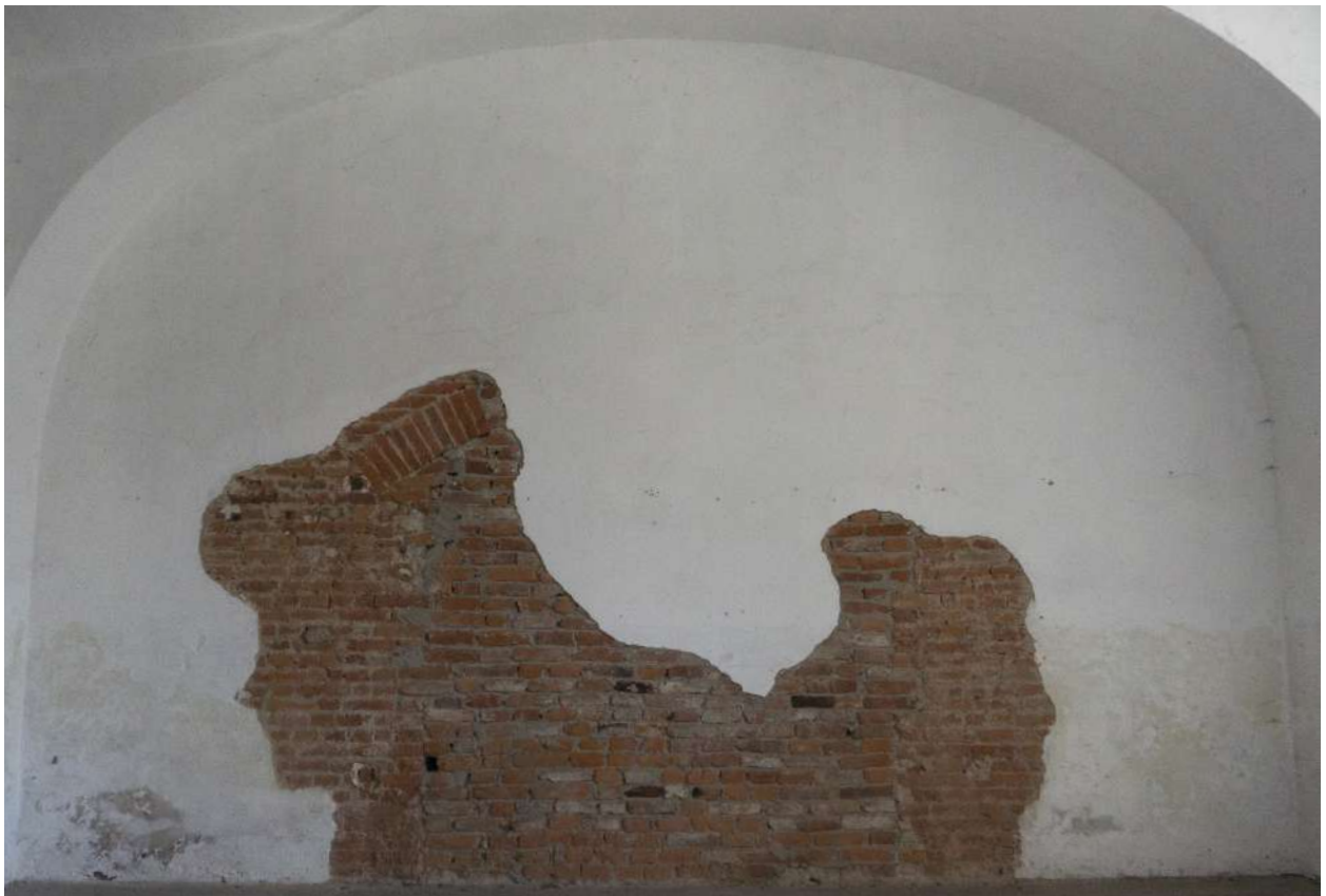
Figura 47. Traccia del camino tamponato e intonacato nella stanza all'estremo a sud nel pianterreno.
