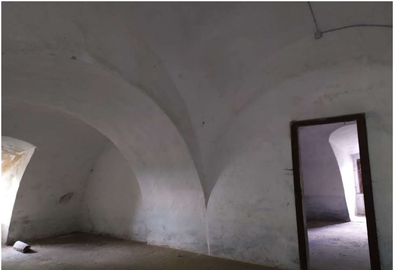
Figura 30. A sinistra la volta a botte rampante con cui termina il corridoio.
