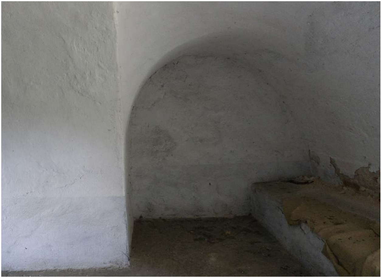
Figura 32. Volta " a collo d'oca" con cui termina l'ambiente a botte rampante in figura 30. Sul lato destro si intravede il "gradone" utilizzato come letto.
