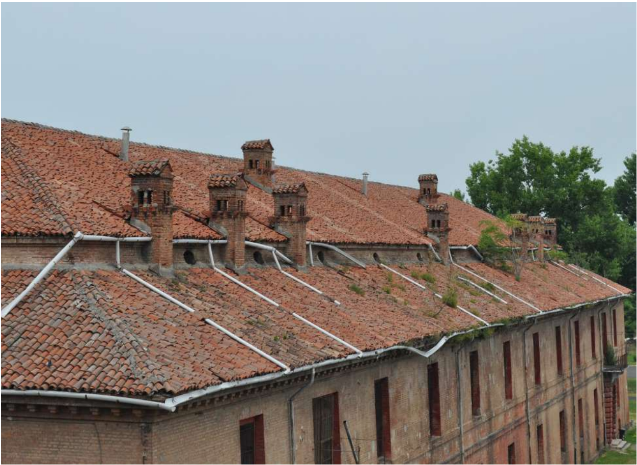
Figura 40. Nove dei quattordici camini che sveltano sulle coperture del prospetto est. Foto di Edoardo Piccoli.
