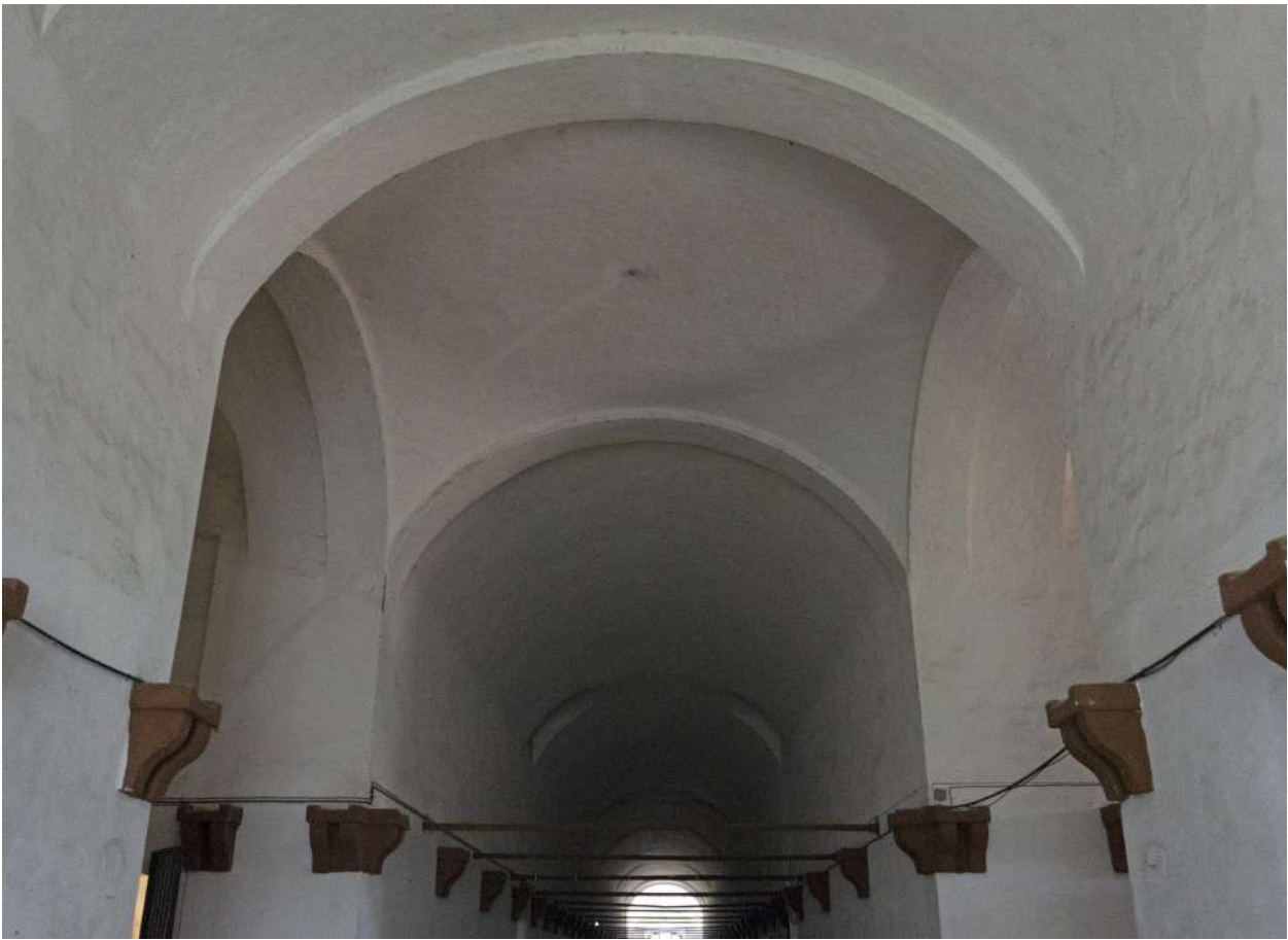
Figura 26. Ambiente situato nell'incrocio tra il corridoio longitudinale e quello trasversale, voltato a vela con arconi.
