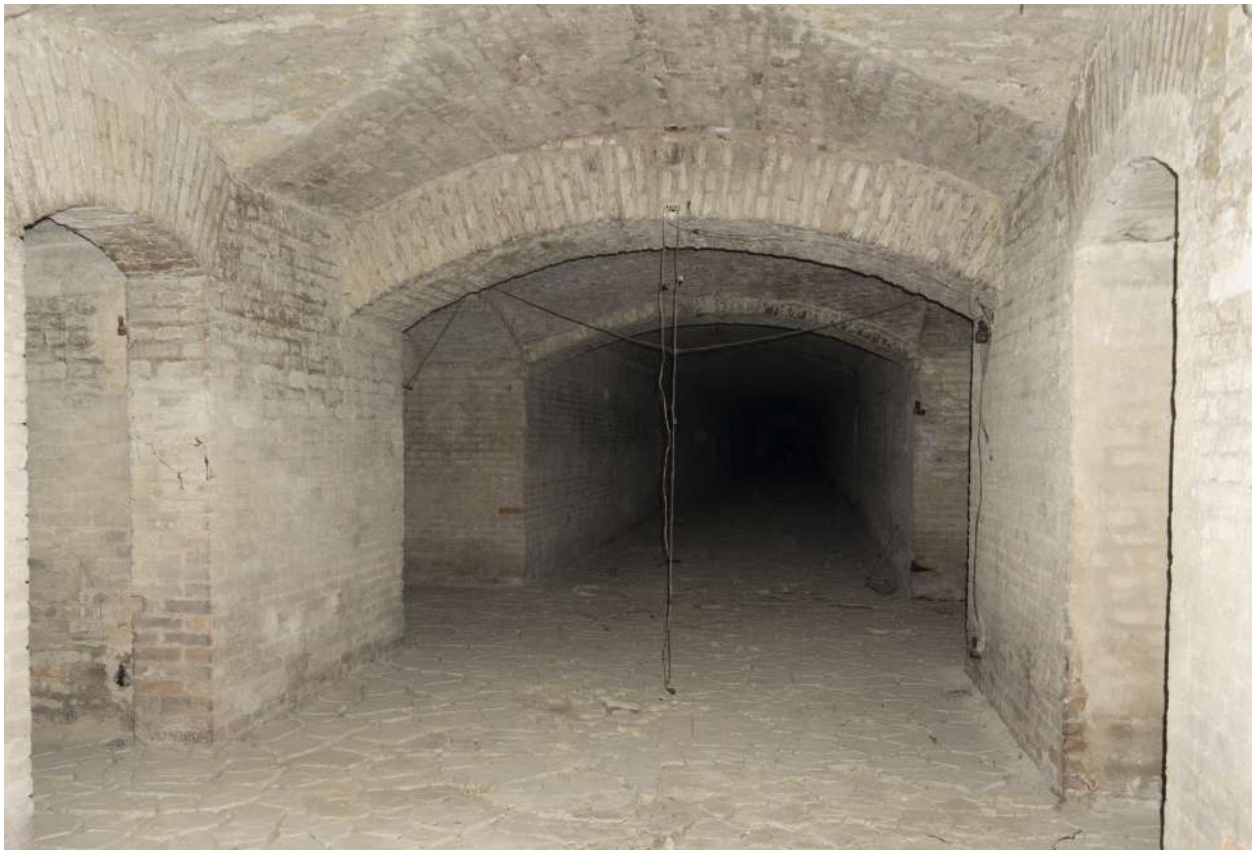
Figura 13. Corridoio trasversale con copertura a botte con sesto ribassato e lunette con arco di appoggio in corrispondenza delle porte.
