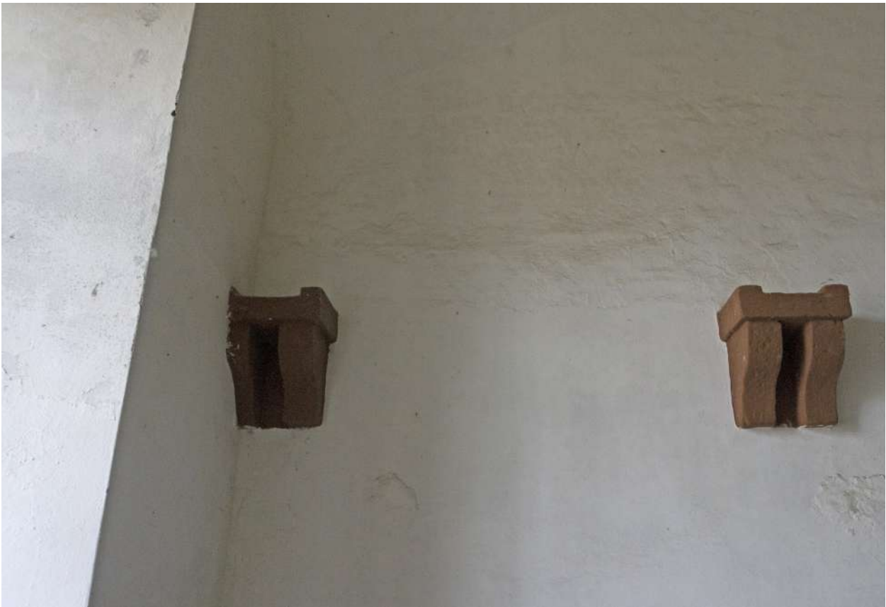
Figura 28. Confronto tra i due tipi di mensole: a sinistra la mensola dove si presume alloggiasse la trave di bordo in quanto il "dentino" sinistro della mensola è tagliato, mentre a destra vi è la mensola integra.
