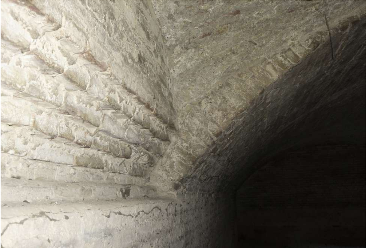
Figura 16. Sede d'attesa su cui si imposta la volta.
