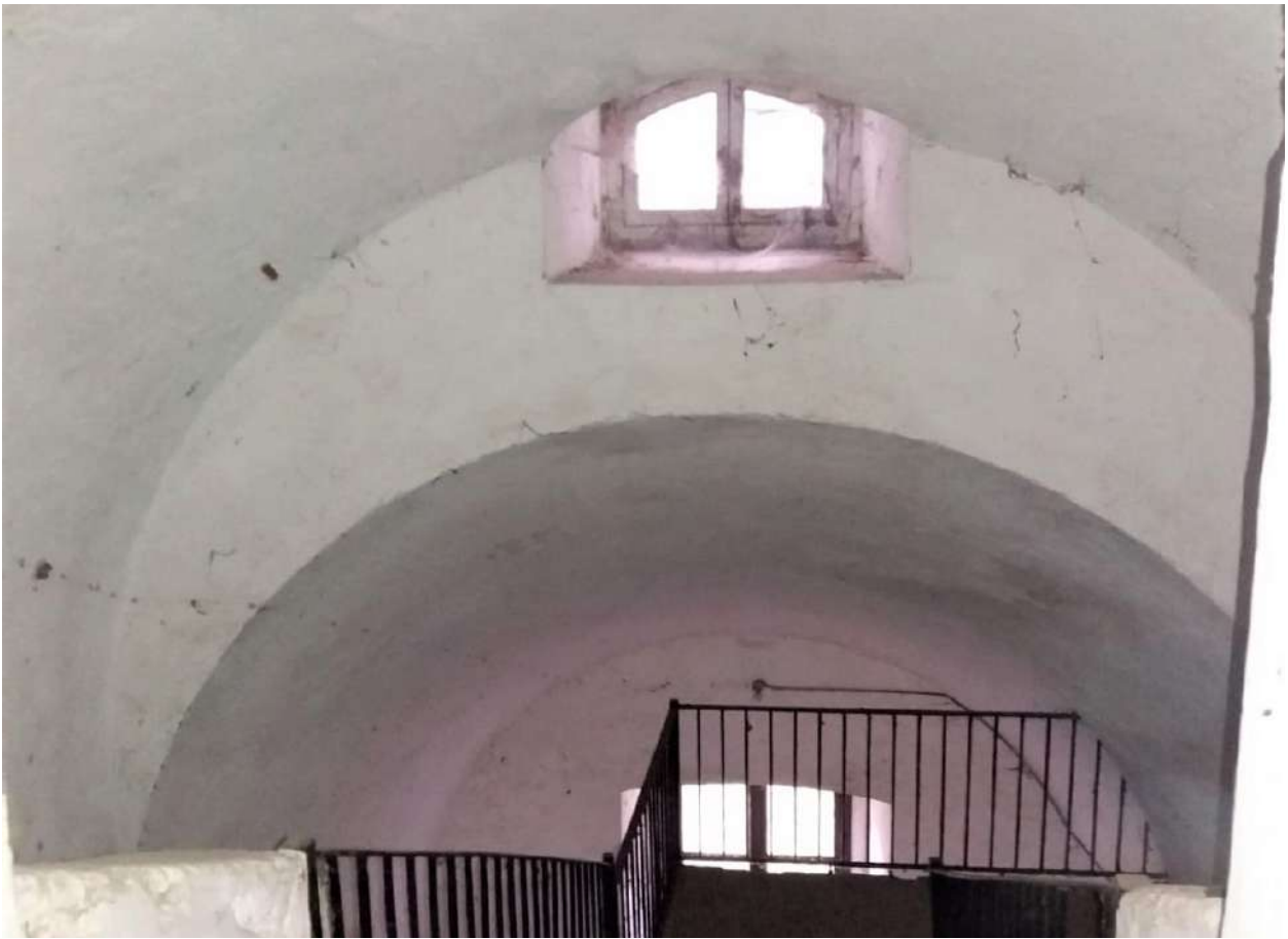
Figura 36. Le due volte a botte con generatrice inclinata salendo nel sottotetto.
