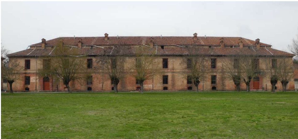
Figura 37. Si notano le due falde, foto del prospetto longitudinale ad est. Foto di Roberto Caterino.
