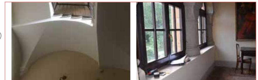
7. La parte voltata sotto le rampe di scala termina in peducci, elemento ricorrente nei locali del castello.
