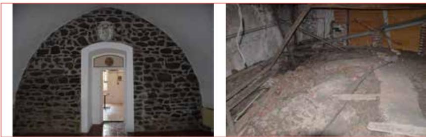
1. L'arco generatore della volta è parabolico con imposta a livello del pavimento, alla vista pare irregolare.
