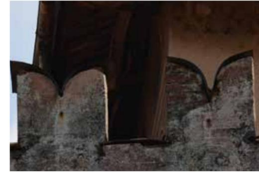
Particolare del prospetto Nord. Il degrado riguarda tutto lo strato di finitura, rivelando il laterizio sottostante.
