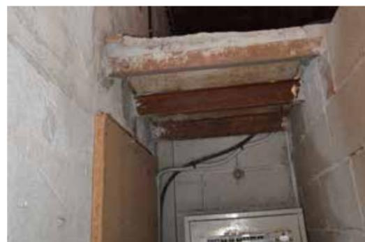
Tramezzi aggiunti costituiti da blocchi in cemento, solaio di putrelle metalliche e tavelloni. Sopralluogo del 4 aprile 2019.
