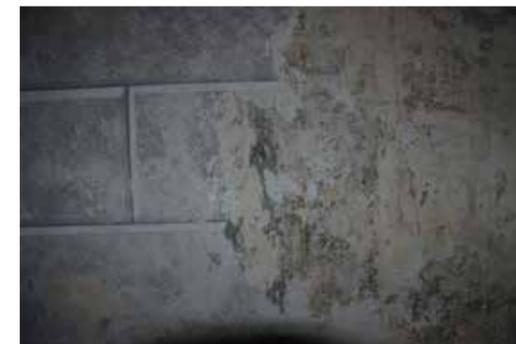
Distacco dell'intonaco non colorato utilizzato nel restauro degli anni Ottanta del XX secolo. Sopralluogo del 24 luglio 2019.
