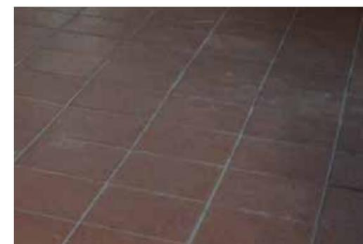
Efflorescenza visibile sulle pavimentazioni, causata dall'umidità di risalita del terreno. Sopralluogo del 24 luglio 2019.
