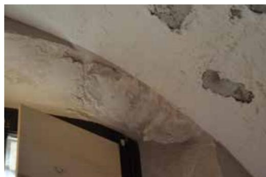
Efflorescenza, rigonfiamento e distacco dell'intonaco, dovuto a infiltrazioni di umidità dal livello della copertura, fino al piano in oggetto. Sopralluogo del 19 giugno 2019.
