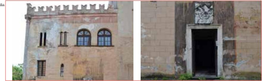
5. Il prospetto ovest della manica est presenta aperture irregolari, probabilmente realizzate in epoche differenti.
