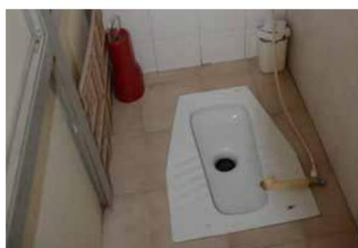
Tramezzi realizzati con pannelli in compensato, pareti rivestite con piastrelle in ceramica e pavimentazione in gres porcellanato.
