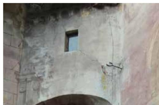
Nonostante le finiture non pregiate dell'interno, il locale di presenta in buone condizioni. La forma di degrado più marcata è visibile dall'esterno: si nota, infatti, una fessurazione che percorre il prospetto interrompendosi in corrispondenza del serramento. Sopralluogo del 8 agosto 2019.
