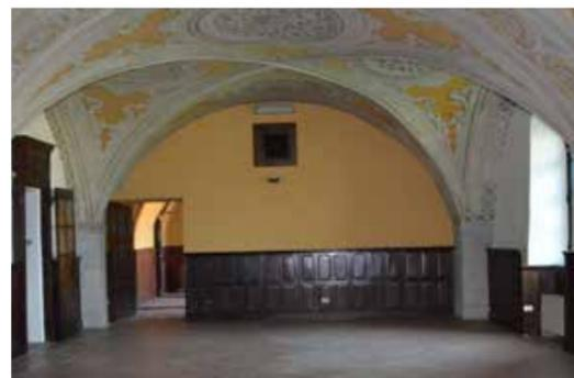
Pavimentazione in cotto e boiserie sulle pareti, interamente intonacate. Sopralluogo del 24 luglio 2019.
