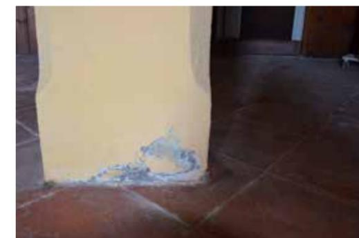
Distacco dell'film di vernice acrilica che ricopre l'intonacatura originale.
