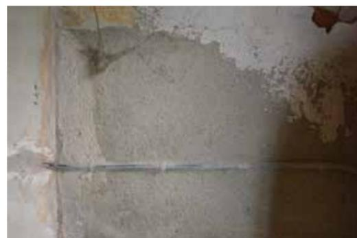
Apposizione di materiale incoerente, là dove l'intonaco originale si presenta danneggiato con efflorescende e distacchi causati dall'umidità di risalita. Sopralluogo del 17 maggio 2019.
