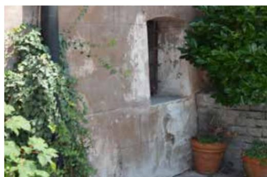
Particolare del prospetto Sud: efflorescenza causata da umidità di risalita e ruscellamento dell'acqua piovana. Sopralluogo 24 luglio 2019.
