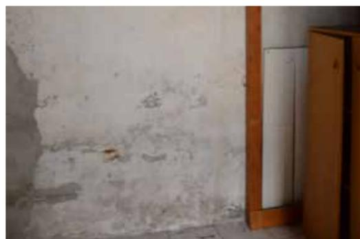
Pareti ricoperte di intonaco di calce. Pavimentazione in gres porcellanato. Sopralluogo del 4 aprile 2019.
