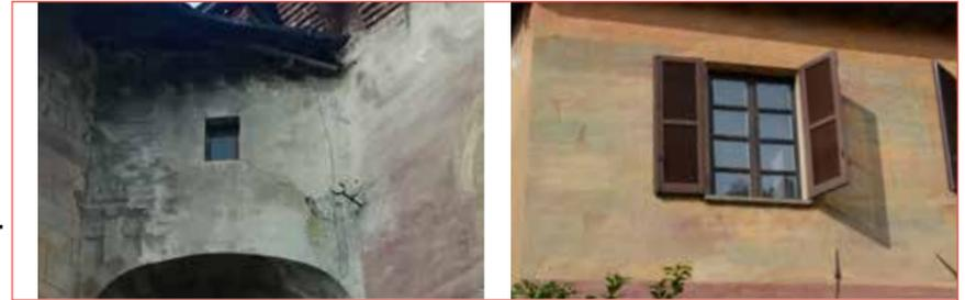
3. È presente una lesione passante obliqua sul prospetto del corpo sospeso posto tra il prospetto ovest della torre a base quadrangolare e il prospetto sud dell'ala est del castello.
