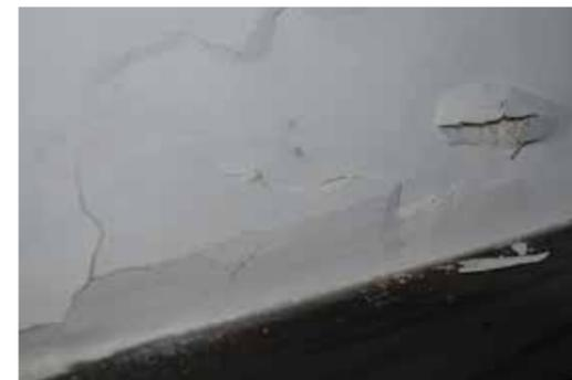
Fessurazione e rigonfiamento dell'intonacatura acrilica. Sopralluogo del 24 luglio 2019.
