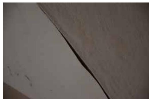
Distacco del film di vernice. Sopralluogo del 19 giugno 2019.
