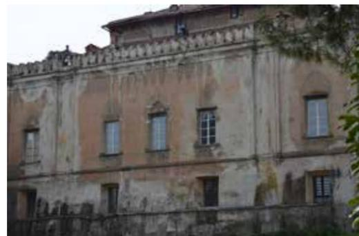
Sulle immagini storiche del castello si può notare la presenza di pluviali anche su questo prospetto del castello. Oggi sono stati sostituiti da sistemi di scolo che hanno causato colature sull'intonaco della facciata.
