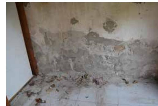
Distacco e polverizzazione dell'intonaco. Si nota la presenza di efflorescenza. Sopralluogo del 4 aprile 2019.
