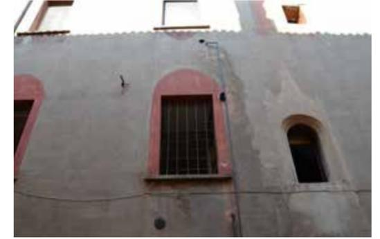
La colatura presente sul prospetto ovest è dovuta alla percolazione di acqua d'impianto del secondo piano dell'edificio. Sopralluogo 31 maggio 2019.
