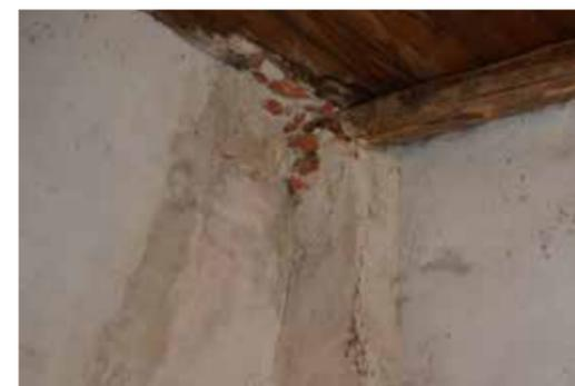
Colatura dovuta a infiltrazioni d'acqua dalla copertura. Sopralluogo del 4 aprile 2019.
