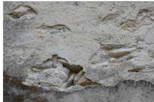
Particolare del prospetto Est, in cui, grazie al degrado dell'intonaco, si possono osservare i materiali della struttura portante. Sopralluogo 24 maggio 2019.
