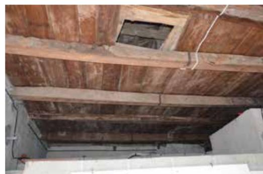
Controsoffittatura in legno che nasconde la struttura del tetto, anch'essa lignea. Sopralluogo del 4 aprile 2019.
