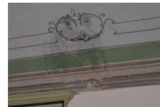
L'ammaloramento della copertara ha causato l'infiltrazione di acqua che, arrivata fino alla volta, ha causato il danneggiamento della finitura. Sopralluogo del 10 settembre 2019.
