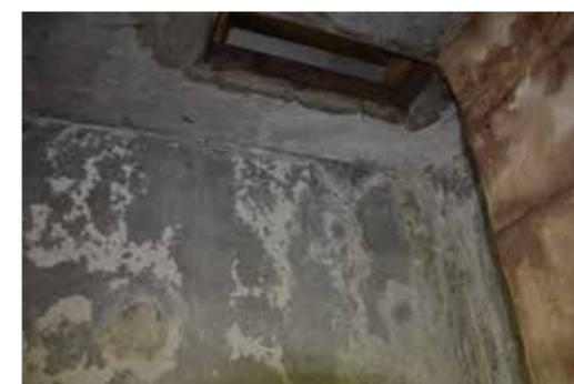
Controsoffittatura lignea con pannelli in compensato rivestiti di intonaco di cemento.
