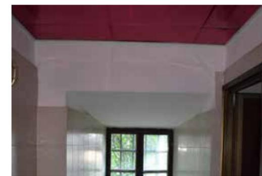
Controsoffittatura in pannelli di pvc e intonaco di calce. Serramenti interni in legno ed esterni in legno e vetro. Sopralluogo del 25 luglio 2019.
