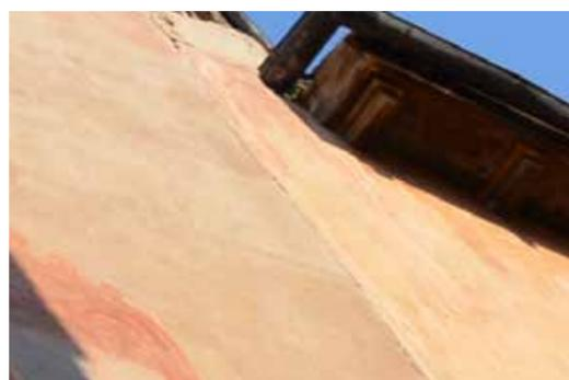
Particolare del prospetto ovest: punto di giunzione tra le murature di due fasi differenti. Sopralluogo 31 maggio 2019.
