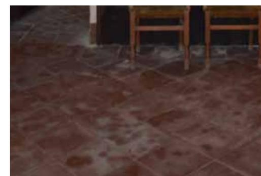
Efflorescenza dovuta all'umidità di risalita del terreno.
