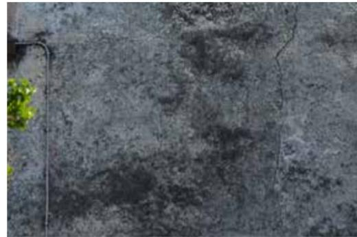
Particolare del prospetto Nord: il deposito superficiale ha aderito su una superficie già degradato
