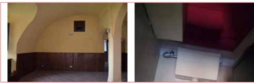
5. In un intervento di rimaneggiamento della fabbrica, sono stati inseriti due pilastri al piano seminterrato, in corrispondenza di un setto presente al piano superiore. Questa soluzione è stata quindi probabilmente adottata per sostenere il setto sovrastante.
