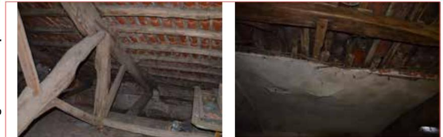
5. L'orditura è costituita da capriate nei punti in cui la copertura è a due falde, mentre nel tratto in cui la falda est incontra il corpo centrale dell'edificio i puntoni proseguono fino all'incontro con il muro.
