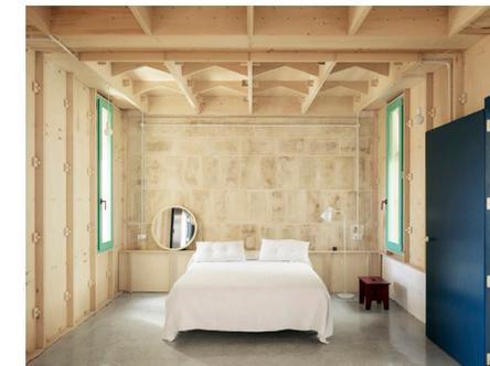
È stato studiato quindi un nuovo sistema costruttivo che sfruttasse le capacità strutturali del compensato e la possibilità di tagliarlo con un router CNC, così da formare una struttura semplice e
