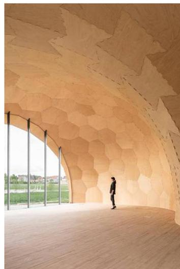
Il *Landesgartenschau Exhibition Hall* è un padiglione espositivo, concepito presso l'Università di Stoccarda, all'interno del progetto "*Robotics in Timber Construction*", oltre che un prototipo architettonico per la progettazione e realizzazione computerizzata di costruzioni in compensato <sup>[57]</sup>.
