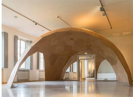
Inoltre, per la fase di montaggio sono state realizzate delle centine di sostegno in legno al di sotto della struttura che sono state rimosse al momento del completamento.
