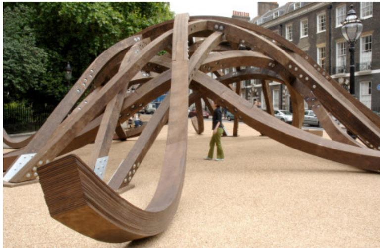
Le connessioni dei vari componenti sono state effettuate attraverso placche metalliche e bulloni, così come le connessioni al terreno. Il padiglione, fornisce un'area maggiormente riparata, dove sostare e vivere dall'interno l'articolata struttura che lo compone, e delle sedute esterne formate dai prolungamenti delle travature sulle quali poter sostare in tranquillità.
