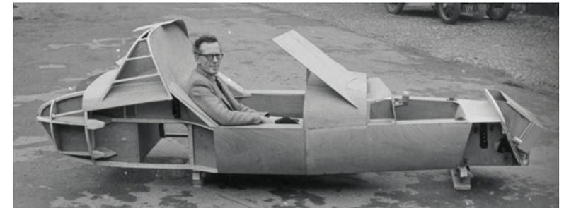
Fig. 68: realizzazione del telaio in Plywood alla Marcos Engineering (a lato);
