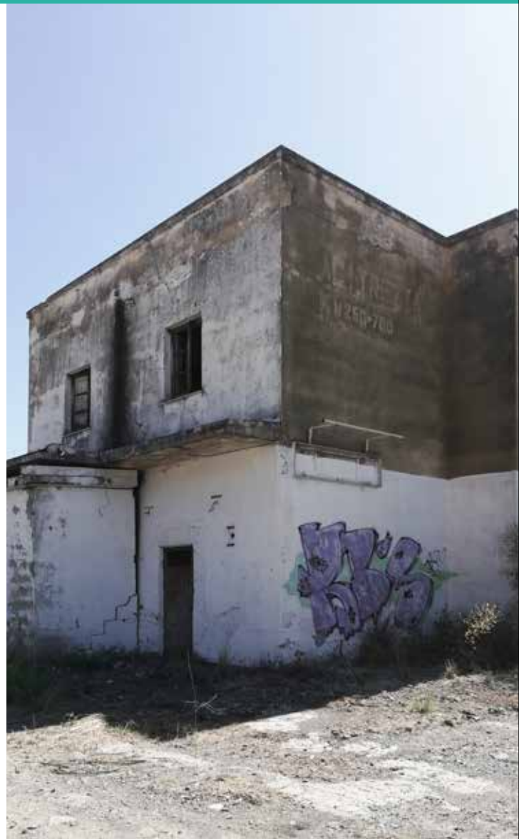
5.d Ex stazione di Acitrezza, vista dal fronte principale, lato binari (2019) Autore: Mangiameli Adriana
