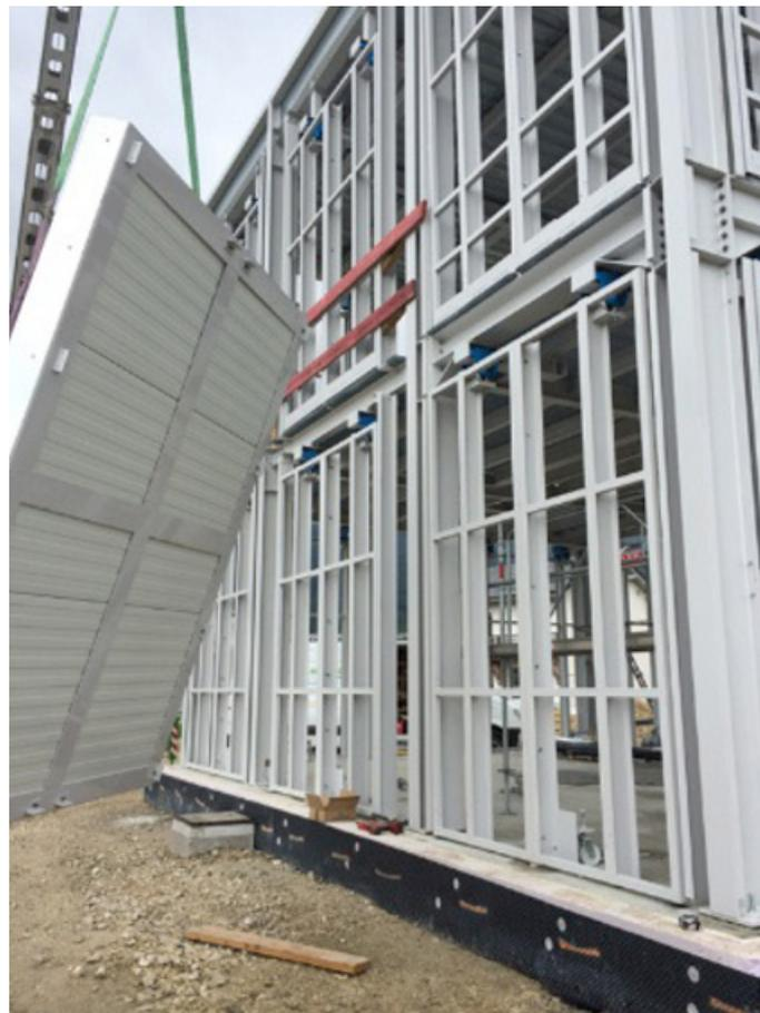
Figura 13. Telaio strutturale e pannelli di chiusura FACT (FRA)
