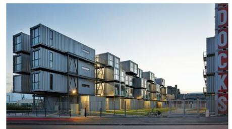
Figura 89. *Cité a Docks* (Le Havre, Francia) sono il risultato della trasformazione di vecchi container industriali in unità abitative modulari dotate di ogni comfort. Montate su una griglia metallica, le unità hanno dato forma a un edificio di quattro piani che ospita 100 appartamenti di 24 metri quadrati ciascuno.
