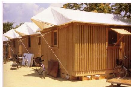
Figura 63. Paper Log house, progettata da Shigeru Ban per i terremotati di Kobe nel 1995.
