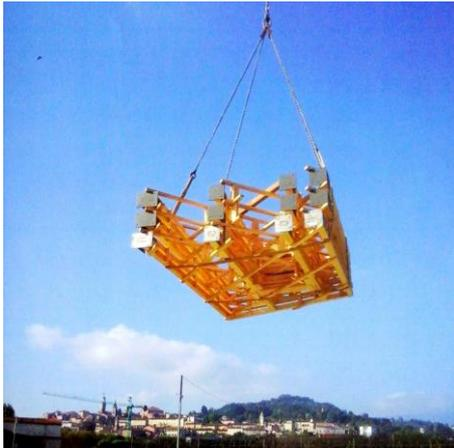
Figura 133. Ossatura lignea pre-assemblata in stabilimento.
