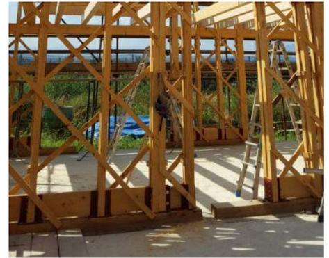
Figura 135. La struttura reticolare si ancora al cordolo mediante una serie di piastre metalliche.
