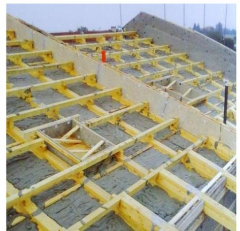
Figura 136. Conglomerato Nidus costituito da un impasto a base di calce idraulica naturale, inerti minerali alleggeriti e fibre vegetali.
