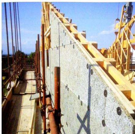
Figura 138. Fissaggio tramite viti del cassero alla struttura reticolare.
