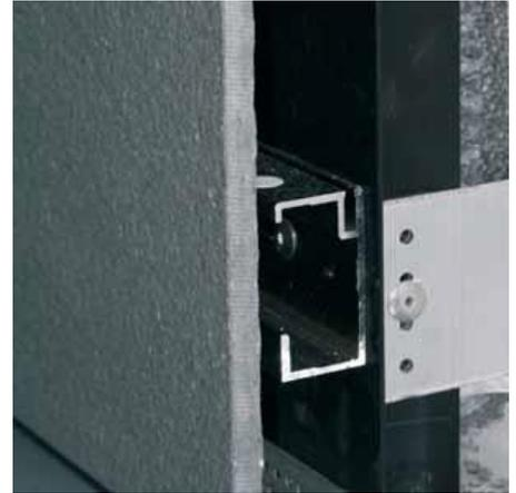
Figura 143. Sistema Granitech GHS con ancoraggio nascosto.
