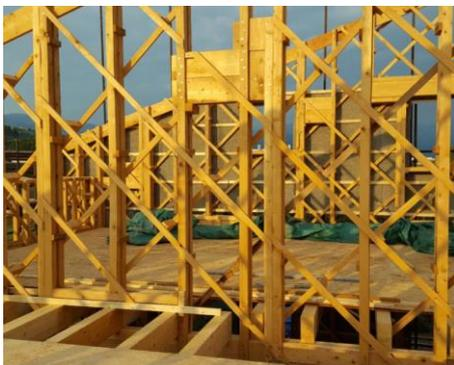
Figura 134. Sistema a telaio leggero in legno massiccio di classe C24 e legno lamellare di classe GL24h.
