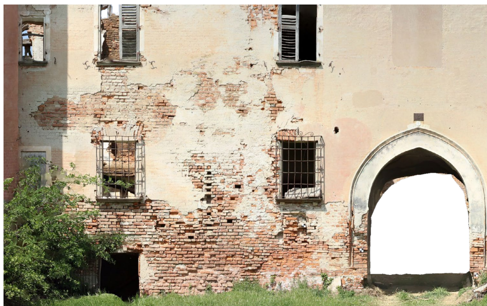
▲ 19. Ortofoto prospetto Ovest Degrado caratteristico di questa elevazione è la fessura passante che si sviluppa in tutta altezza circondata da una leggera patina biologica
