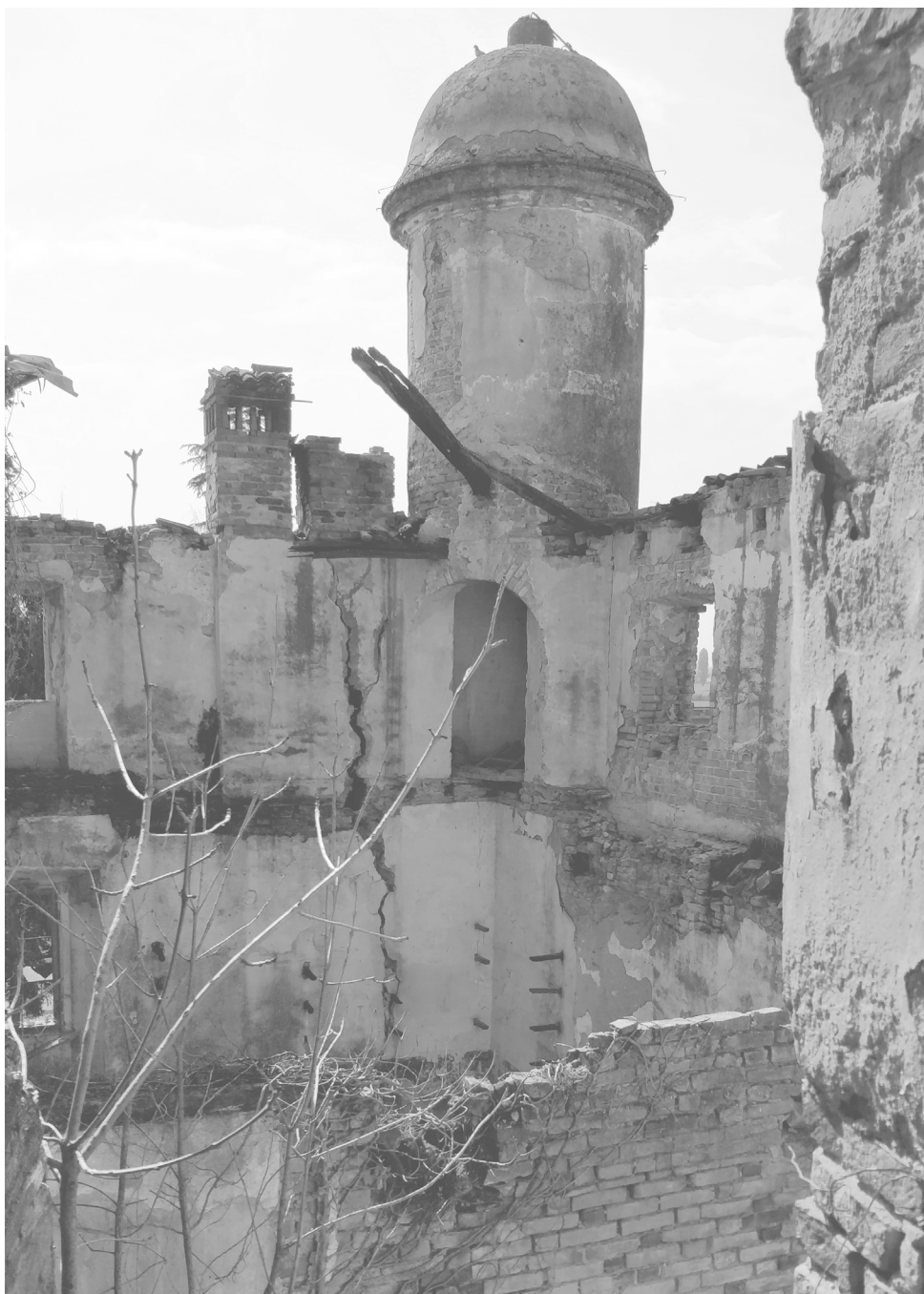
▲ 7. Interno nord-ovest (fonte: foto dell'autore, sopralluogo 17/04/2019)
