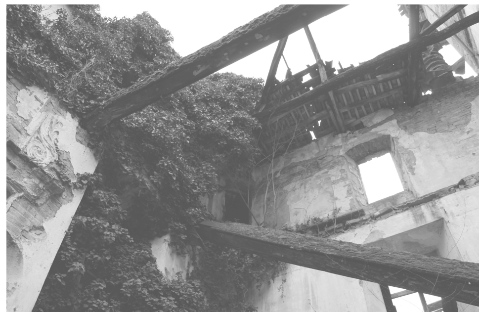
▲ 9. Interno sud-est (fonte: foto dell'autore, sopralluogo 19/01/2019)
