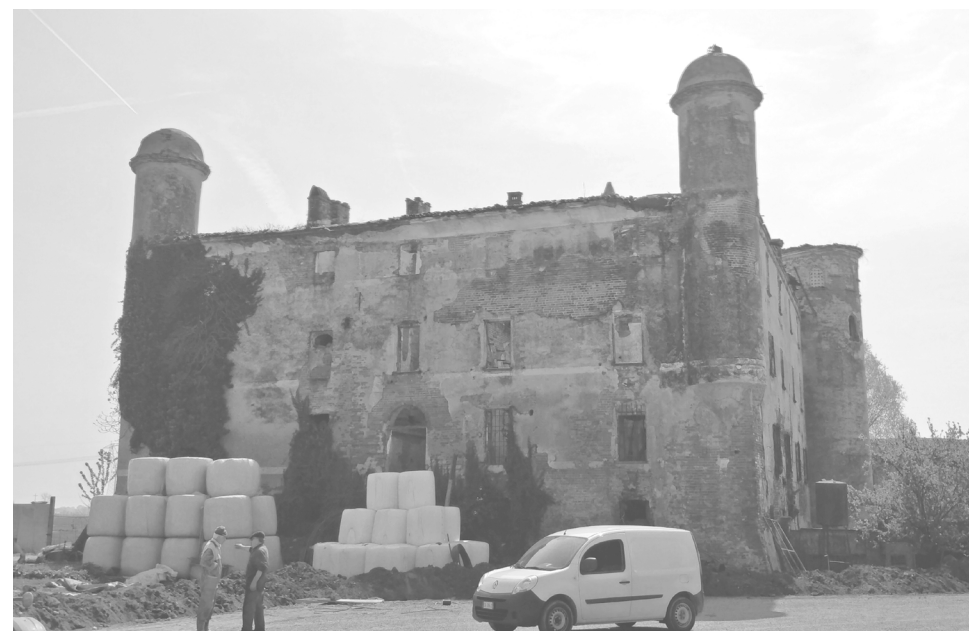
▲ 3. Prospetto nord (fonte: foto dell'autore, sopralluogo 17/04/2019)
