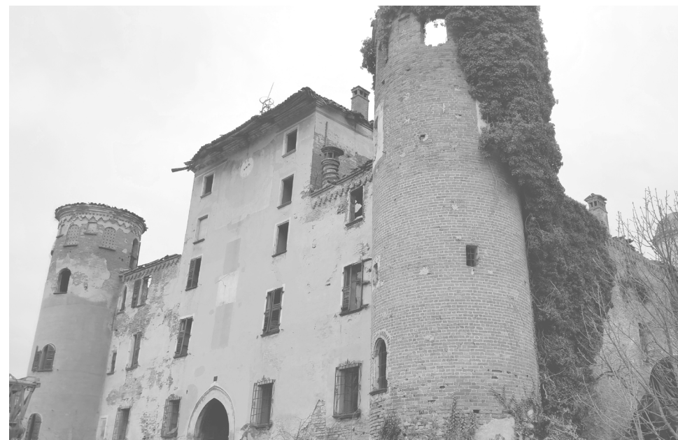
▲ 2. Prospetto sud (fonte: foto dell'autore, sopralluogo 19/01/2019)
