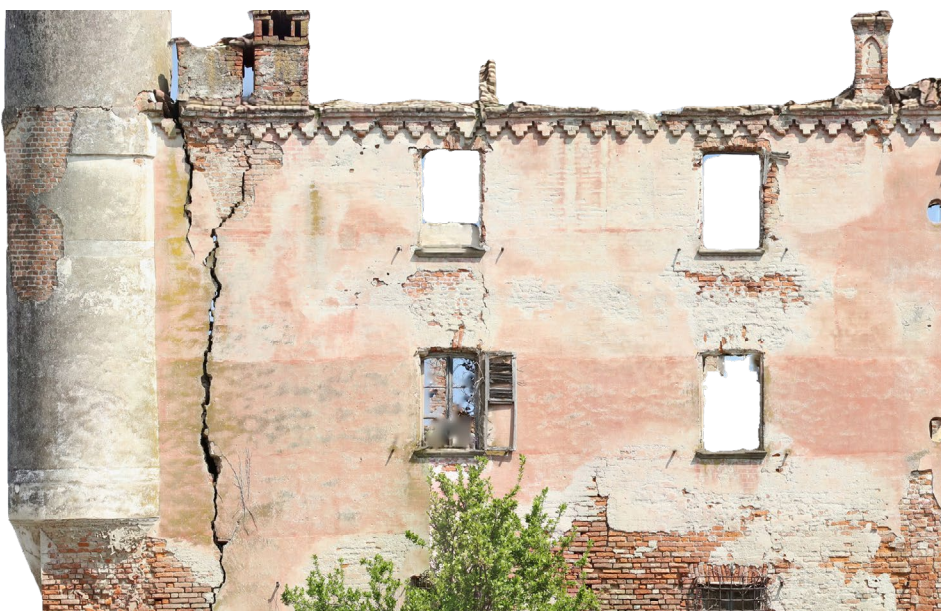
▲ 19. Ortofoto prospetto Ovest Degrado caratteristico di questa elevazione è la fessura passante che si sviluppa in tutta altezza circondata da una leggera patina biologica
