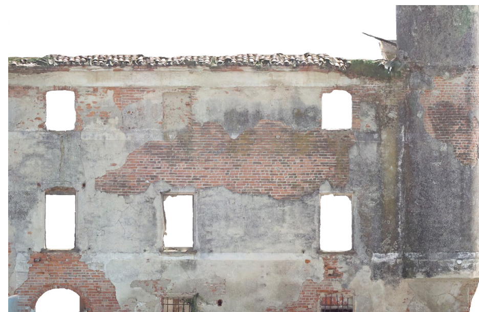
▲ 21. Ortofoto prospetto Nord Torrino Nord-Ovest caratterizzato dal degrado macchia e accompagnato da una serie di distacchi d'intonaco e patine biologiche
