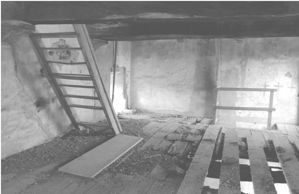
^ 10. Interno della torre porta, piano terzo (fonte: foto dell'autore, sopralluogo 17/04/2019)
