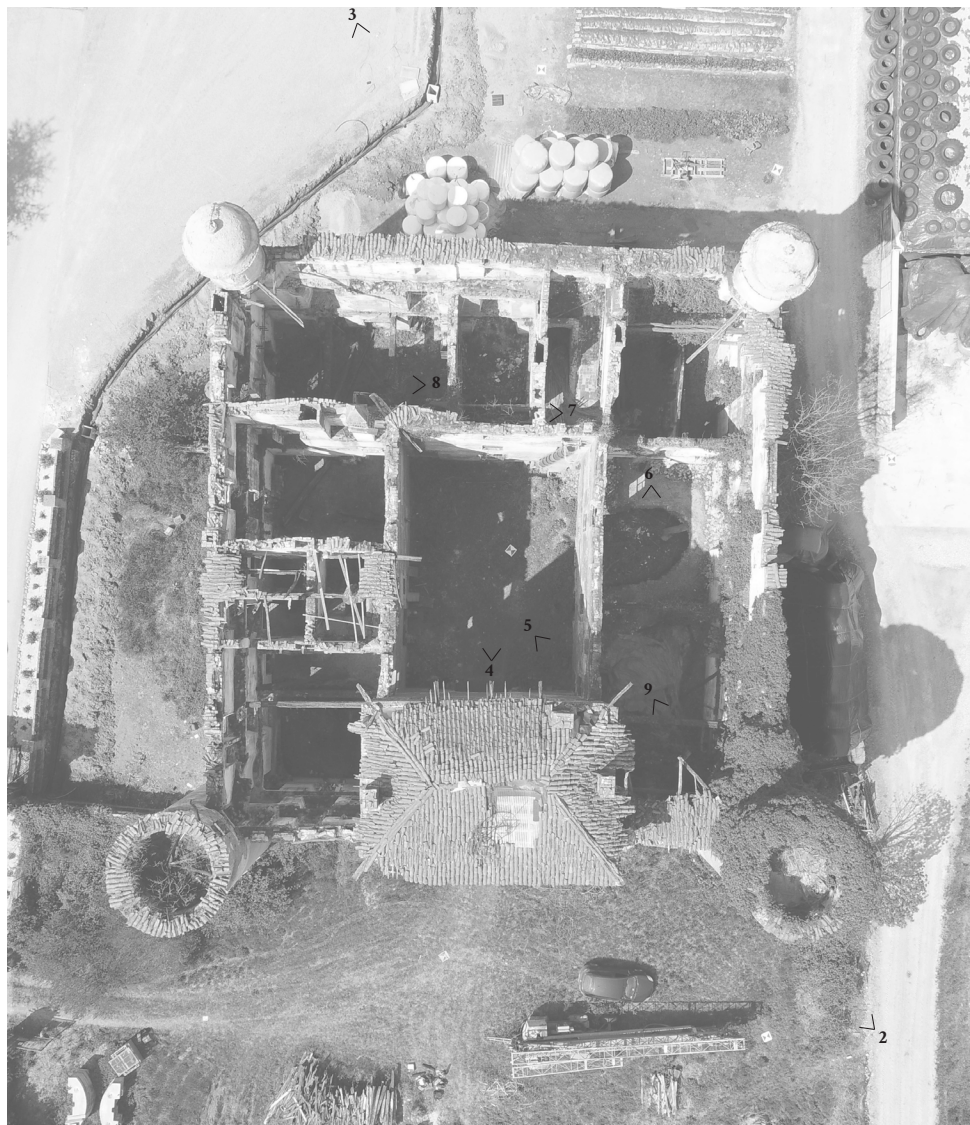
▲ 1. Vista aerea del castello (fonte: elaborazione da drone Phantom 4 Pro, sopralluogo 17/04/2019)
