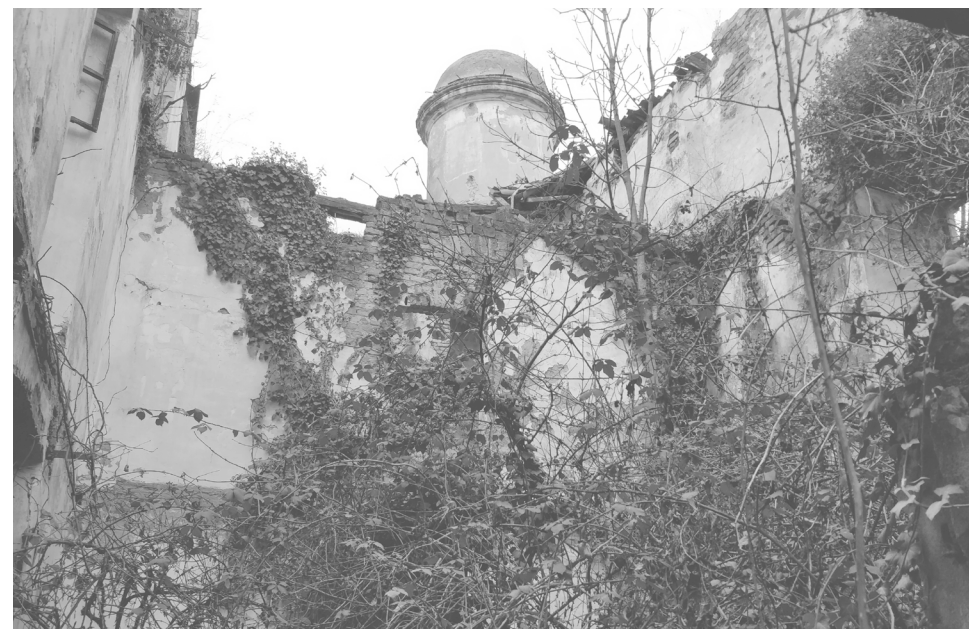
▲ 8. Interno nord-est (fonte: foto dell'autore, sopralluogo 19/01/2019)
