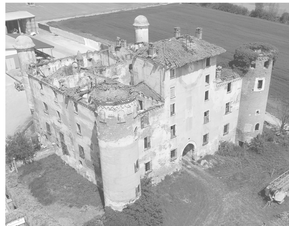
▲ 6. Veduta aerea del castello
