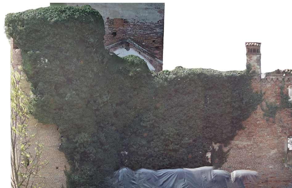
▲ 21. Ortofoto prospetto Nord Torrino Nord-Ovest caratterizzato dal degrado macchia e accompagnato da una serie di distacchi d'intonaco e patine biologiche
