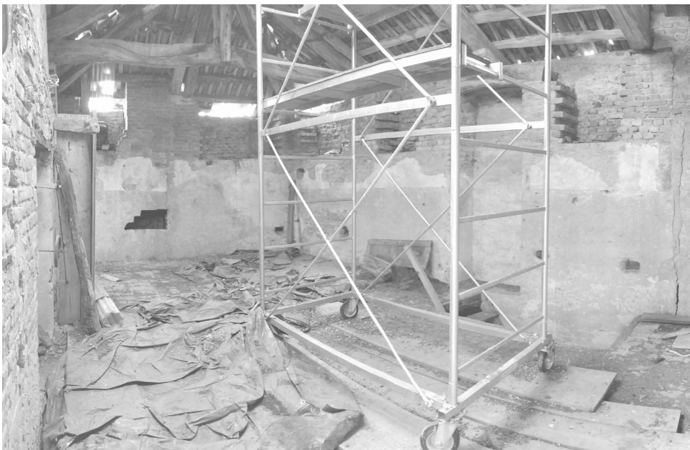
^ 11. Sottotetto della torre porta (fonte: foto dell'autore, sopralluogo 17/04/2019)
