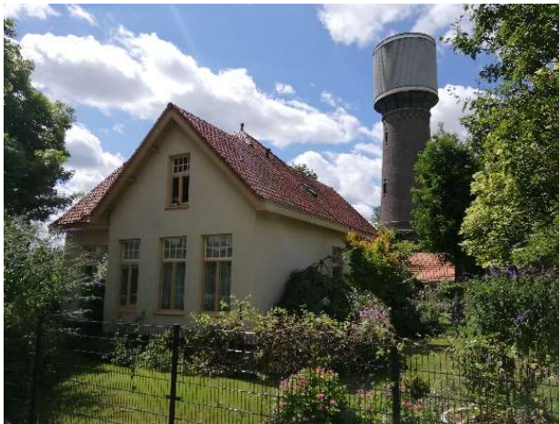
Figura 46. Water tower e casa del vecchio gestore.
