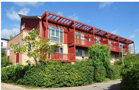
Figura 16. Residenza Vasalishof, facciata sud-est.
