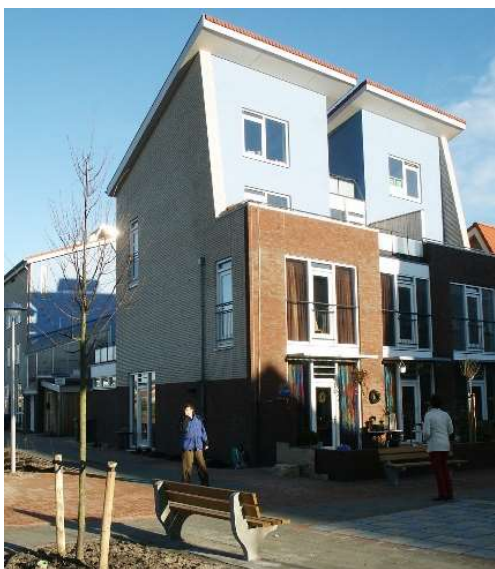
Figura 18. Residenza Hendrik Marsmanweg, facciata sud-est.
