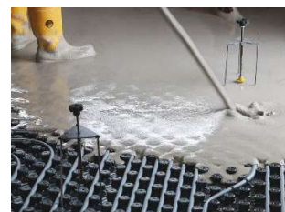
Figura 3. Colatura massetto in anidrite.
