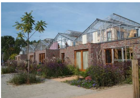
Figura 21. Residenza Kaswoningen, facciata sud-ovest.
