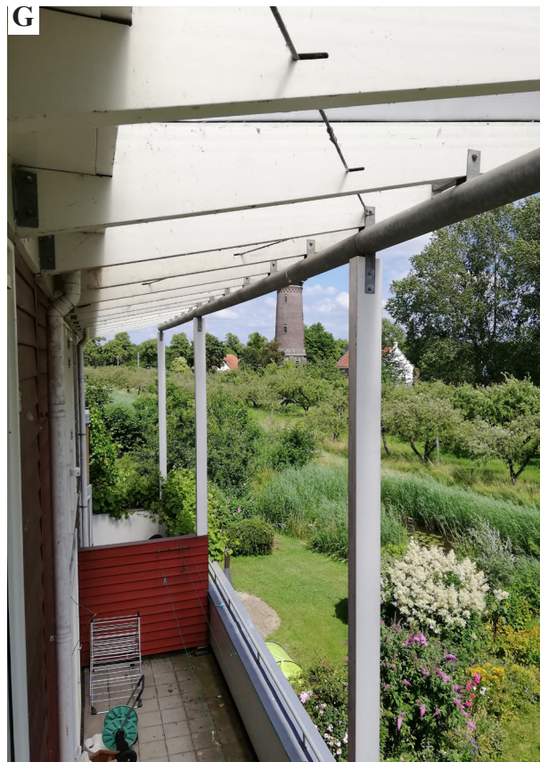
Foto terrazza ed affaccio sud, 01/07/2019, Culemborg.
