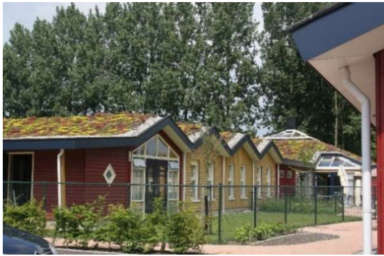
Figura 38-39. Tetti verdi del complesso Paul Rodenkohof.
