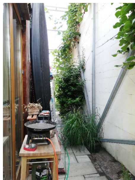
Figura 60. Il modulo abitativo si stacca dalla struttura su tutti i suoi lati; la semplice pavimentazione cementizia in questi spazi poggia direttamente sul terreno.
