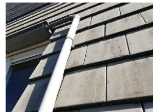
Figura 4. Foto della copertura. 05/07/2019
