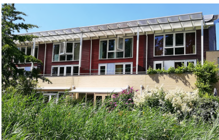
Figura 63. Foto della facciata sud, 01/07/2019, Culemborg
