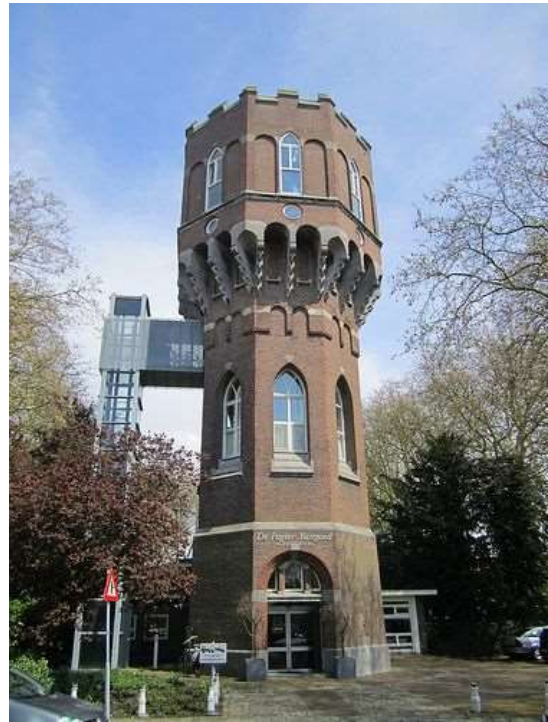
Figura 49. Water tower di Middleburgh convertita in ufficio al piano terra ed alloggi ai piani superiori.
