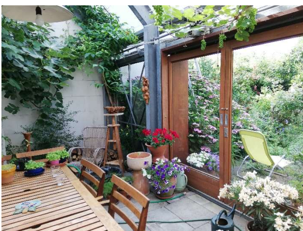
Figura 59. Lo spazio buffer dialoga visivamente e fisicamente con il giardino; sullo sfondo una parete di mattoni di silicato, con ottime prestazioni acustiche, separa dall'unità abitativa adiacente.
