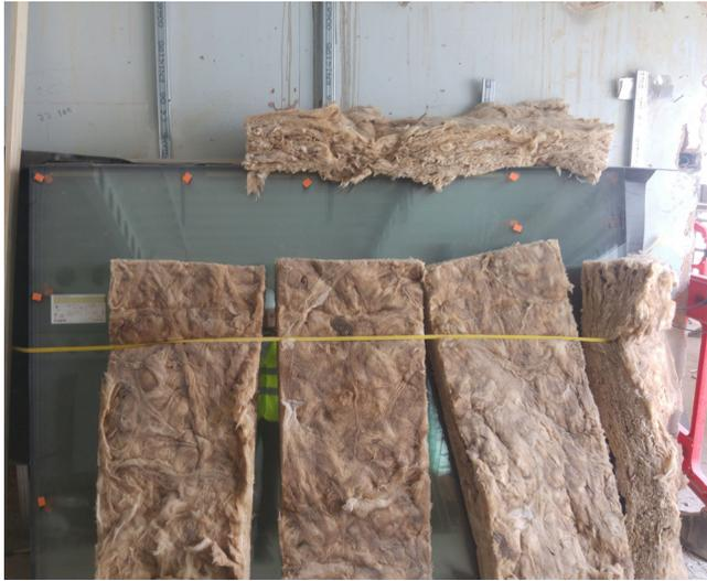
Fig. 125 - Isolante flessibile minerale in lana di roccia a posa discontinua.
