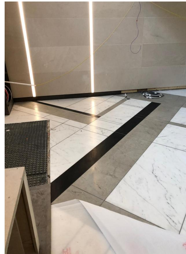
Fig. 140 - Ambiente reception con inserimento di luci a led nel muro.
