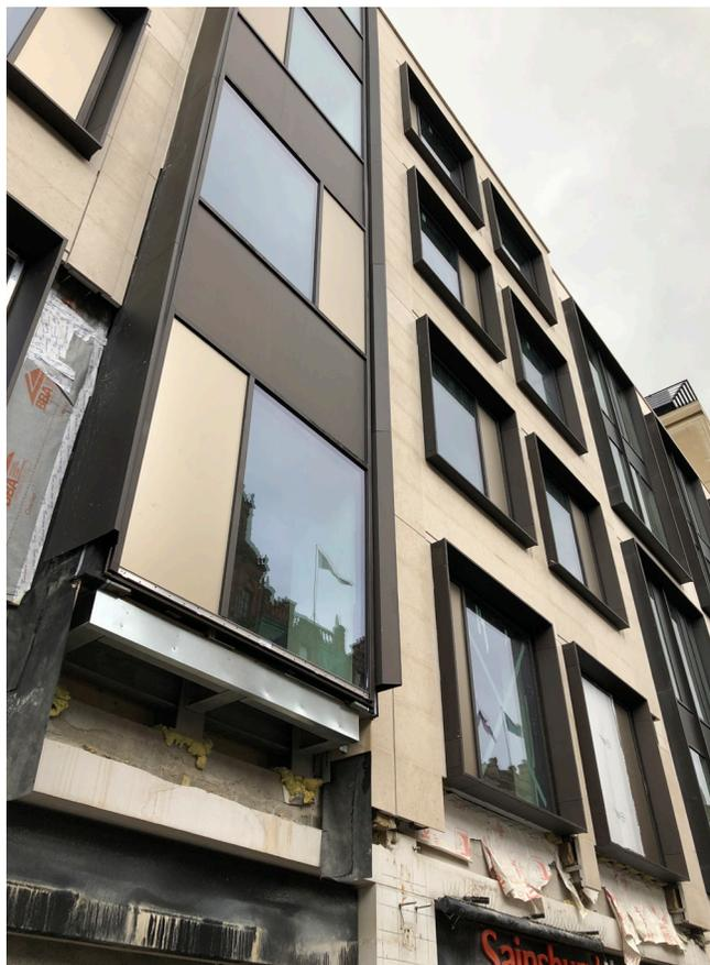
Fig. 130 - Facciata in Brompton Road, nuovo rivestimento e nuovi infissi.
