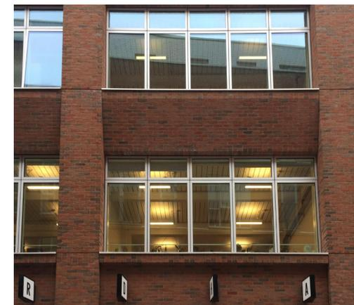
Fig. 26 - Dettaglio facciata principale, le aperture sono state riproposte in linea con quelle originali. Dall'esterno è possibile vedere le travi IPE in acciaio utilizzate per la realizzazione del nuovo telaio strutturale.
