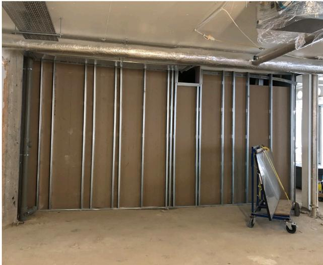
Fig. 117 - Struttura in acciaio della parete in cartongesso.
