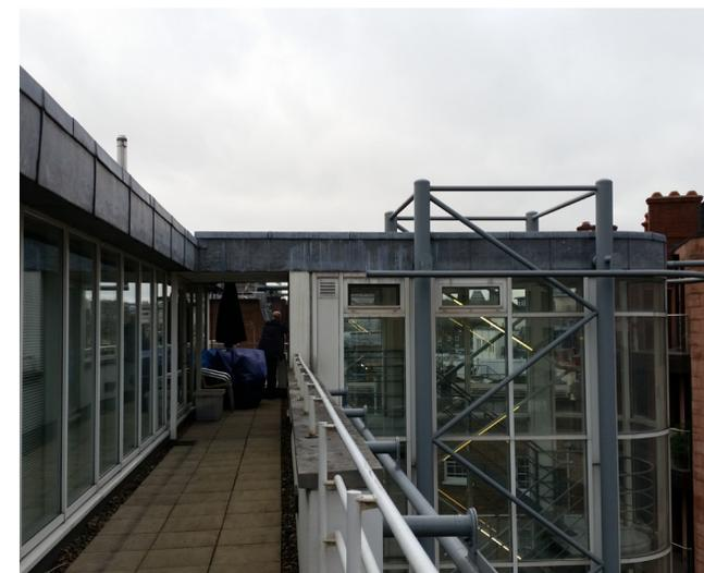
Fig. 103 - Scala esterna in vetro e acciaio del prospetto posteriore.
