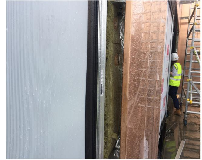
Fig. 127 - Particolare della facciata ventilata, ubicazione dei pannelli isolanti.
