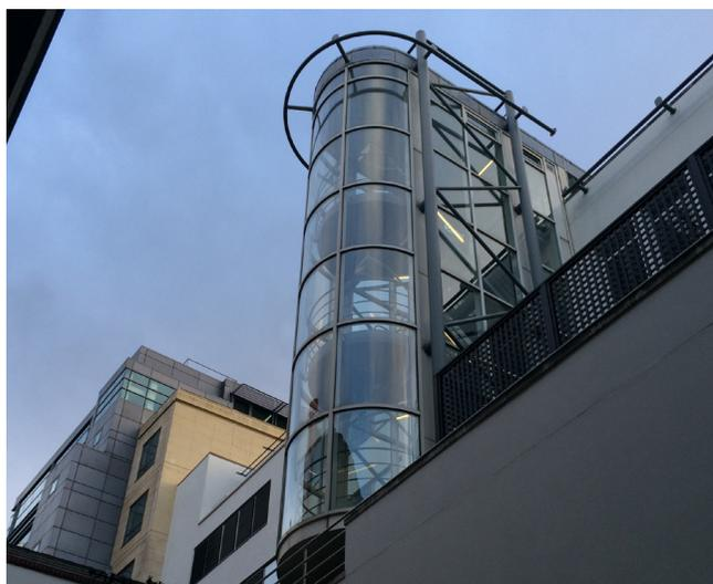
Fig. 104 - Scala esterna in acciaio e vetro del prospetto posteriore.
