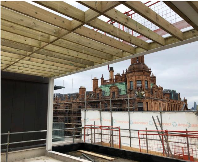
Fig. 119 - Struttura del solaio in legno della copertura verso Harrods.
