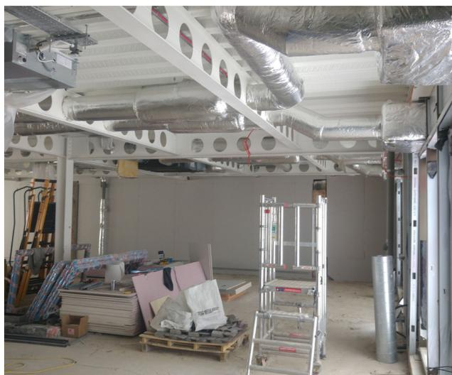
Fig. 123 - Passaggio degli impianti nella sezione della trave.
