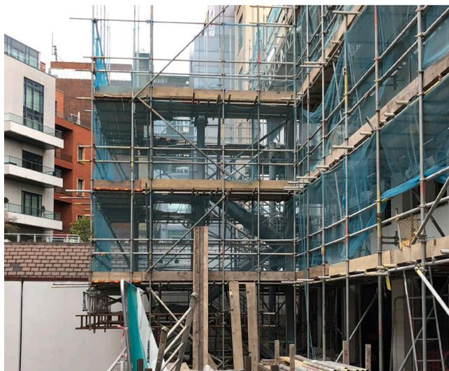
Fig. 107 - Demolizione delle scale posteriori.
