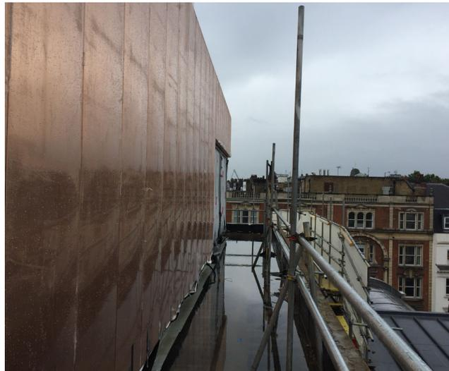
Fig. 128 - Rivestimento in acciaio anodizzato al quinto piano.
