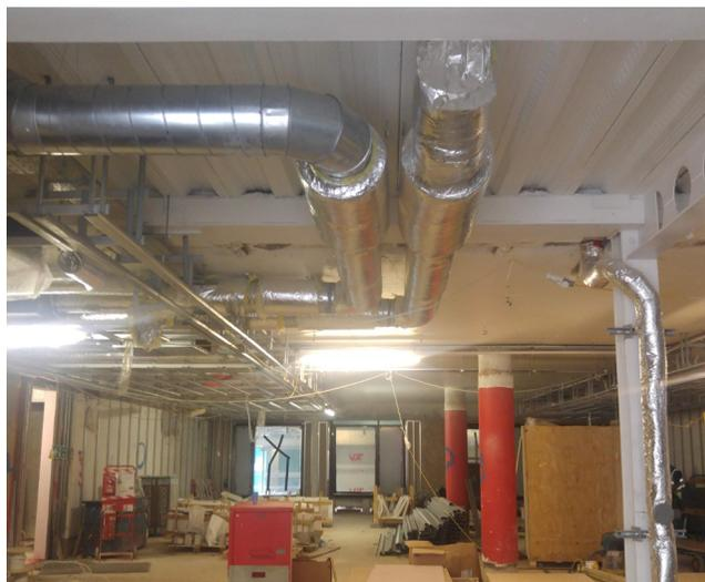
Fig. 121 - Uffici primo piano, impianti di areazione.
