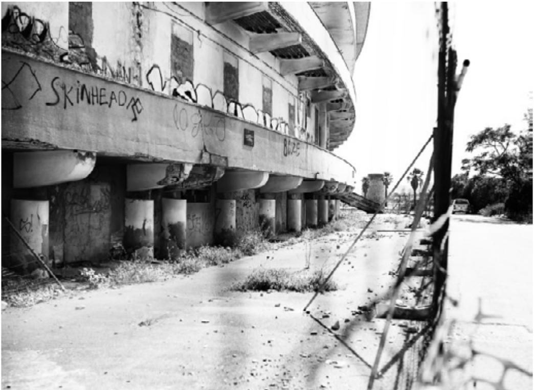
contenuti i collegamenti verticali, collegati tra loro da un telaio di travi e pilastri in calcestruzzo armato che formano una sorta di pergolato. Sul lato strada il pergolato presenta una pensilina di copertura, anch'essa in calcestruzzo armato, che sporge oltre il filo esterno dei balconi.
