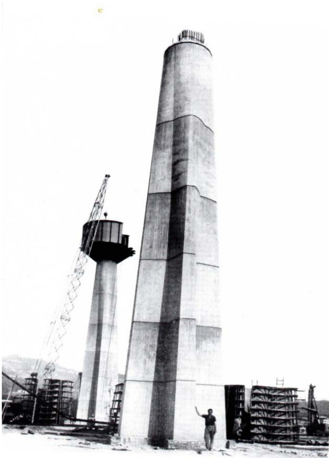
Fase di costruzione di un pilastro principale cruciforme.
