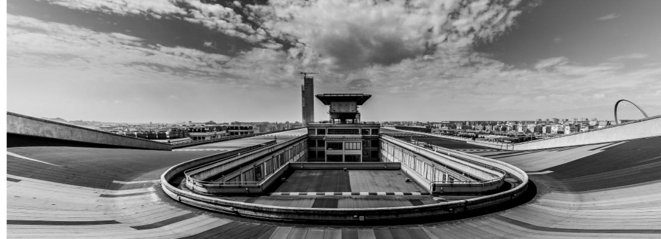
«la pista sul tetto per la prova dei veicoli»
