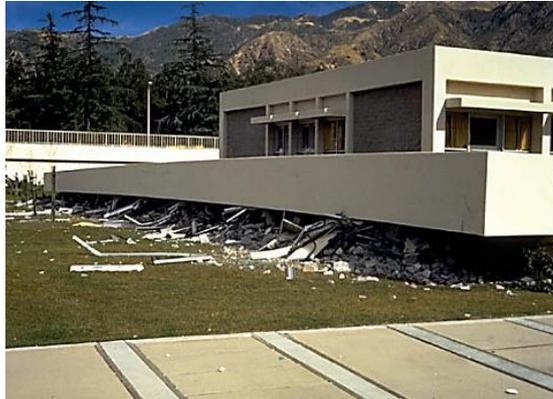
**Figura 12.** Collasso dell'ospedale Olive View
