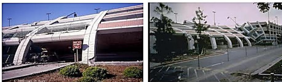
**Figura 18.** Collasso del parcheggio California State University
