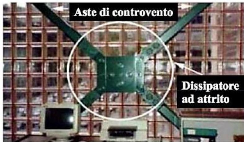
Figura 31. Esempio di applicazione dei Pall friction dampers in Canada [1]
