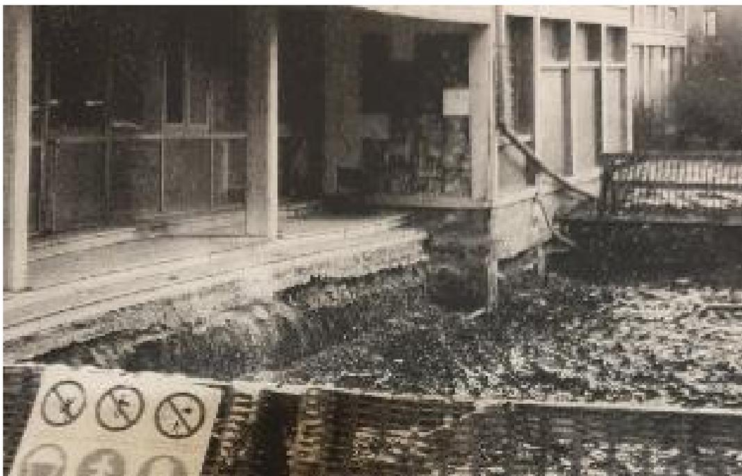
**Figura 44:** Foto scattata durante i lavori di scavo in cui non sono presenti opere di supporto [22].
