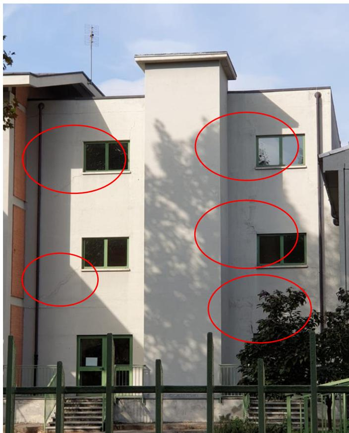
**Figura 59:** Stato fessurativo odierno della facciata lato cortile.
