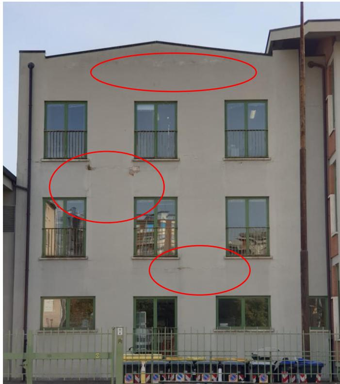
**Figura 58:** Stato fessurativo odierno della facciata lato via Frattini.
