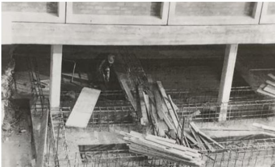
**Figura 40:** Fotografia scattata durante i lavori di costruzione delle fondazioni [22].
