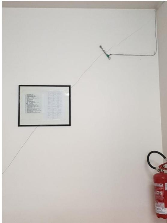
Figura 78: Fotografia della disposizione della fessura P1.
