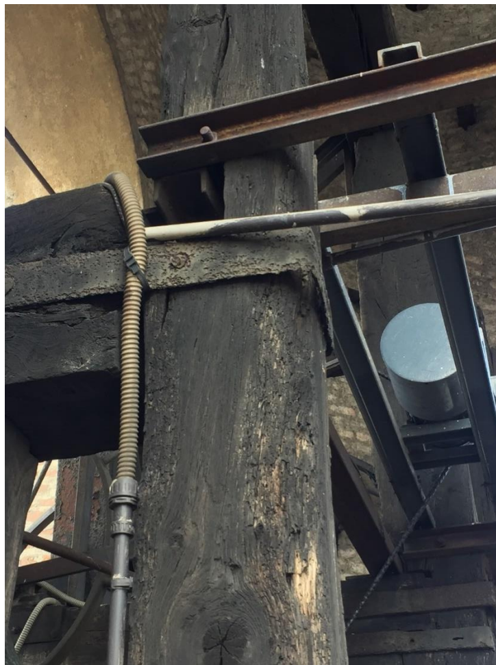
Figura 58. Profili metallici nel Ritto P8
