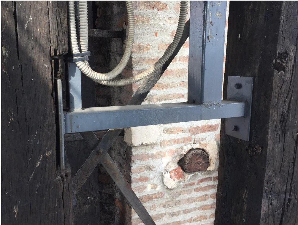
Figura 69. Struttura per il suono delle campane
