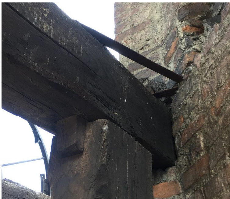
Figura 80. Collegamento del Traverso T5 con la muratura
