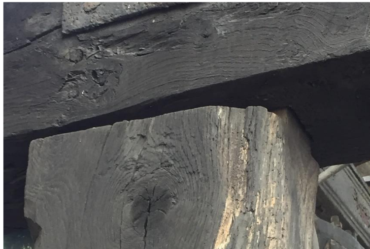
Figura 61. Collegamento a "tenone e mortasa" tra il Ritto P8 e il Traverso T9
