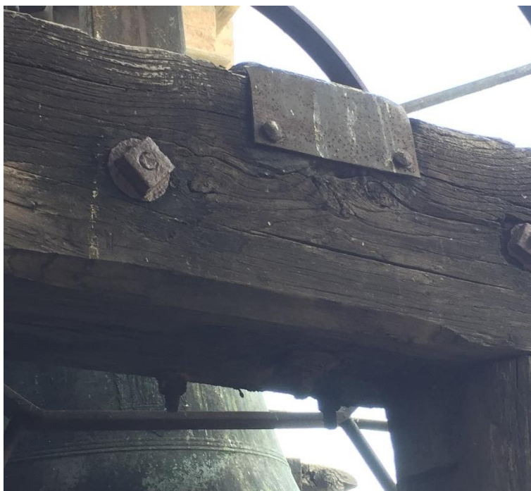
Figura 77. Piastra metallica per il collegamento del telaio della campana
