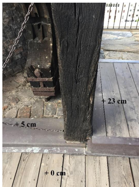
Figura 57. Quote di riferimento nella "Struttura a"
