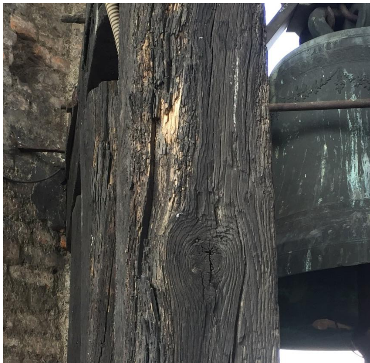
Figura 60. Degrado e nodo presenti nel Ritto P8
