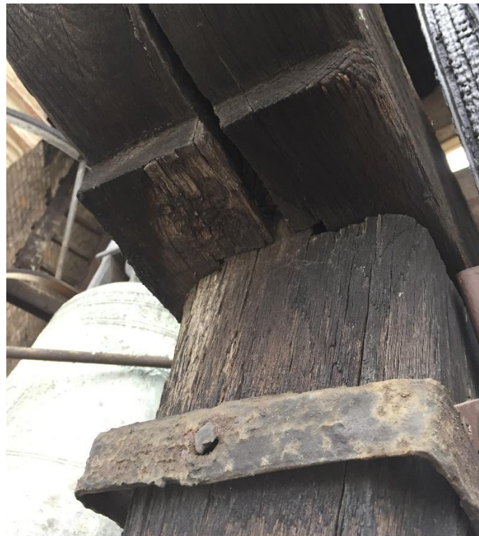
Figura 71. Collegamento a "tenone e mortasa" tra il Ritto P4 e il Traverso T3
