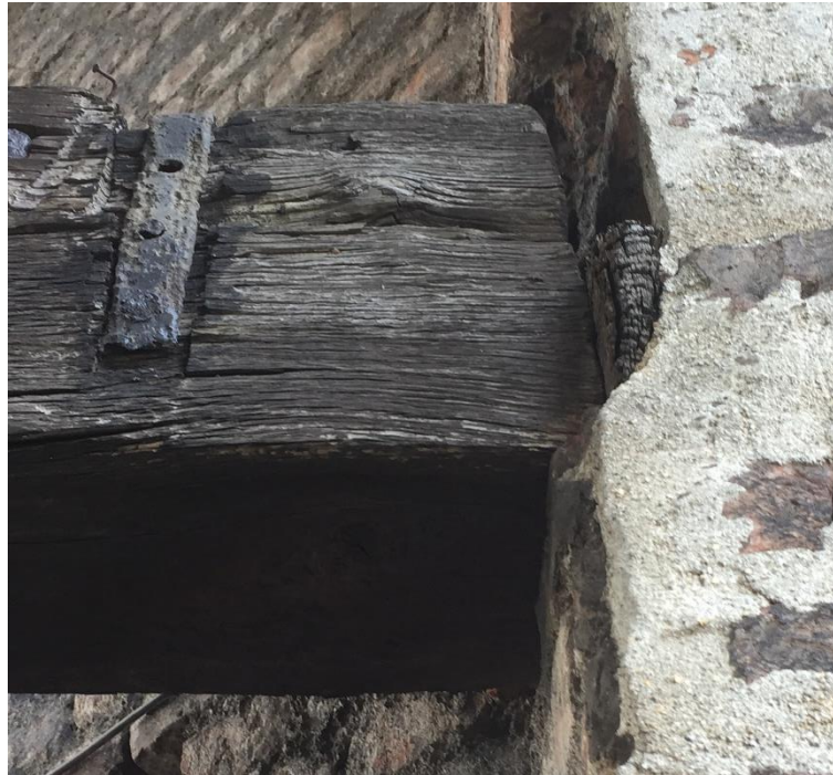
Figura 66. Ancoraggio alla muratura del Traverso T9
