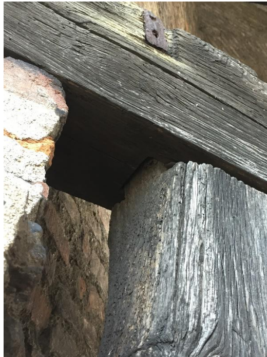
Figura 72. Collegamento a "tenone e mortasa" tra il Ritto P7 e il Traverso T5
