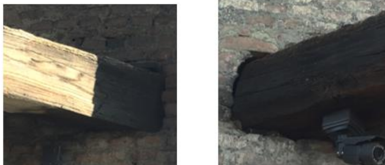
Figura 73. Ancoraggio alla muratura del Traverso T1
