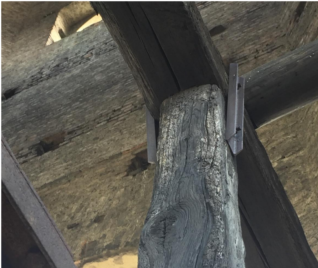
Figura 59. Degrado e nodo presenti nel Ritto P8
