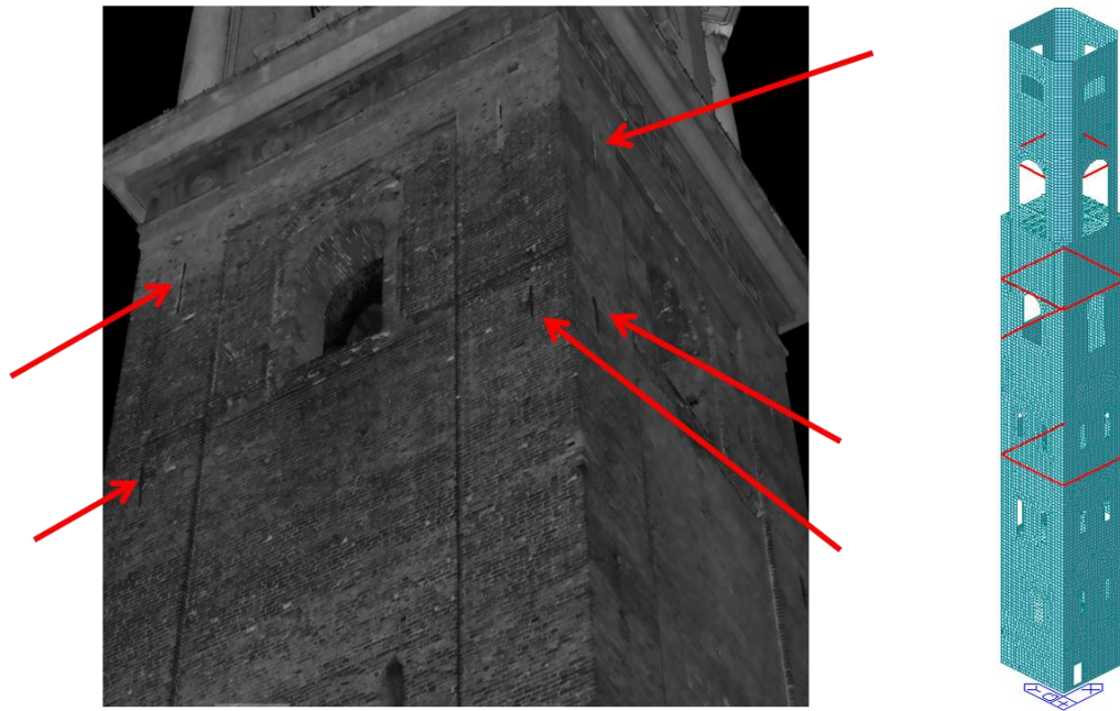
Figura 43. Capochiavi esterni e catene inserite nel modello
