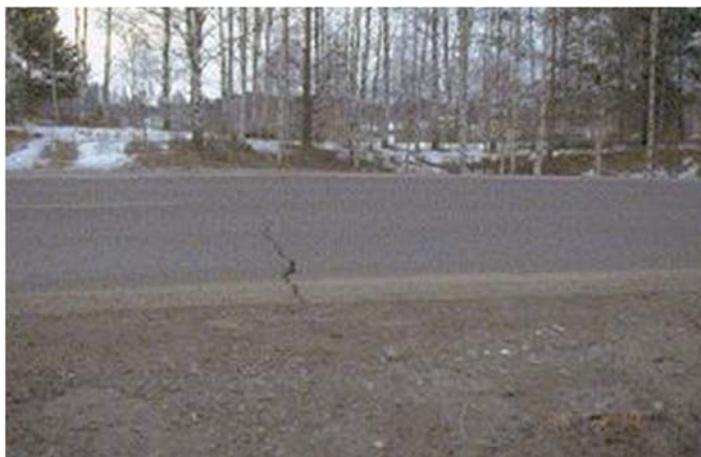
Figura 2.43 Fessura di origine termica
