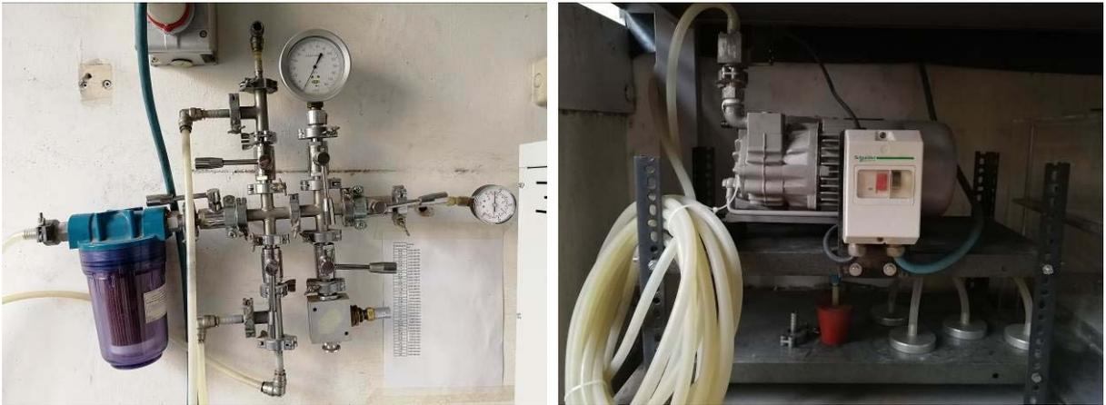
Figura 4.12 Pompa per il risucchio dell'aria
