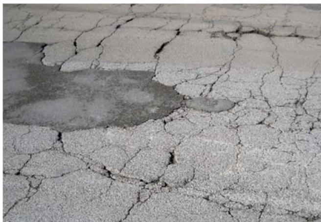
Figura 2.41 Tipica rottura a “pelle di coccodrillo”
