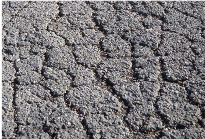
Figura 2.42 Rottura di tipo top-down
