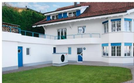
Risanamento dell'impianto di riscaldamento con un Belaria®twin A (17) installato esternamente
