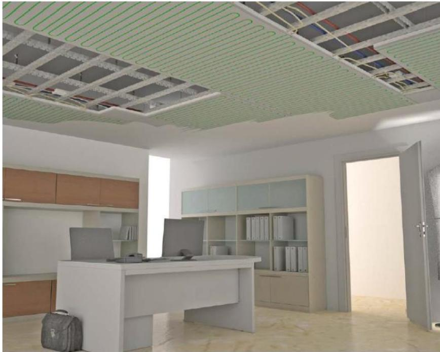
*Figura 20. Pannelli radianti a tubi capillari a soffitto*
