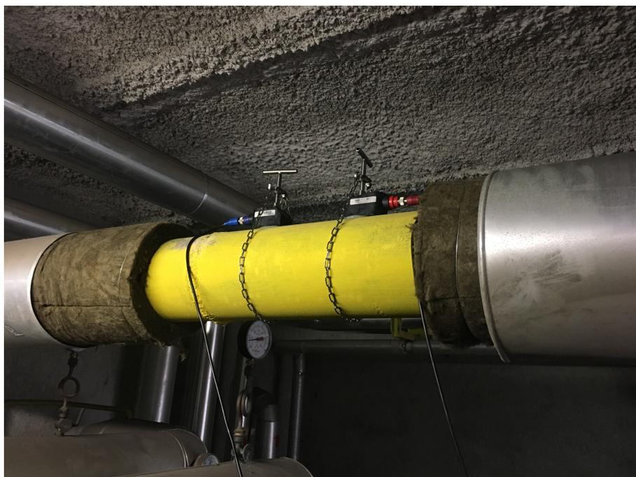
Figura 4.12: Applicazione misuratore di portata a ultrasuoni - tubo ritorno CT Seveso
