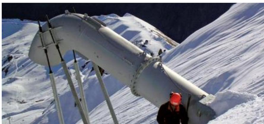
**Figura 2.9-Dettaglio barre metalliche di ancoraggio del Gazex**
