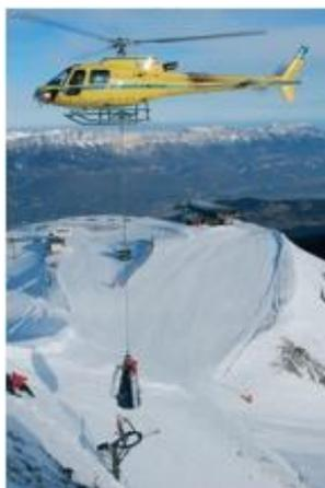
**Figura 2.14- Posa del sistema O’bellx tramite elicottero**
