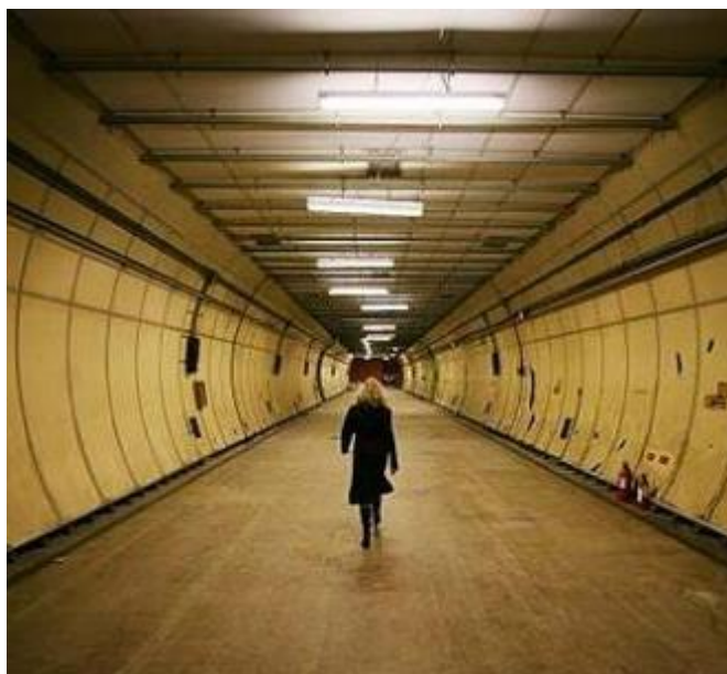
Figura 30 Esempio di collegamento pedonale. Si notino i dettagli dell'impiantistica di sicurezza come gli estintori sulla destra, l'illuminazione e i sistemi di allarme
