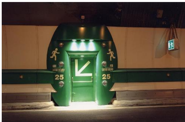
Figura 29 Esempio di uscita di emergenza
