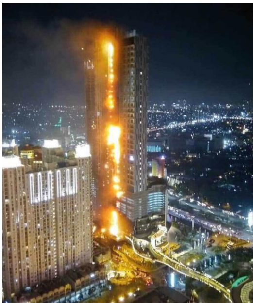
Figura 52 Propagazione di un incendio attraverso fiammate esterne nel grattacielo Neo-Soho a Jakarta (2016) (Reprinted with permission from MDM Publishing Ltd: Asia Pacific Fire Magazine April 2017 Issue 61)
