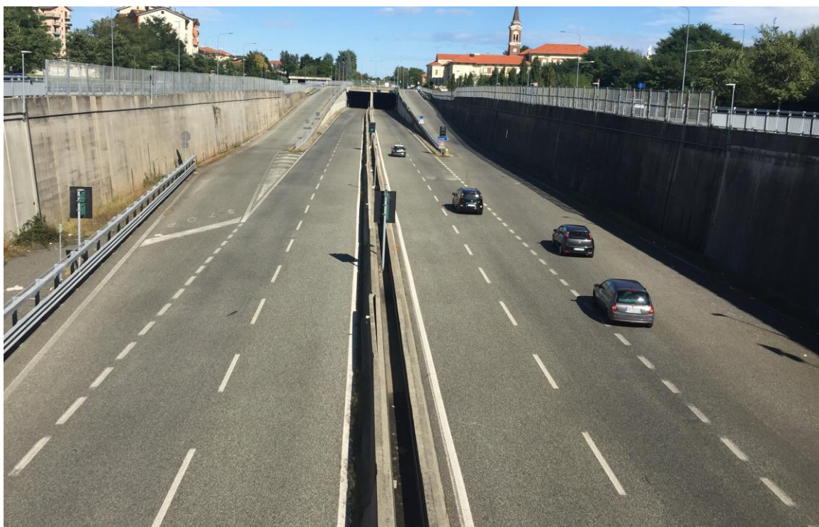
Figura 81 Foto della galleria San Maurizio (vista della zona a cielo aperto tra i due tratti di galleria, dove si possono notare le rampe di accesso ed uscita ad una sola corsia (non esistono altre rampe oltre quelle visibili dalla foto)).
