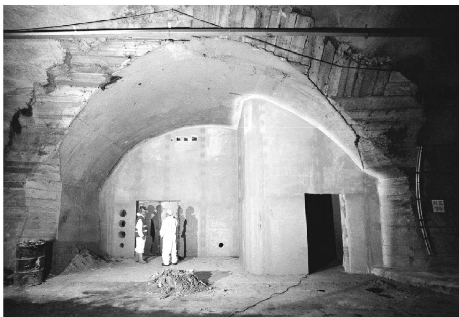
Figura 65 Montaggio del sistema FireBarrier a protezione dei supporti dei rifugi di emergenza della galleria del Monte Bianco durante la ristrutturazione (Carvel & Beard, 2005)
