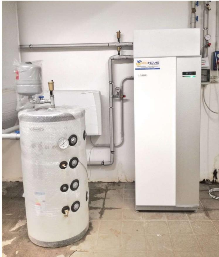
*Figura 49 – A partire da sinistra: il vaso di accumulo, il ventilconvettore e la pompa di calore*
