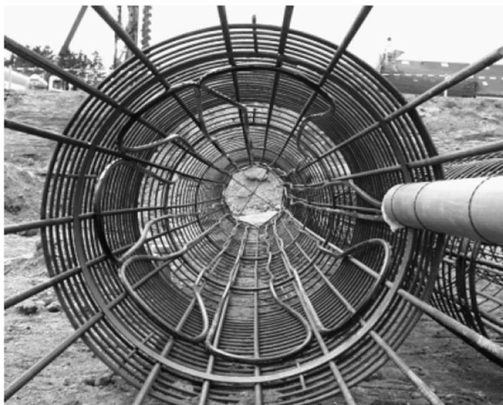
*Figura 21 – Esempio di disposizione delle tubazioni all'interno della gabbia di armatura dei pali energetici (Brandl, H., 2006)*
