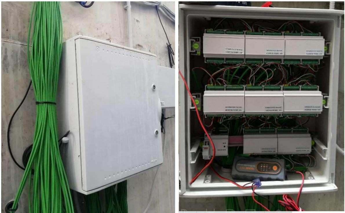
*Figura 48 – Unità di acquisizione dei dati*
