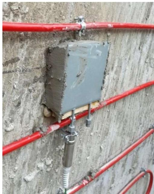
*Figura 45 Disposizione verticale delle celle di pressione*
