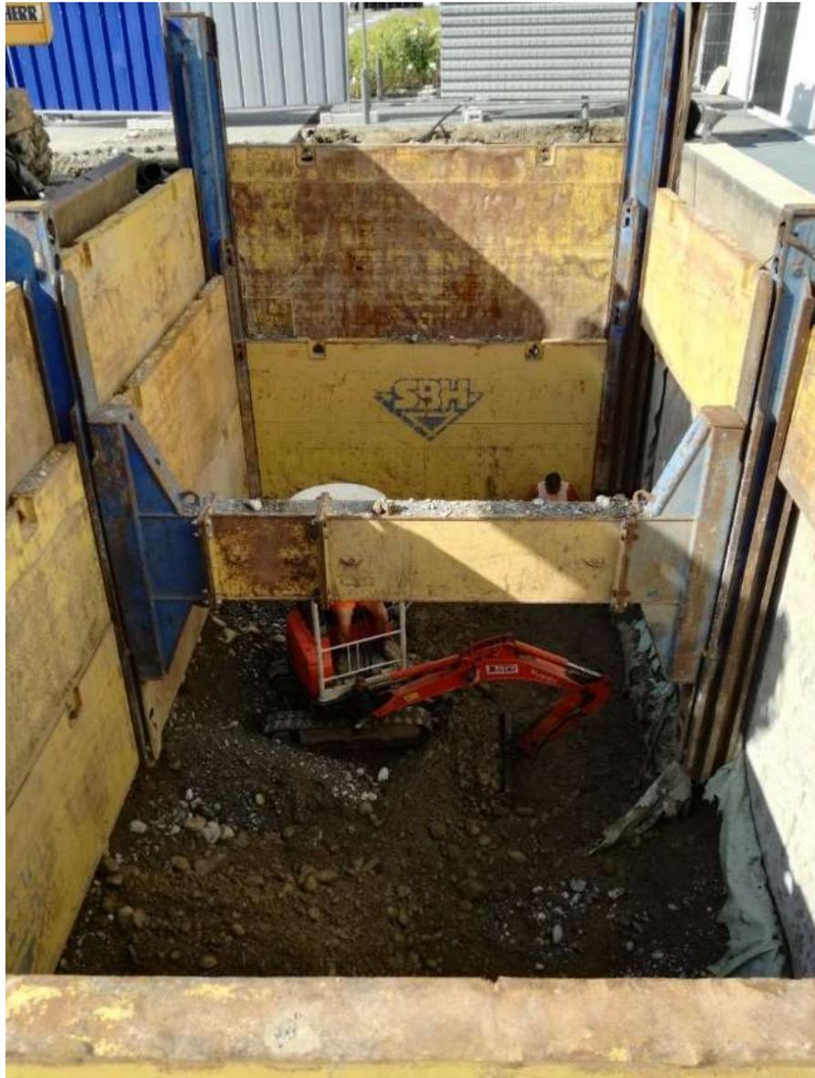
*Figura 35 – I sistemi di contrasto installati*
