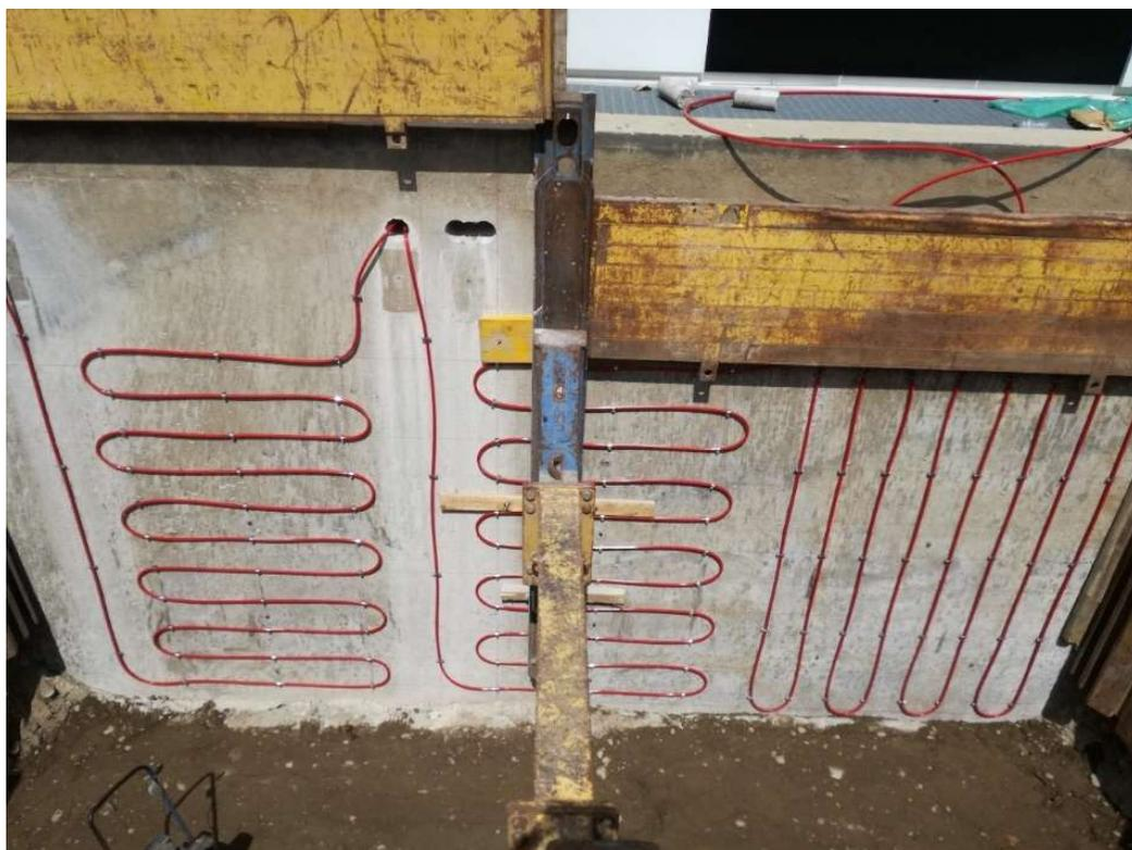
*Figura 37 – Sistemazione finale delle serpentine*
