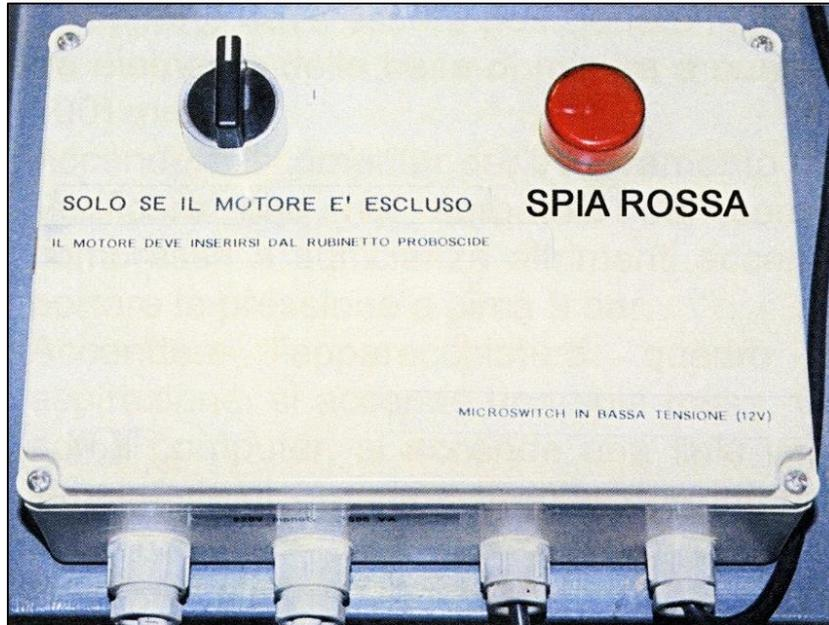
Figura 49. Quadro comando motore di aspirazione. Fonte: Manuale di uso e manutenzione. Allegato 1
