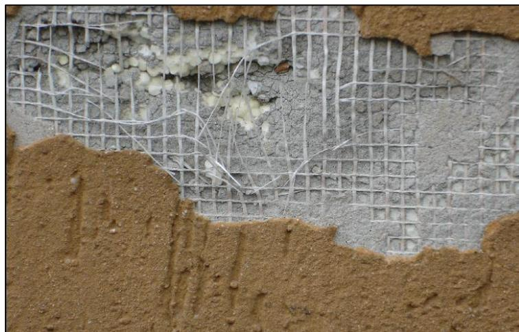
Figura 39. Rotture per urti accidentali o vandalici. Fonte: Re Cecconi F. e De Angelis E., *Guasti in edilizia*, Maggioli Editore, Rimini, 2010
