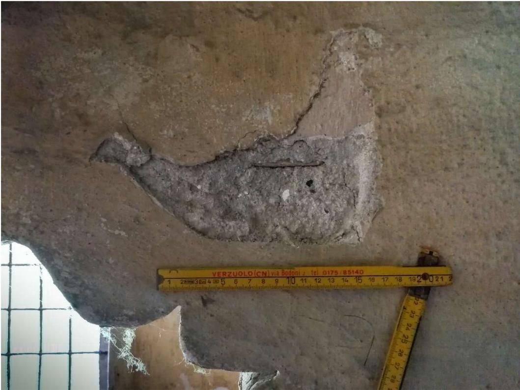
Fig. 47 - Particolare della mensola: è visibile l'estremità del travetto in legno
