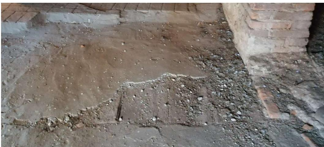
*Fig. 33 - Tracce rimanenti di un pavimento in legno nel sottotetto*
