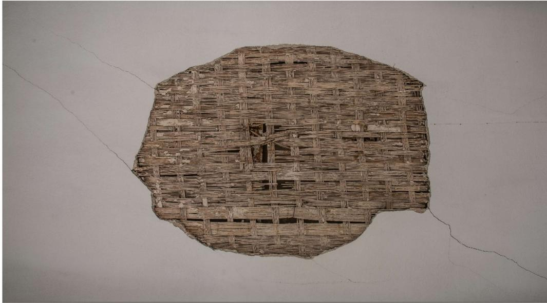
*Fig. 48 - Cannicciato presente al di sotto dell'orditura secondaria dei solai in legno*
