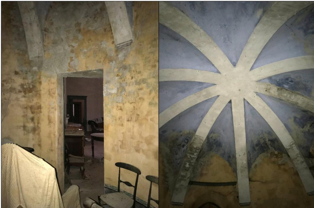
*Figura 78. Cono ottico 9. Vista su ingresso e volta a raggiera della torre.*
