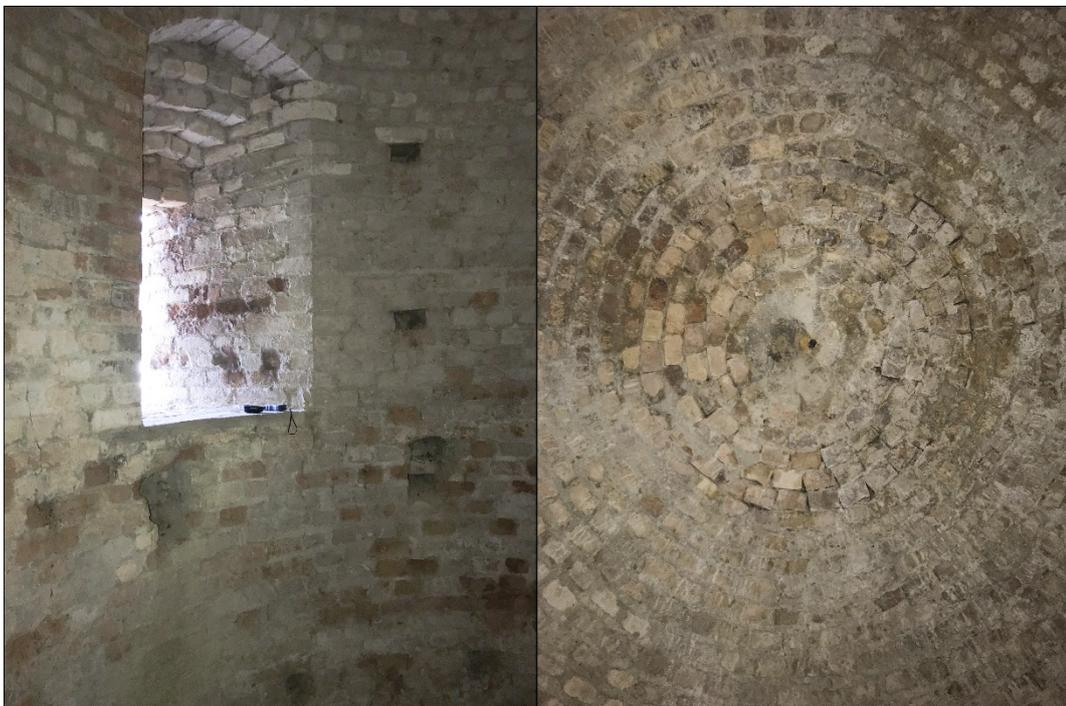
*Figura 44. Cono ottico 13. Vista su feritoia e volta a cupola del livello -2 della torre.*
