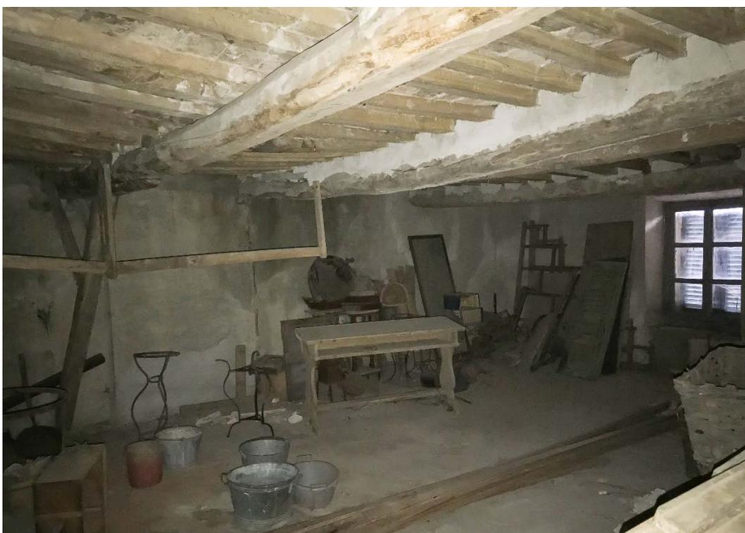
Figura 81. Cono ottico 12. Vista su locale con solaio ligneo imbarcato.
