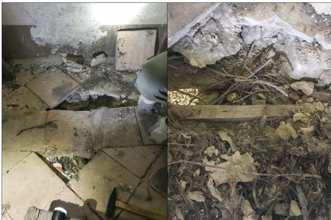
*Figura 109. Fase di rimozione mattonelle per indagare sul sottofondo e la catena metallica.*
