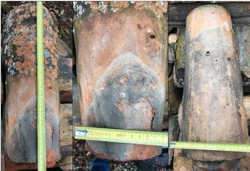
Figura 29. Coppi di copertura in laterizio.
