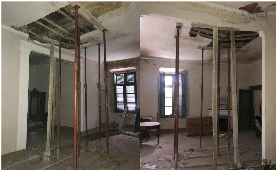
Figura 77. Cono ottico 7-8. Vista su porzione di catena lignea e controsoffitto degradati.
