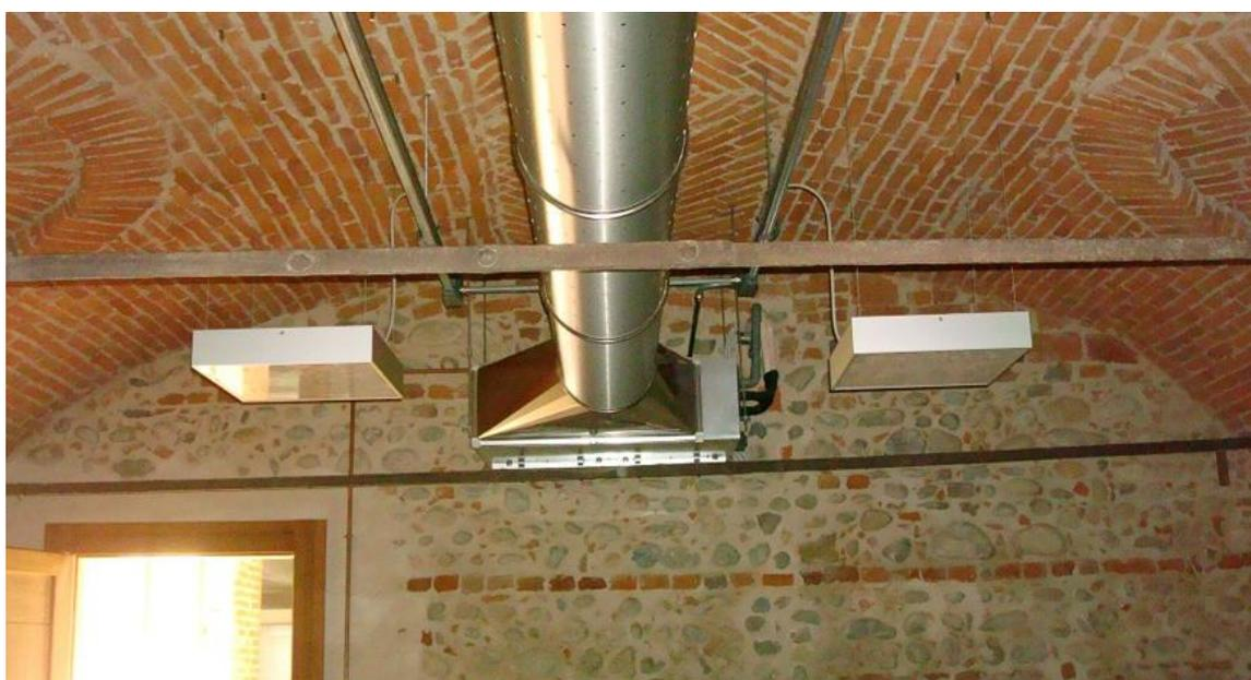
*Figura 76. Esempio di applicazione di un canale a vista in una struttura voltata.*
