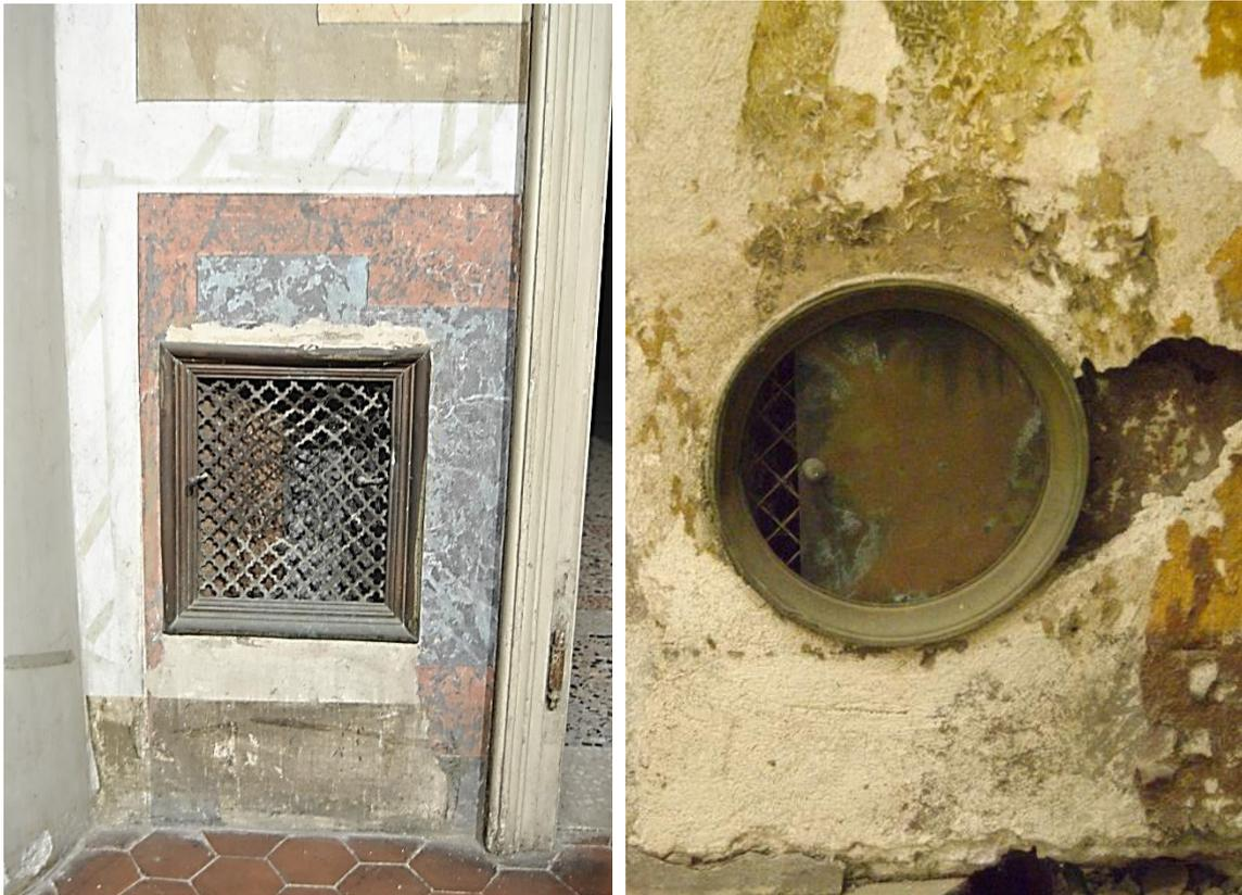
*Figura 61. Bocchette di distribuzione presenti in ambienti del Piano terra, dotate di serrande di regolazione.*
