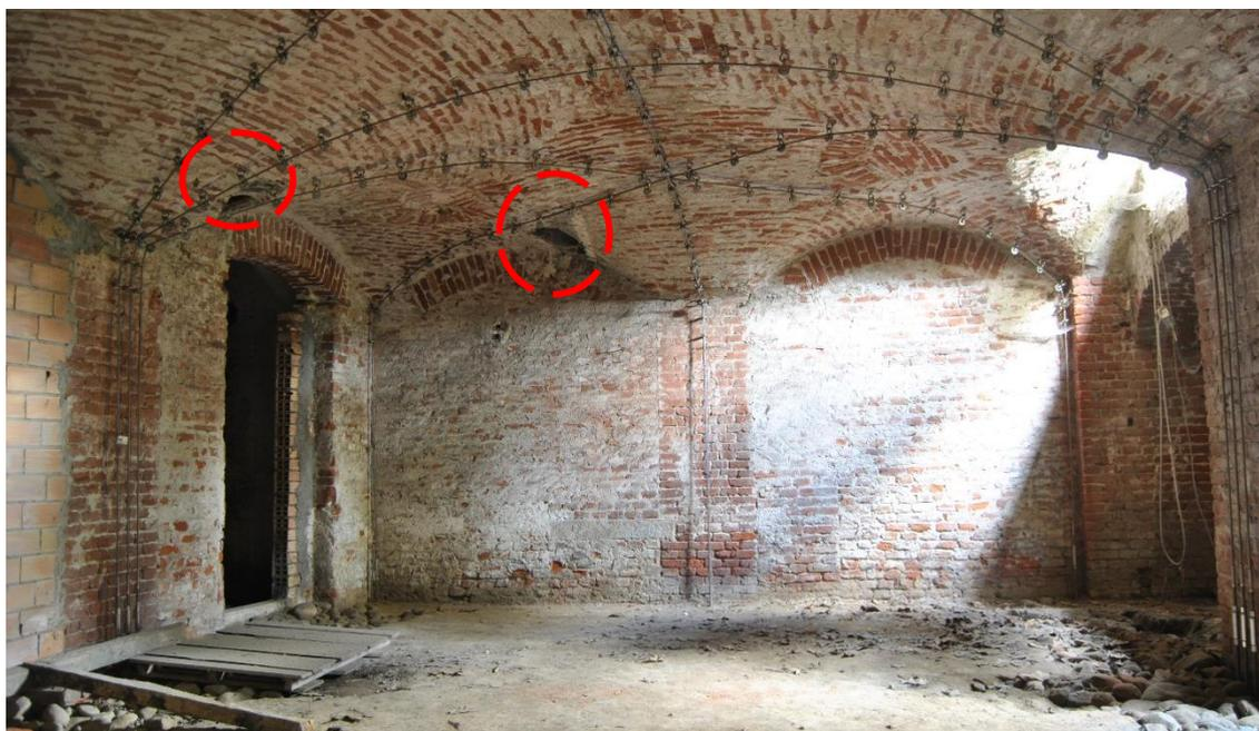
*Figura 66. Vista di un locale del piano cantinato. Sono evidenziati i fori di collegamento delle preesistenti canalizzazioni.*
