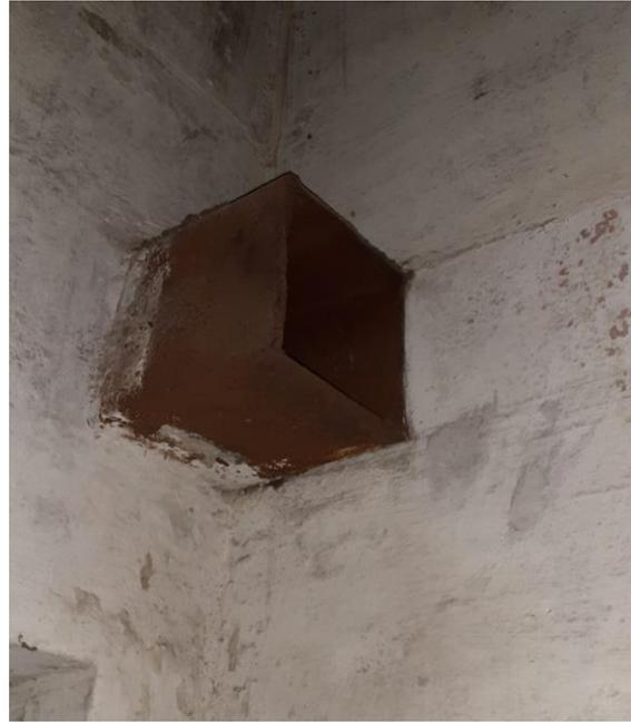
*Figura 65. Resti dell'originaria canalizzazione.*
