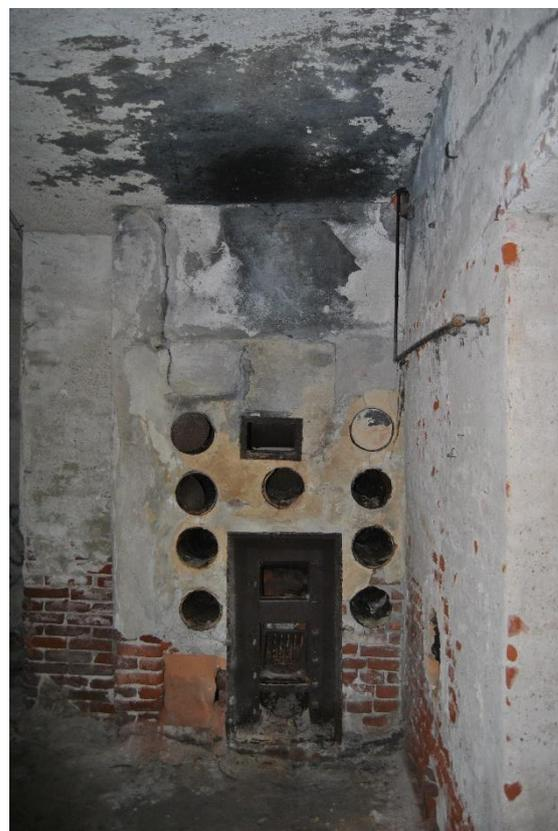
Figura 27. Una delle vecchie stufe per la produzione di aria calda.
