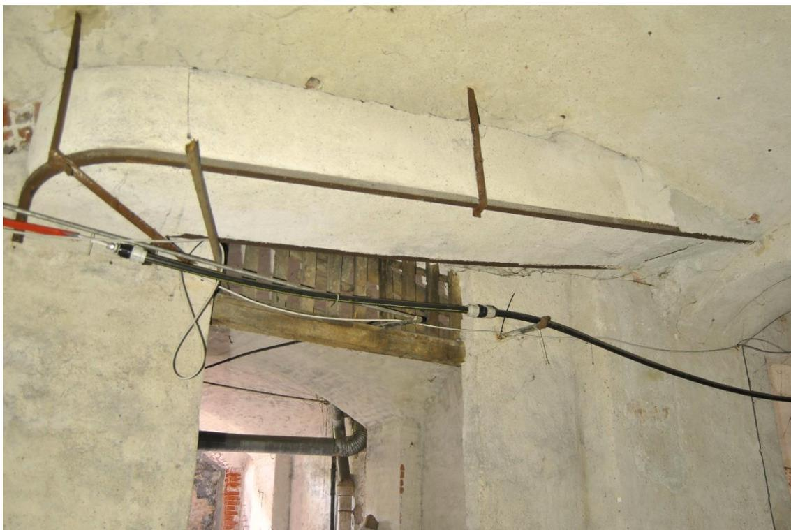
*Figura 60. Canale di distribuzione dell'aria calda.*
