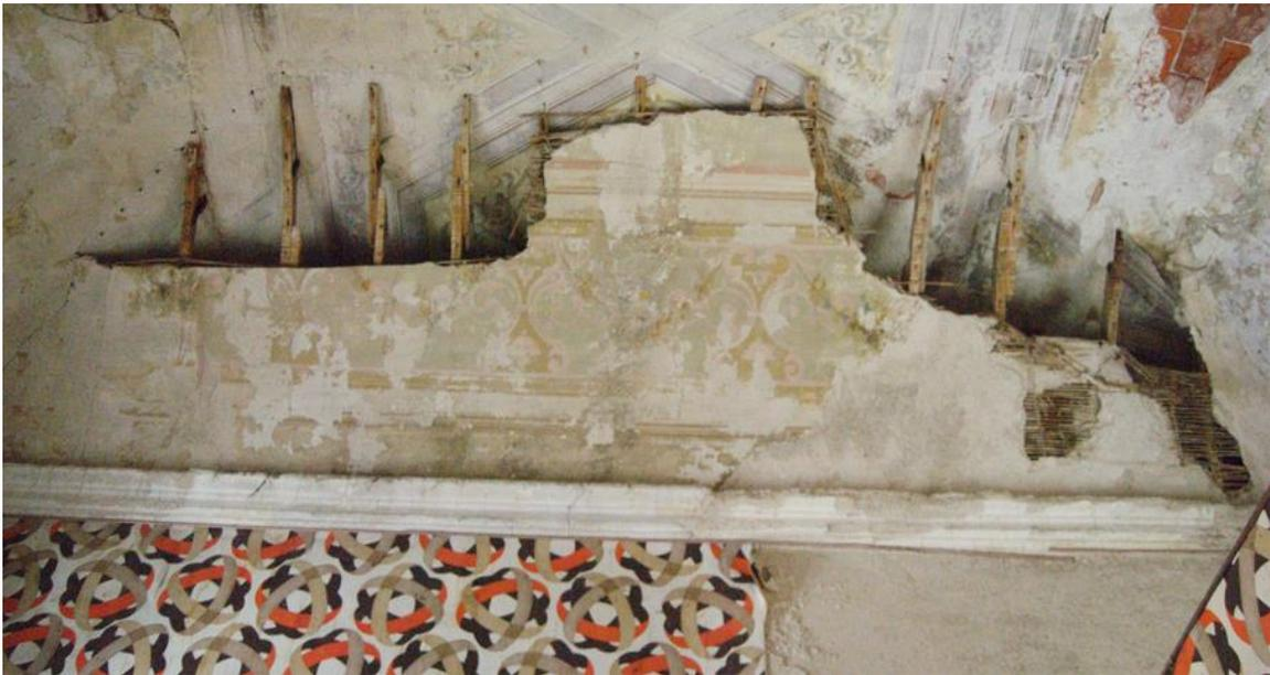
*Figura 12. Resti di una volta in cannicciato decorata, agganciata alla volta originale anch'essa decorata e parete con carta da parati applicata successivamente alla costruzione.*
