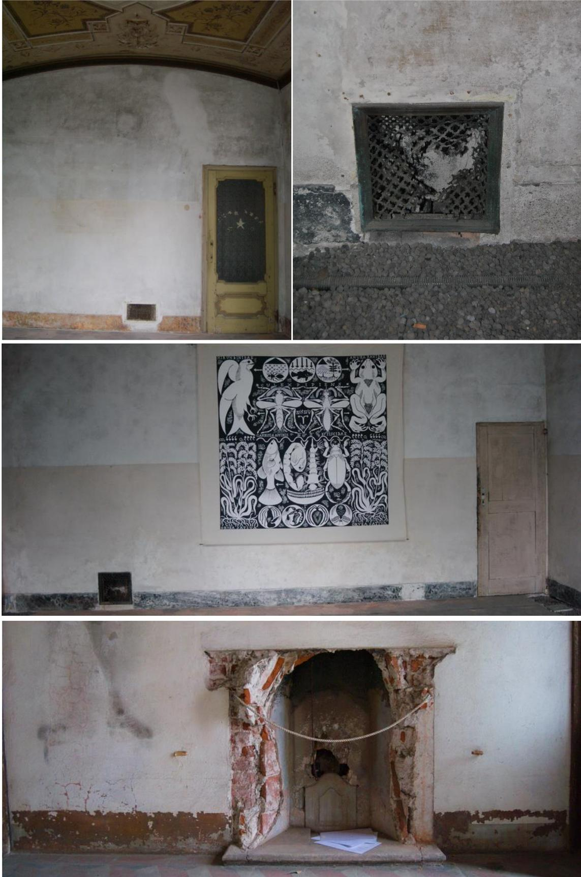
Figura 68. Terminali di distribuzione e di regolazione dell'aria primaria. Caminetto.
