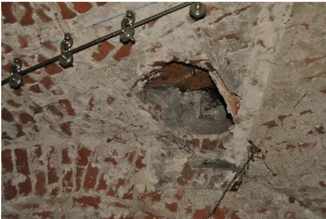
*Figura 59. Foro di collegamento per le canalizzazioni del sistema di riscaldamento ad aria.*
