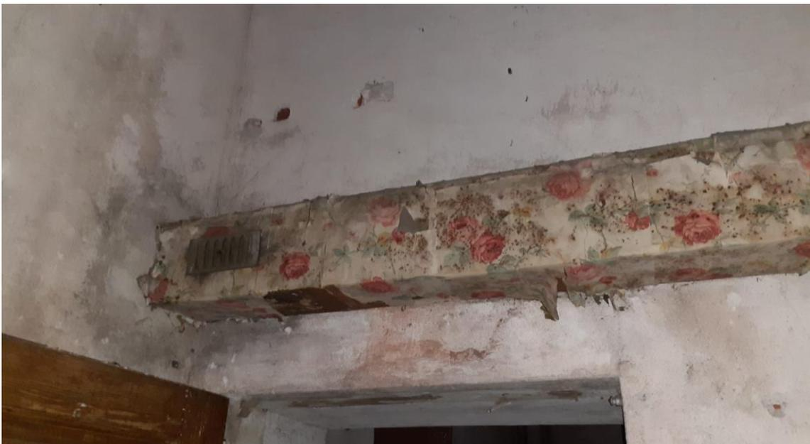
*Figura 62. Resti della originaria canalizzazione.*
