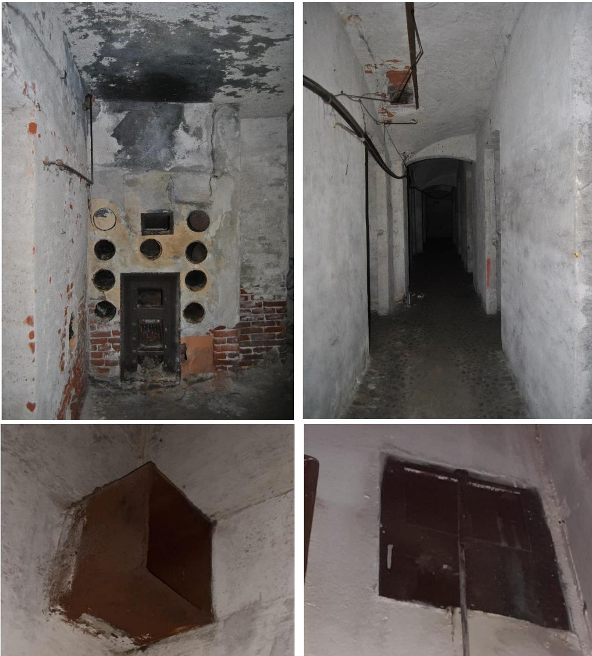
Figura 67. Calorifero. Elementi di distribuzione e di regolazione per l'aria primaria.
