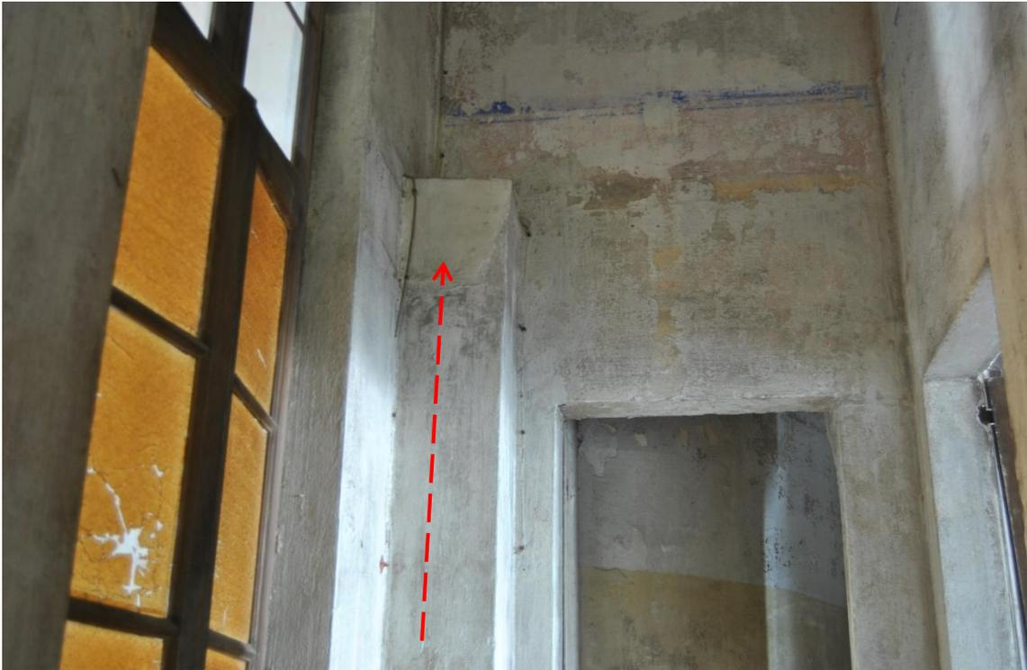
*Figura 63. Passaggio della originaria canalizzazione a vista.*
