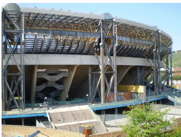
Figura 10: Scale di collegamento tra la zona spettatori e l'area di servizio annessa, fonte [16];
