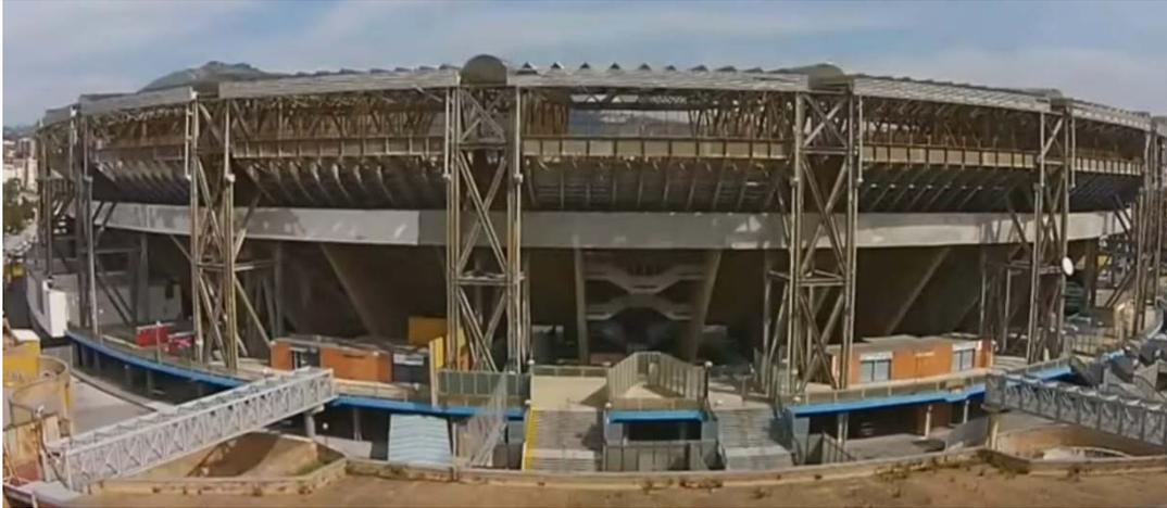
**Figura 3: Copertura metallica e terzo anello dello stadio San Paolo, fonte [15];**
