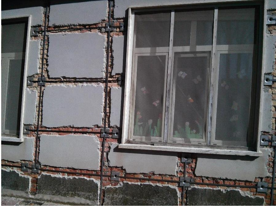
Figura 5-11: lavori di miglioramento sismico della Scuola Materna di Pianella, applicazione sistema CAM per rinforzo murario \_fonte Studio Ing. Di Cesare
