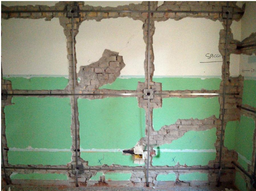
Figura 5-10: lavori di miglioramento sismico della Scuola Materna di Pianella, applicazione sistema CAM per rinforzo murario \_fonte Studio Ing. Di Cesare
