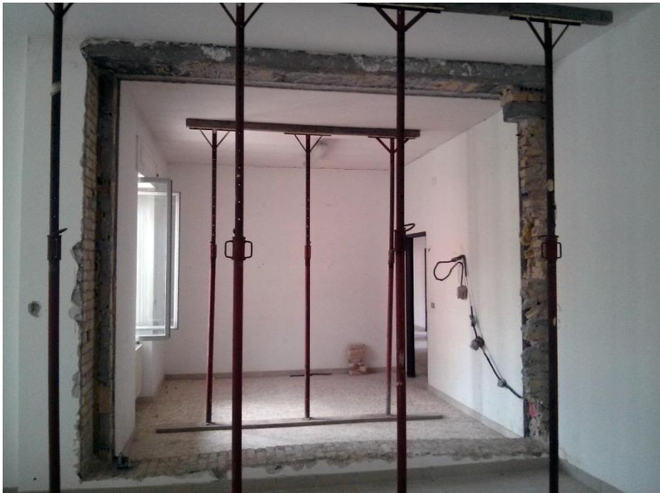
*Figura 5-16: lavori di miglioramento sismico della Scuola Materna di Pianella, puntellamento della parte interessata dalla scucitura \_fonte Studio Ing. Di Cesare*
