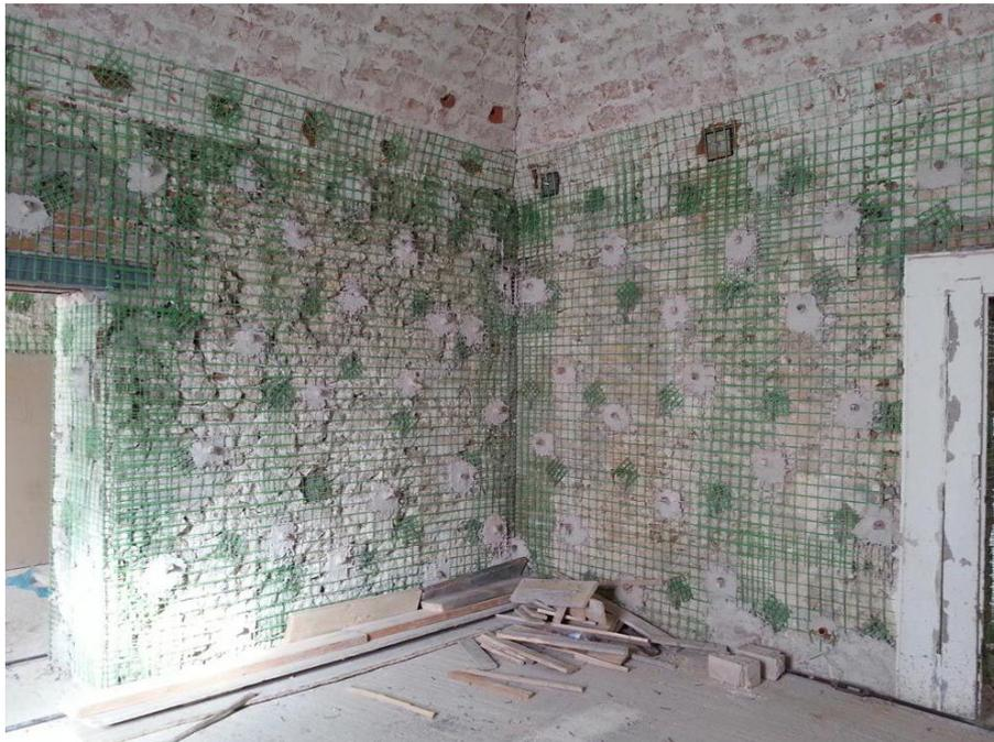
Figura 5-7: miglioramento sismico di un palazzo de l'Aquila mediante applicazione di
