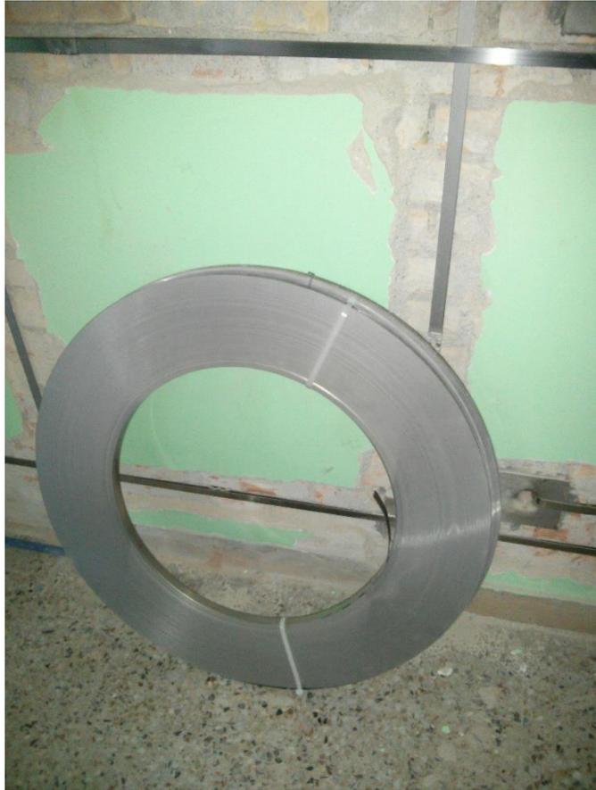
*Figura 5-12: lavori di miglioramento sismico della Scuola Materna di Pianella, bobina nastro in acciaio inox \_fonte Studio Ing. Di Cesare*
