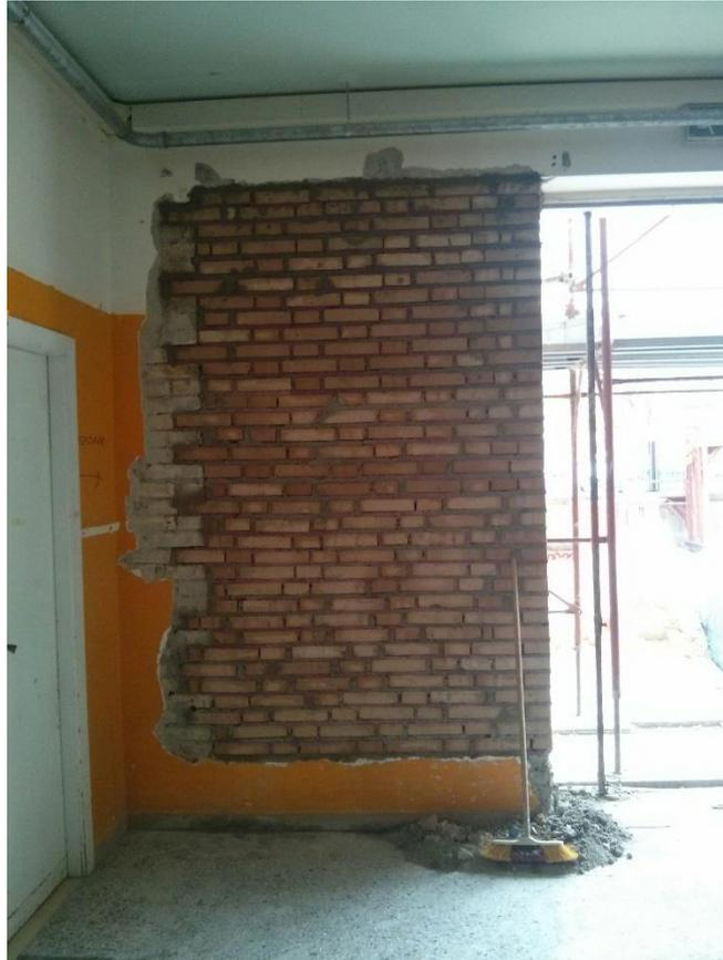
*Figura 5-15: lavori di miglioramento sismico della Scuola Materna di Pianella, chiusura porzioni murarie mediante tecnica del cuci-scuci \_fonte Studio Ing. Di Cesare*
