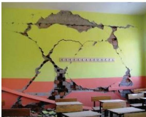
**Figura 7** - Danneggiamento nel piano di un muro interno dopo il terremoto del 2011 in Turchia<sup>11</sup>.
