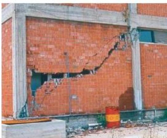
**Figura 8** -Danneggiamento nel piano di un muro esterno dopo il terremoto del 1998 in Turchia<sup>12</sup>.
