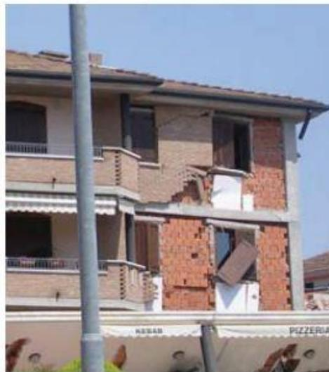
**Figura 11** – Danneggiamento fuori dal piano di un muro esterno dopo il terremoto del 2012 in Emilia.<sup>19</sup>
