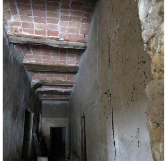
*Fig.36 –Intradosso solaio in legno voltine al piano terra (D01)*
