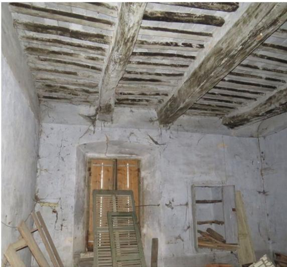
Fig.39 –Intradosso solaio in legno a doppia orditura e pianelle al piano terra(V04)
