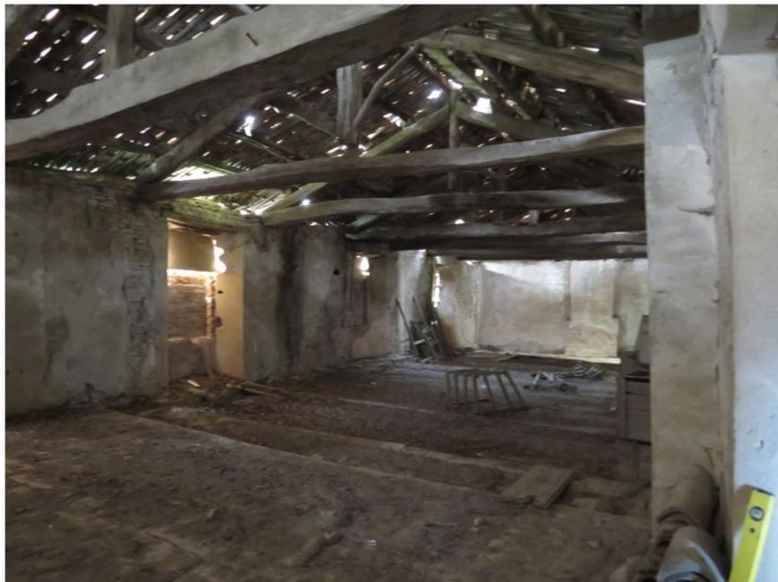
*Fig.48 –Capriate del corpo di fabbrica principale (V19)*
