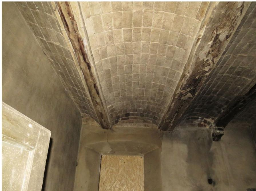
*Fig.37 –Intradosso solaio in legno e voltine di mattoni pieni in foglio al piano terra (V03)*
