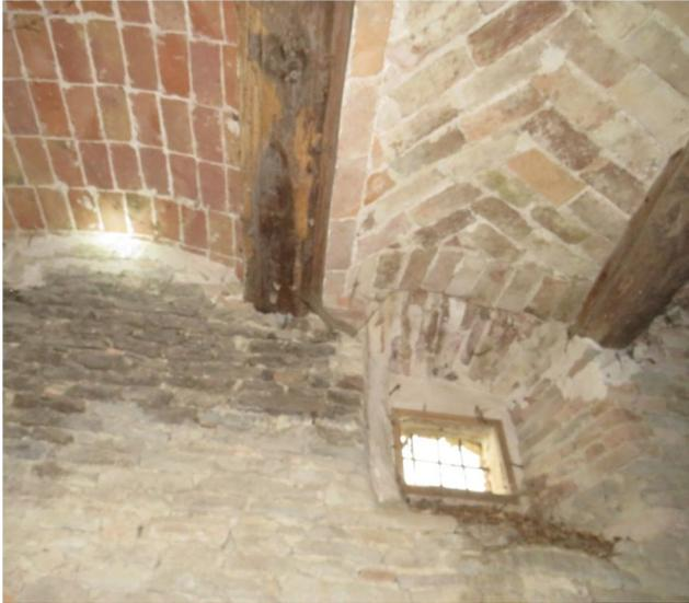
*Fig.35 –Intradosso solaio in legno (posate con diagonale verticale) e voltine in mattoni al piano seminterrato*
