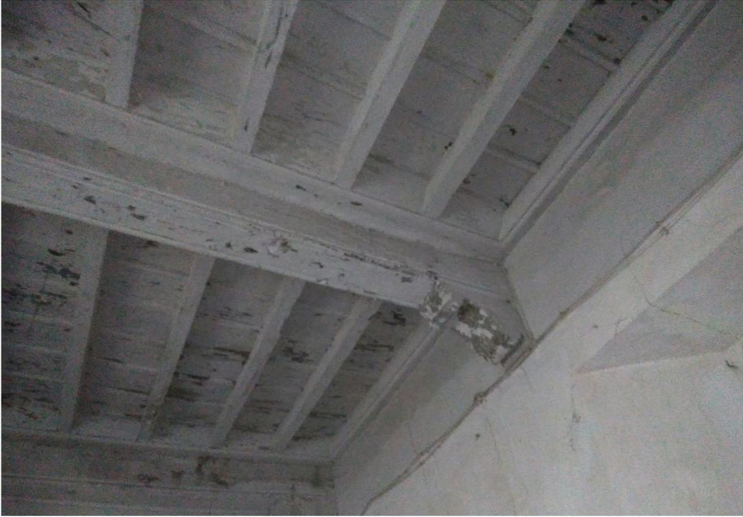
Fig.43 –Intradosso solaio in legno a cassettoni al piano terra
