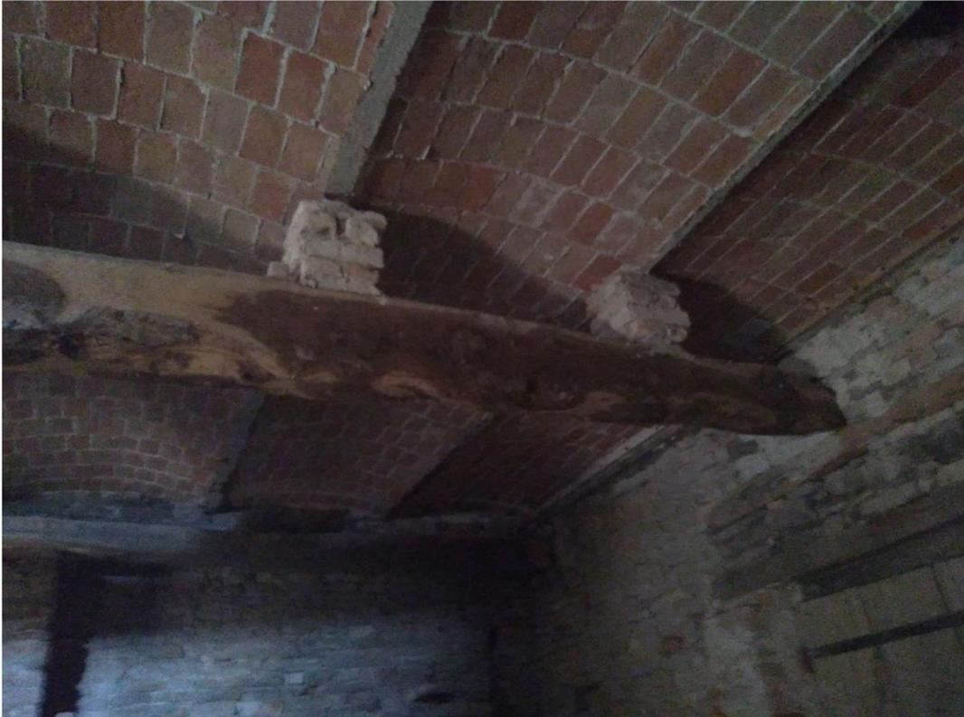
*Fig.45 –Intradosso solaio in putrelle e voltine in mattoni al piano seminterrato*
