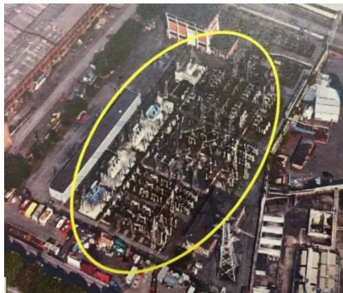
Figura 17 Impianti di trasformazione dell'energia elettrica
