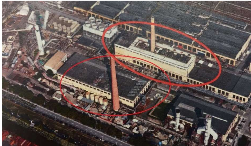
Figura 6 Centrali termiche di alta e media pressione
