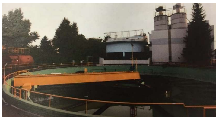
Figura 12 Vasca di sedimentazione con raschiatore
