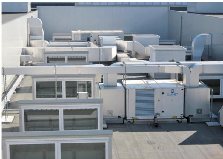
**Figura 4.4.2** – Centrale frigorifera sulla copertura di un centro commerciale
