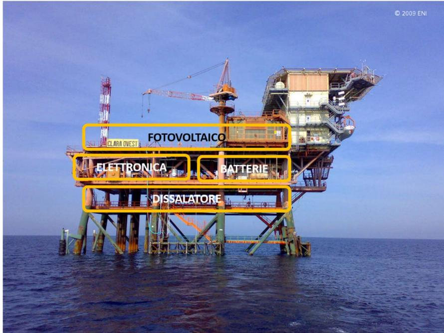
*Figura 1. Disposizione impianto su Clara ovest [4]*
