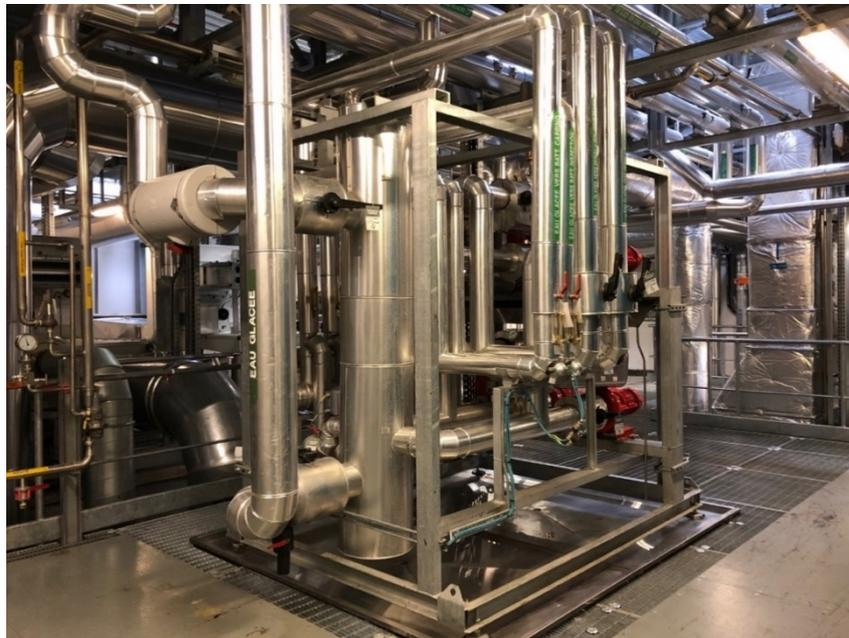
Figura 20: Separatore idraulico linea 1 e 2
