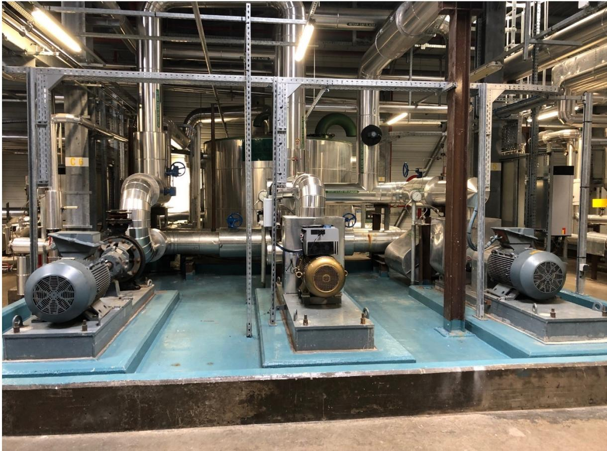
Figura 12: Circuito secondario, separatore idraulico e pompe
