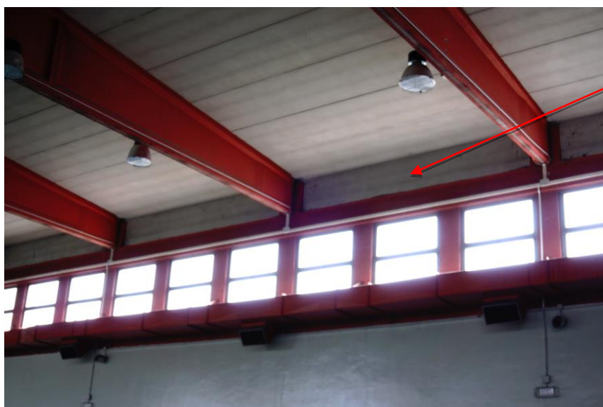
Figura 82. Calcestruzzo gettato in opera per muri perimetrali
