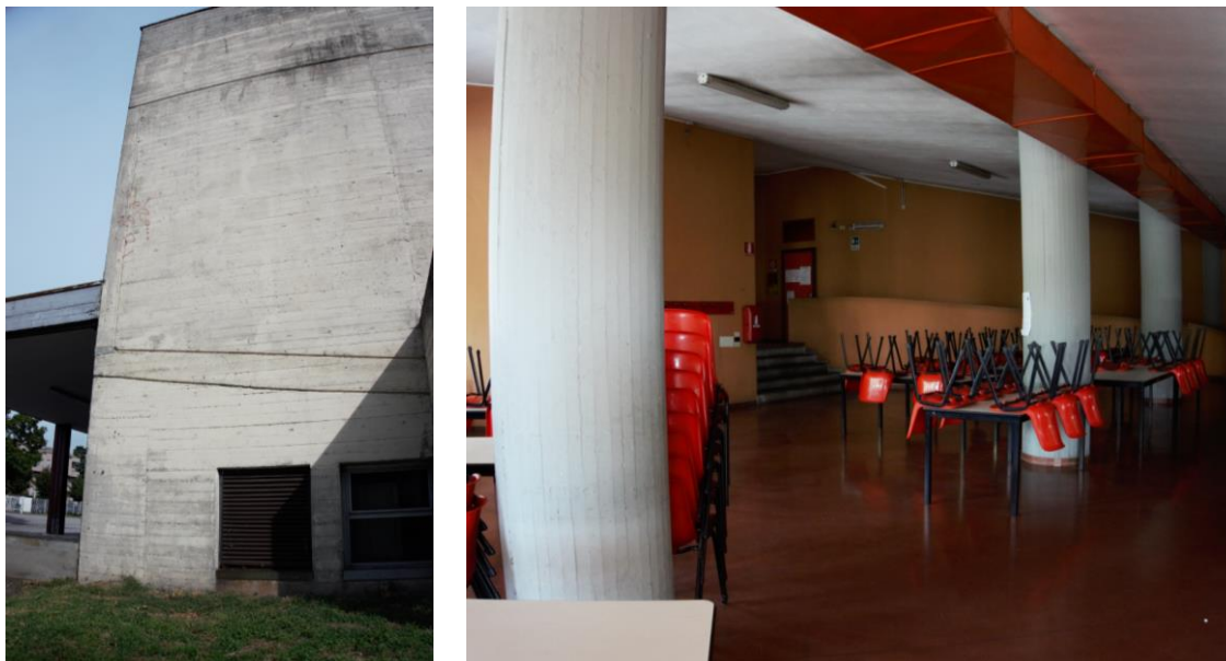
Figura 30. (a) Particolare del solaio inclinato della mensa; (b) colonne che portano il solaio inclinato
