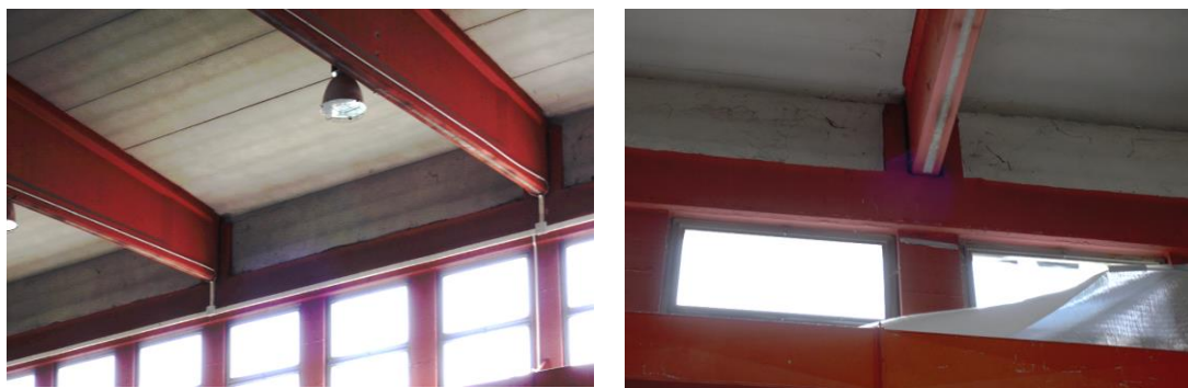
Figura 58. Particolare appoggio trave su pilastri perimetrali
