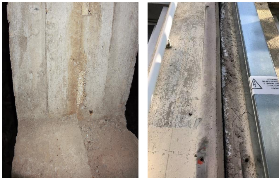
Figura 28. Giunti di espansione riempiti con polistirolo
