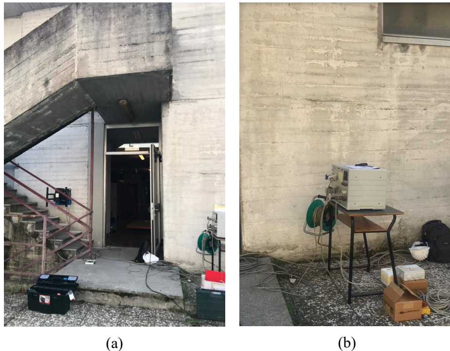
Figura 51. (a) Posizionamento vibrodina VTE 40K; (b) centralina di controllo
