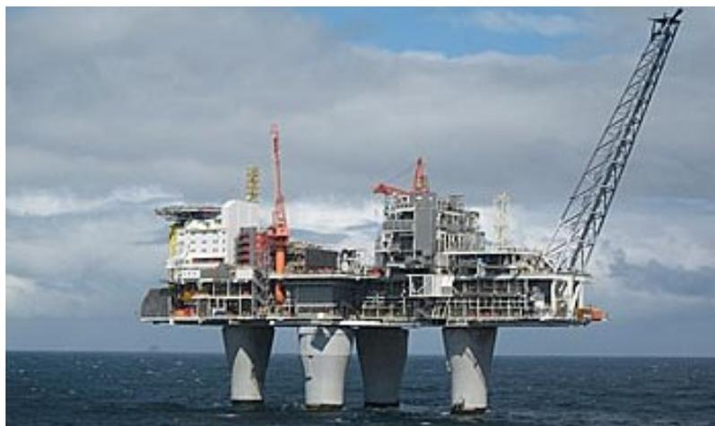
*Figura 3 Le condizioni operative e ambientali associate ad una piattaforma offshore fanno sorgere molti dubbi sulla realizzazione di un sistema di SHM*
