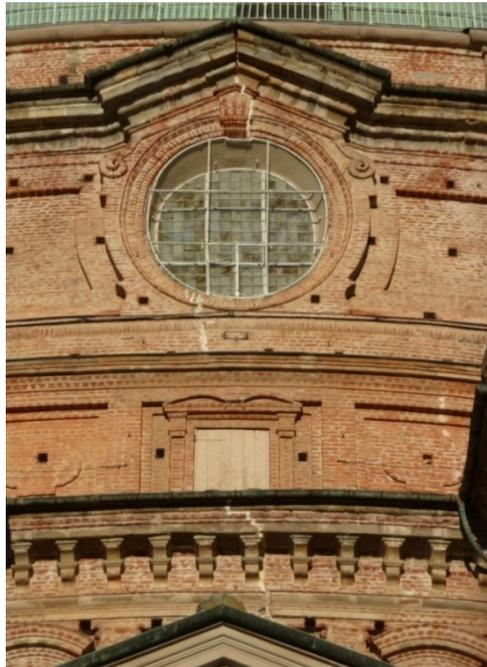
*Figura 12 Visuale esterna della fessura ad ovest*
