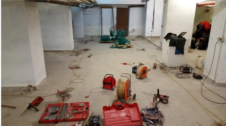
**Fig. 41: Foto dell'ubicazione degli elettrodi per l'ERT1 eseguita nel piano cantinato.**
