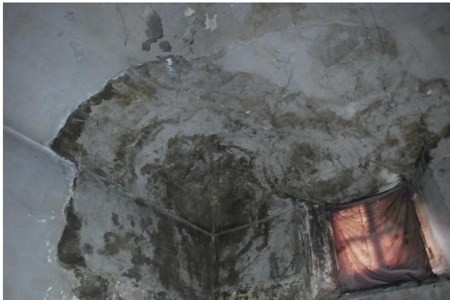
*Figure 1-26: danno infiltrazioni angolo facciata-via trevigi*
