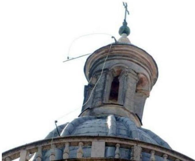
*Figure 5-34: dettaglio lesioni orizzontali nei pilastrini*
