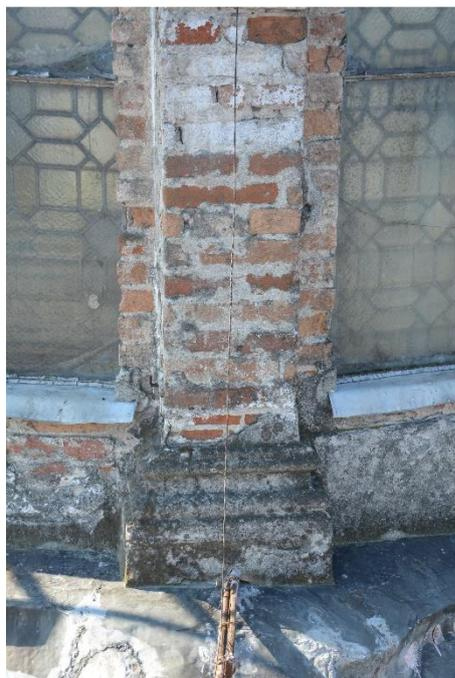
*Figure 1-20: pilastrino lanterna degrado della muratura*
