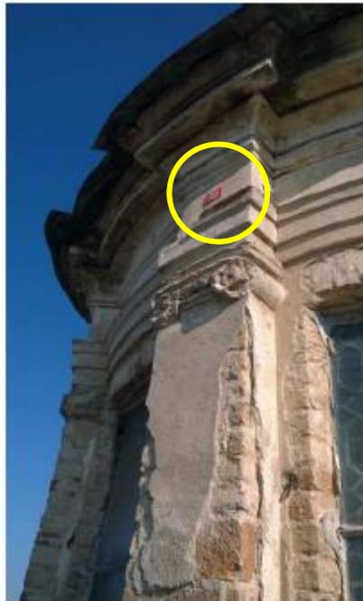
*Figure 1-37: particolare posizionamento target top pilastro lanterna*
