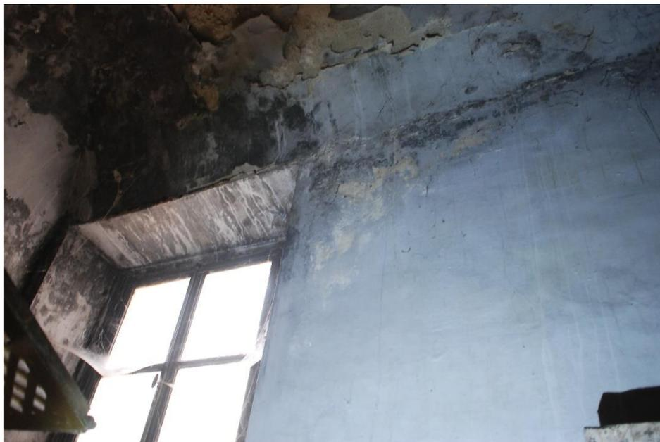
*Figure 8-14: degrado interno intonaci*
