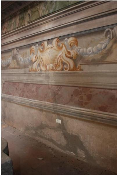
*Figure 1-13: fessura subverticale piano matroneo in corrispondenza della facciata*
