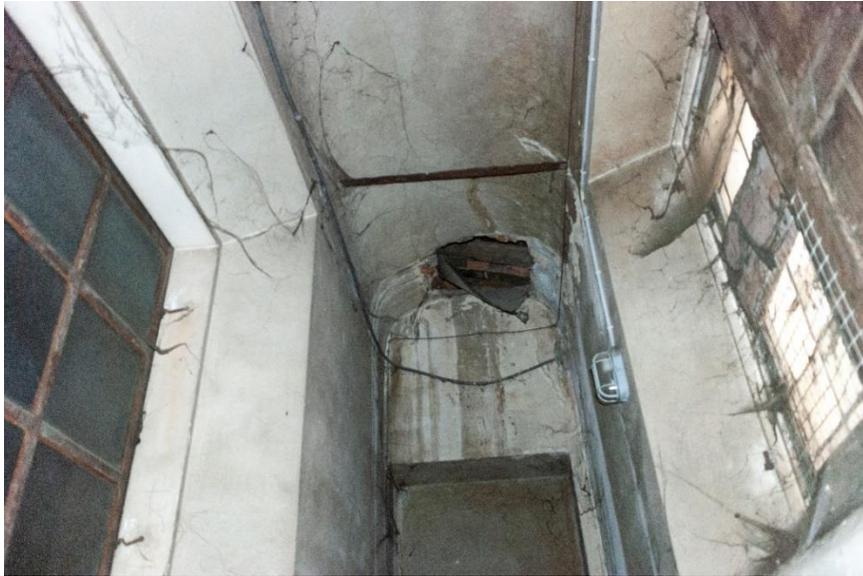
*Figure 1-25: danneggiamento intonaci interni per le infiltrazioni*
