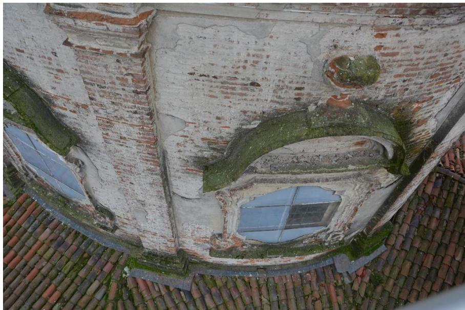
*Figure 1-19: esterno tamburo, degrado muratura*
