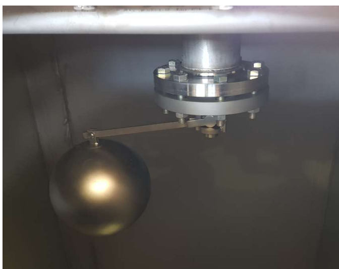
Figura 39: valvola a galleggiante
