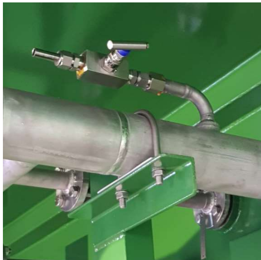
Figura 38: Needle valve di sfiato
