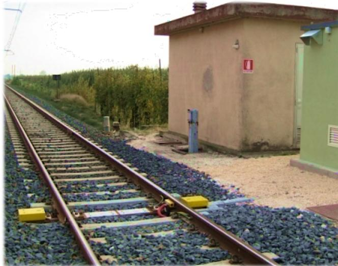
**Figura 1.7** – Modulo PdR di un moderno sistema RTB [7]
